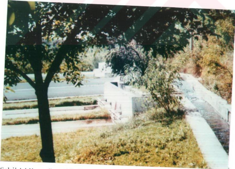
Şekil 4.4 Karasalkım alabalık tesisi havuzlarının su giriş sistemi.
