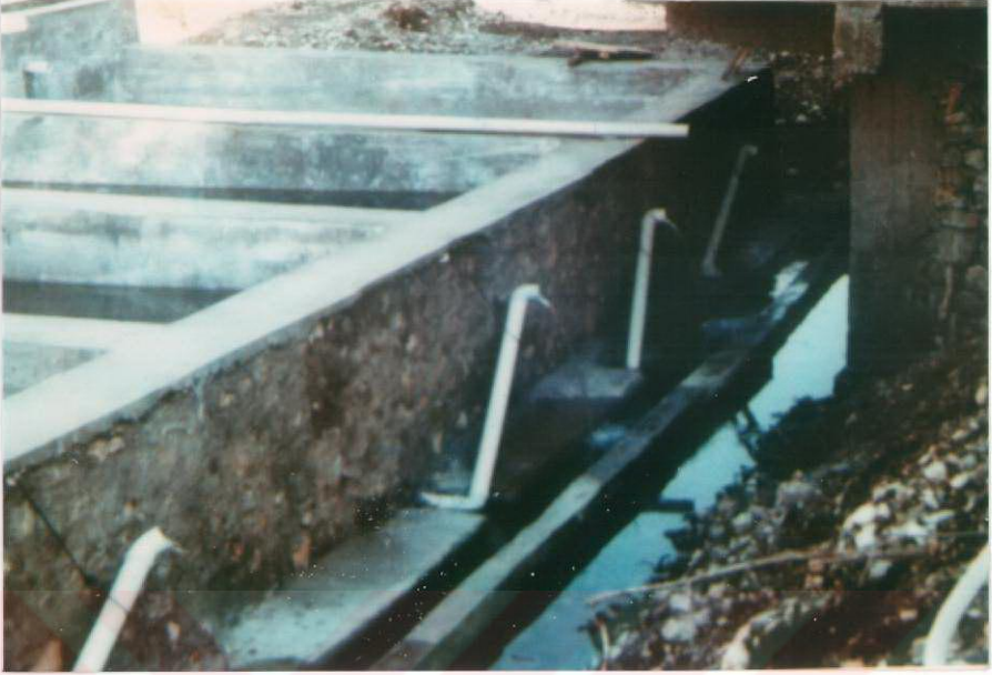
Şekil 4.10 Kekikpınar alabalık tesisi, beton havuzları.
