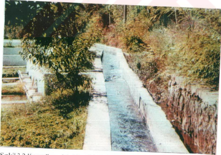
Şekil 3.2 Karasalkım alabalık tesisi (Palu, Elazığ).
