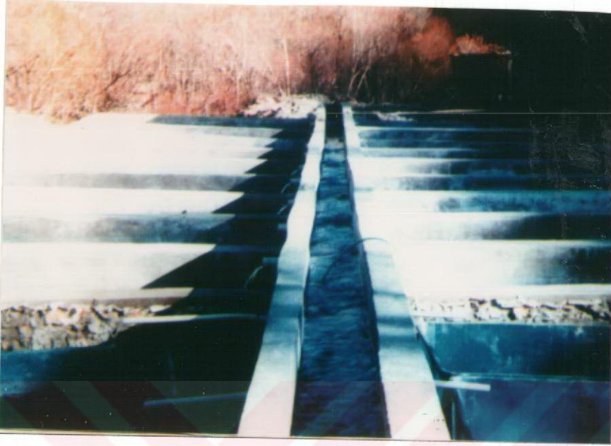
Şekil 3.5 Kekikpınar alabalık tesisi (Kemalîye, Erzincan).
