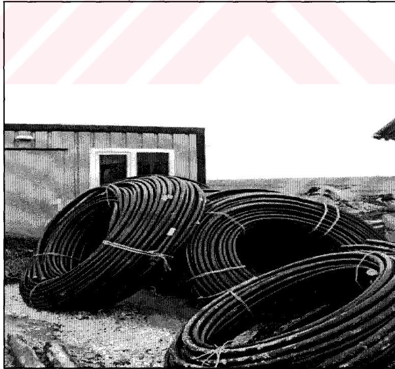
Şekil 4.29. İstanbul Hadımköy SAN 1 Konakları GSHP's uygulamaları için kullanılan poli-etilen "U" borulardan bir görünüm
