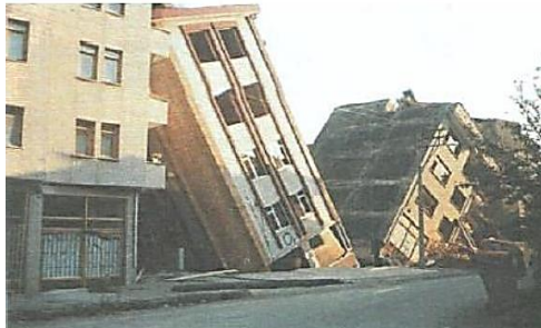
Şekil 2.27. Taşıma gücü kaybı sonucu yan yatan bir bina Gölçük Türkiye-1999 (Doğan, 2015).
