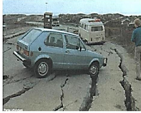
Şekil 2.32. Nisqually A.B.D. – 2001 depremi sonucu meydana gelen yanal yayılma örneği (Doğan, 2015).
