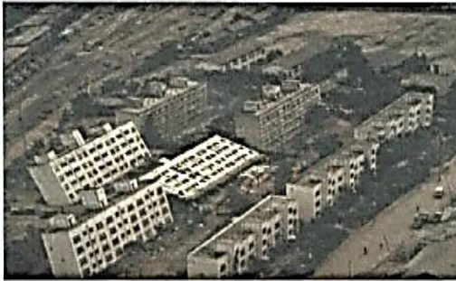
Şekil 2.28. Niigata Japonya-1964 depremi sonucu taşıma gücü kaybına uğramış zemin sonucu devrilen binalar (Doğan, 2015).
