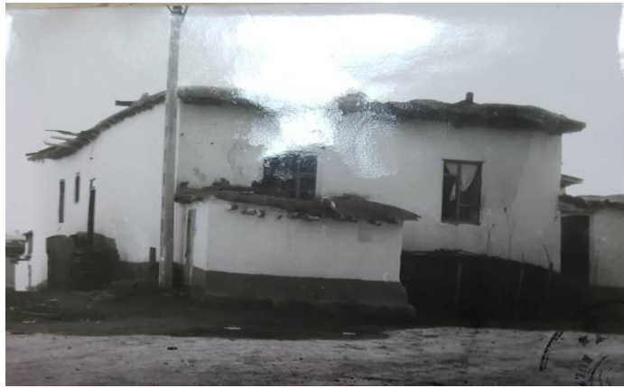
Şekil 3. 26. Dolaşıklar evi düz toprak çatı ve saçakları (Koruma Kurulu Arşivi)
