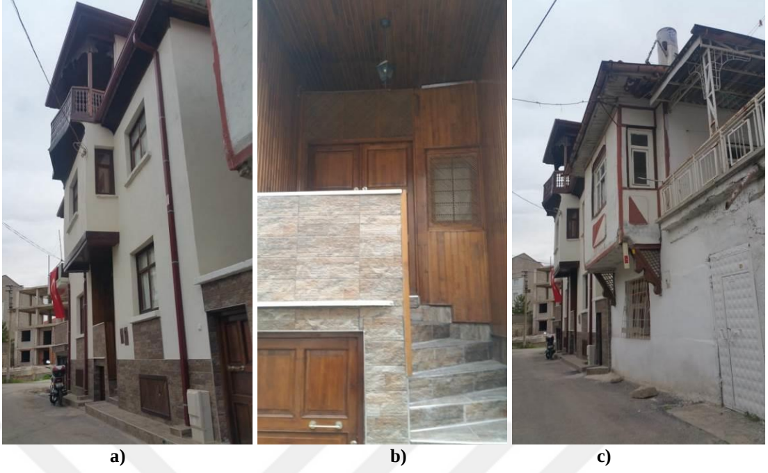
Şekil 2.42. a) Aslına uygun olmayan malzeme kullanımı b) Uyumsuz malzeme kullanımı c) Tescilli yapı ile uyumsuz ek yapı (2021)
