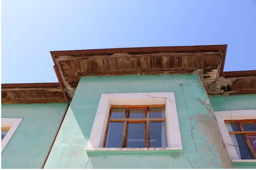
Şekil 2. 17. Geleneksel konutta ahşap saçak uygulaması (2021)
