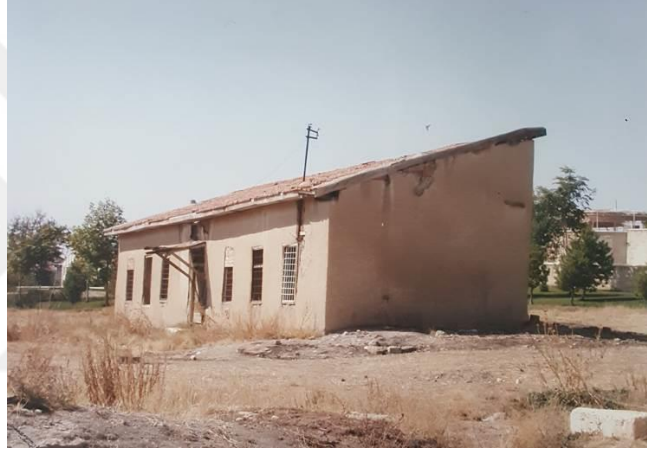
Şekil 3. 23. Hacı Ömer Ağa evinin 1986 yılındaki cephe görünüşü (Koruma Kurulu Arşivi)
