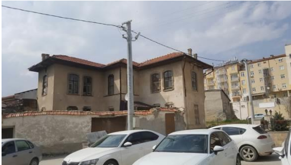
Şekil 2.38. Terk edilmiş ve deformasyona uğramış yapı (2021)
