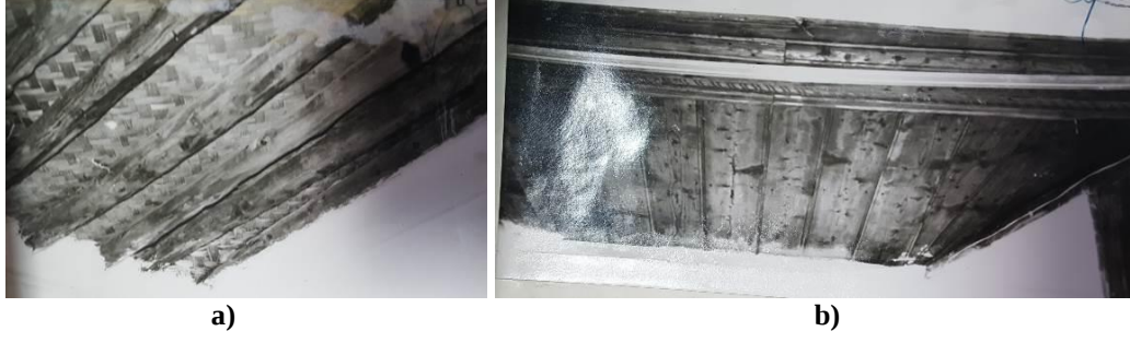
Şekil 3. 29. a) Dolaşıklar evi mabeyn ahşap kirişli tavanı b) güney odası ahşap tavan kaplaması (Koruma Kurulu Arşivi)
