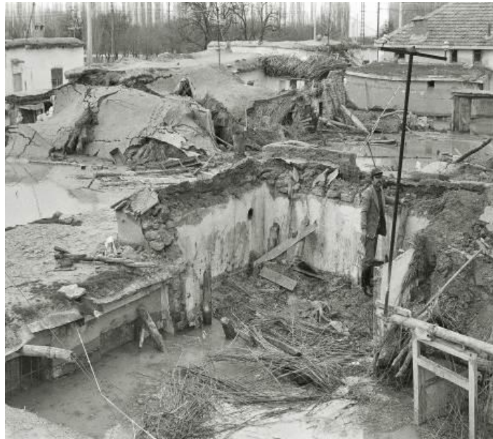
Şekil 2.51. Aşırı yağış sonrası yıkılan kerpiç yapılar (Karaman Belediyesi Dijital Arşivi, 2006)
