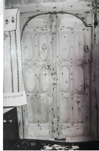
Şekil 3. 32. Nalıncılar Evi üst kat giriş kapısı (Koruma Kurulu Arşivi, 1986)
