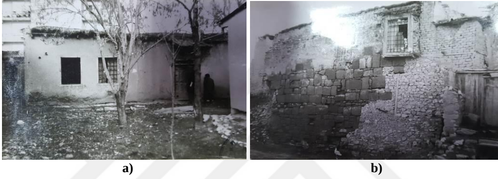
Şekil 3. 25. 28 No'lu evin 1986 yılına ait a) güney cephesi b) kuzey cephesi (Koruma Kurulu Arşivi)
