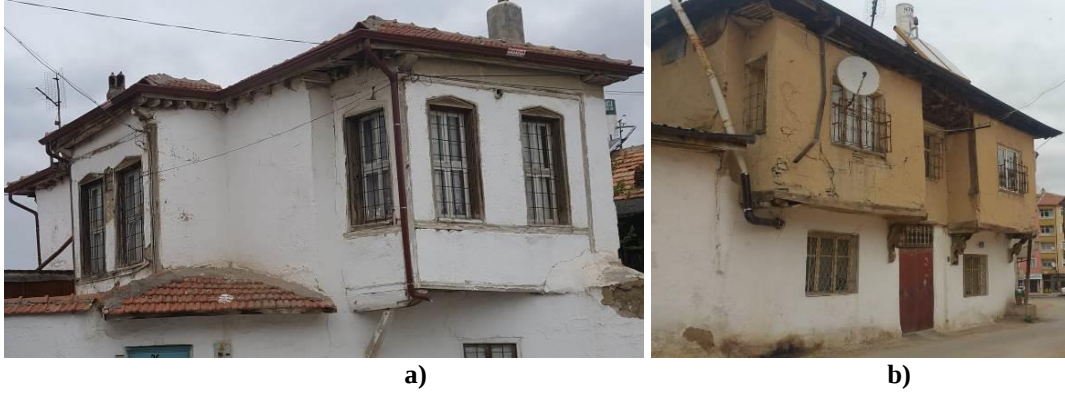
Şekil 2. 20. a) Dış duvarda kireç sıva uygulaması. b) Çamur sıva ve zemin kat girişinde kireç sıva uygulaması (2021)
