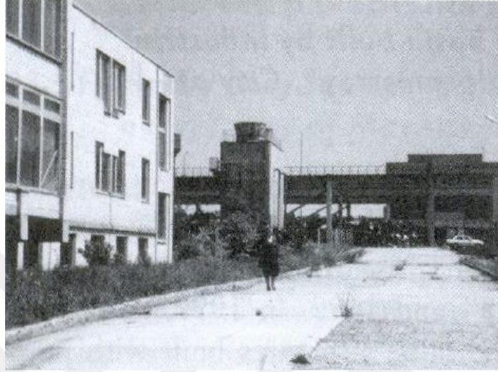
Şekil 2.3. AAC betonu ile inşa edilen yol [11]
