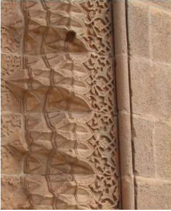
Görsel 79: Mardin Kasımiye Medresesi taç kapı kenar suyu detayı. (Doğan, 2017, s.194-195)
