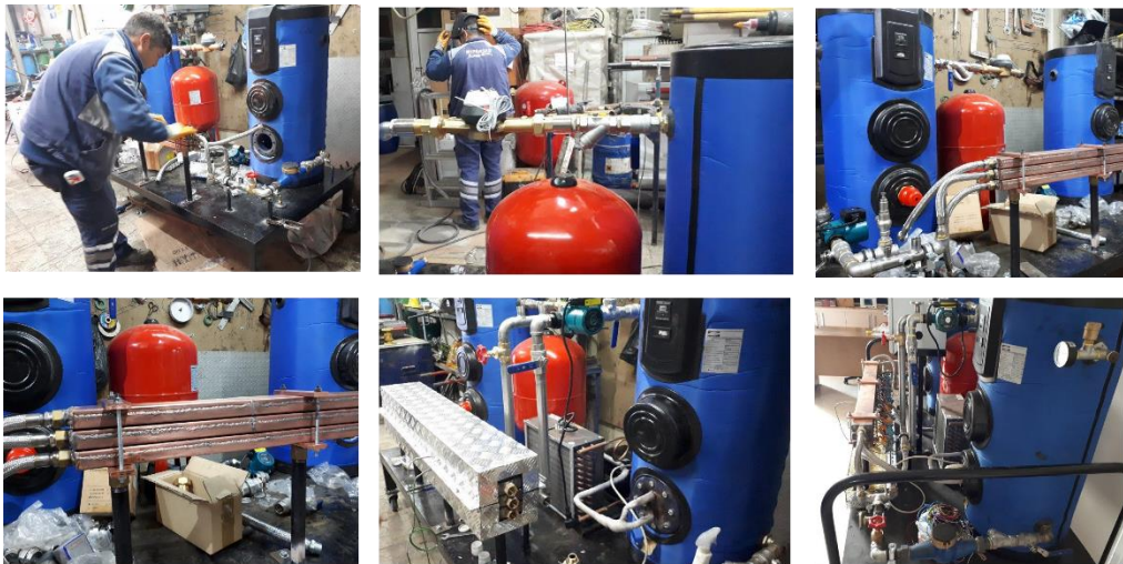
Şekil 3.37: Sıcak/Soğuk su sirkülasyon sistemi montaj aşamaları.
