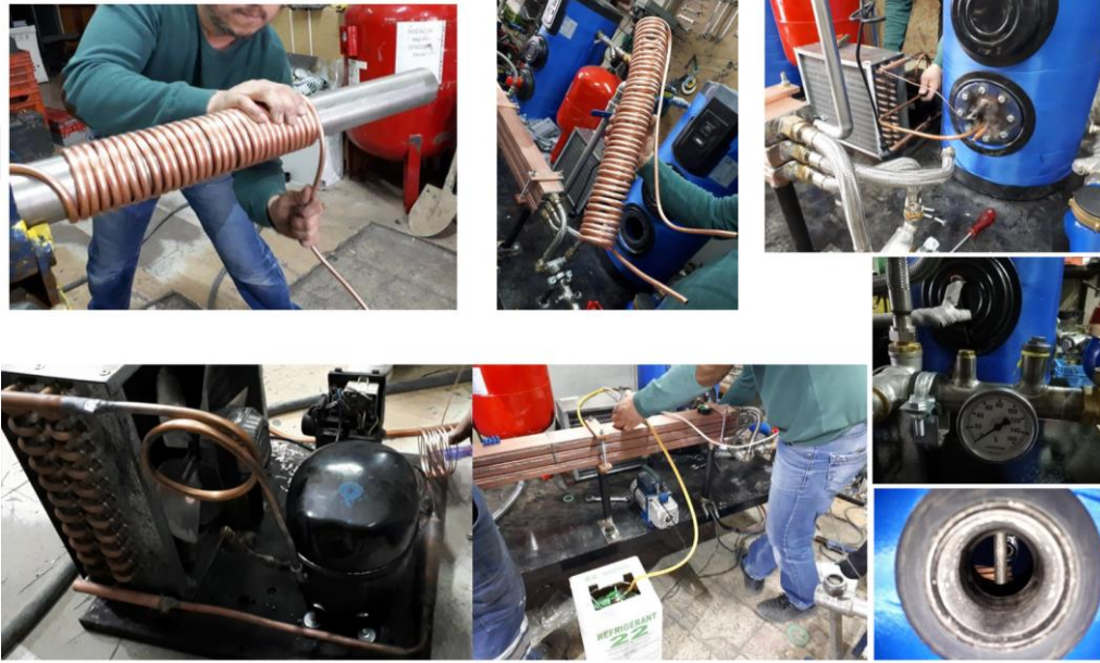
Şekil 3.36: Soğutma sisteminin montajı.
