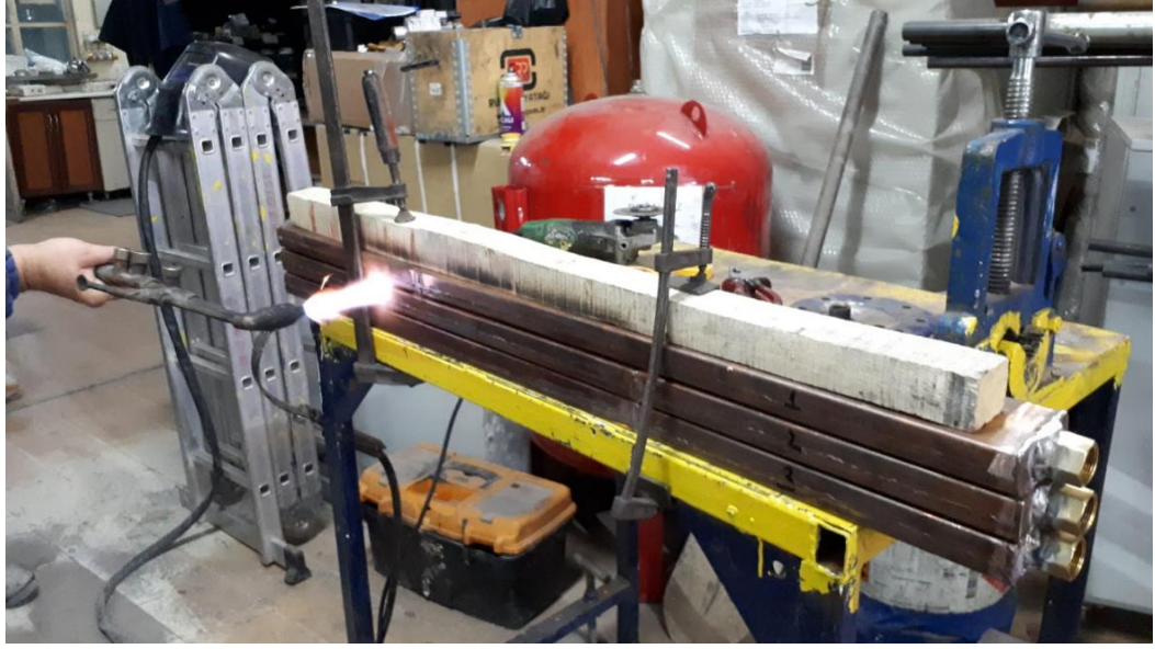
Şekil 3.23: Bakır profil yüzeyinin düzleştirilmesi.
