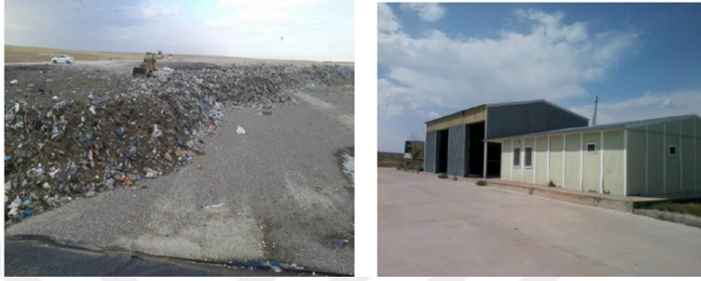
Şekil 2.15. Cihanbeyli Katı Atık Depolama Tesisi (Konya Valiliği, 2020)
