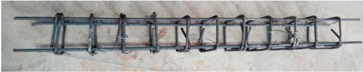
Şekil 3. 5. Boyuna ve enine donatıların bağlanması
