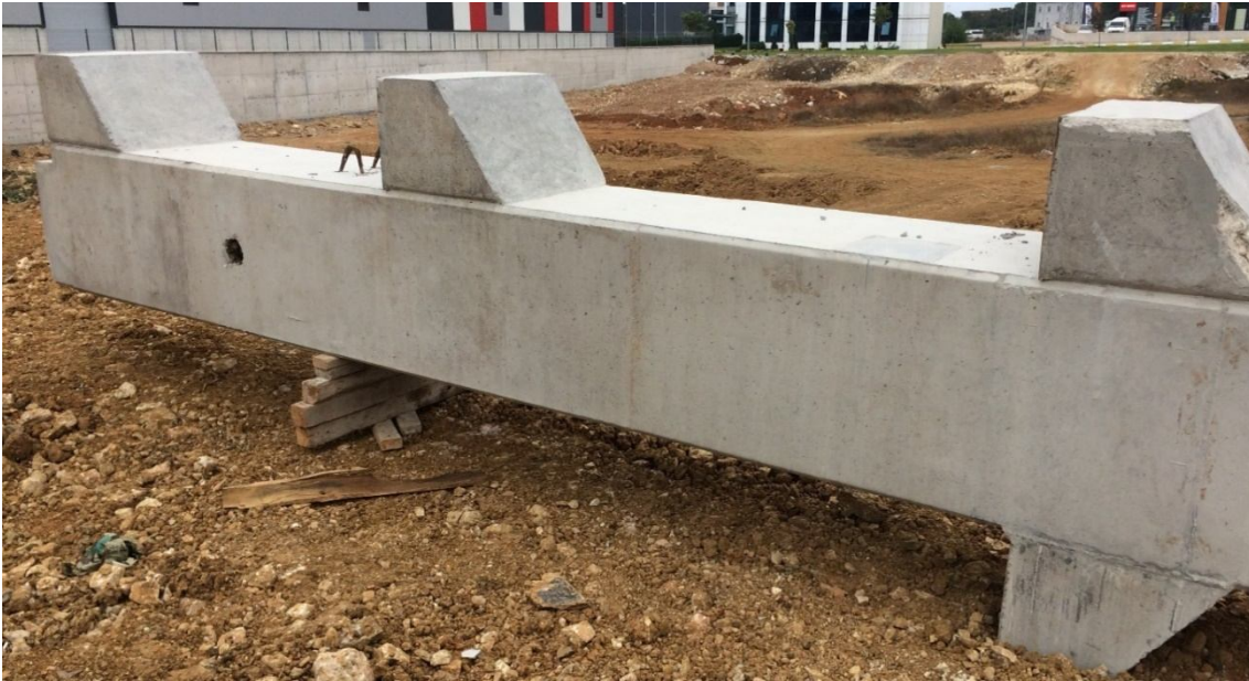
Şekil 2.1. Stok sahasında bekleyen betonarme prefabrik kolon
