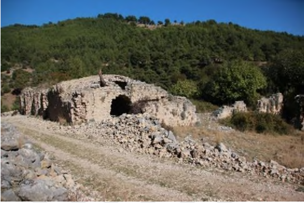
Şekil 43: Kuzoluk Kervansarayı, güney ve batı cepheleri
