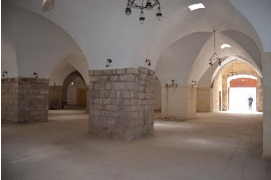
Şekil 62: Belen Kanuni Sultan Süleyman Kervansarayı, ahır bölümü (Belen Kaymakamlığı Arşivi)
