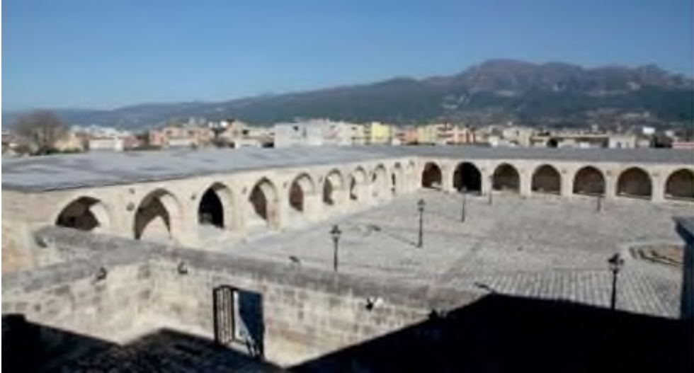
Şekil 58: Payas Kervansarayı, avlu ve revaklar (Kablan, “Payas Sokollu Mehmet Paşa Menzil Küliyesi”, s. 25)
