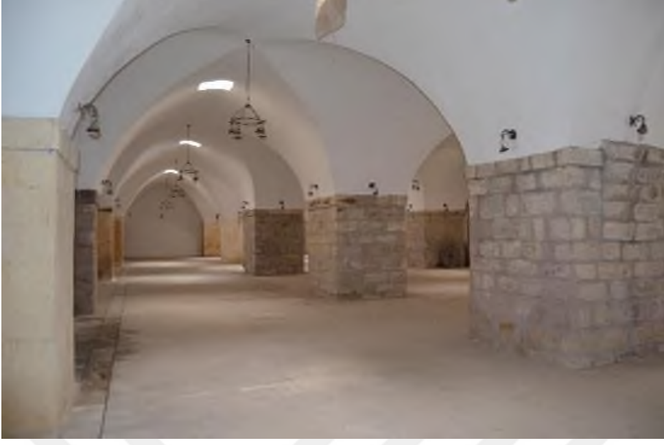
Şekil 63: Belen Kanuni Sultan Süleyman Kervansarayı, ahır bölümü (Belen Kaymakamlığı Arşivi)
