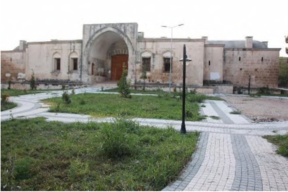
Şekil 54: Kurtkulağı Kervansarayı, giriş cephesi (2019)
