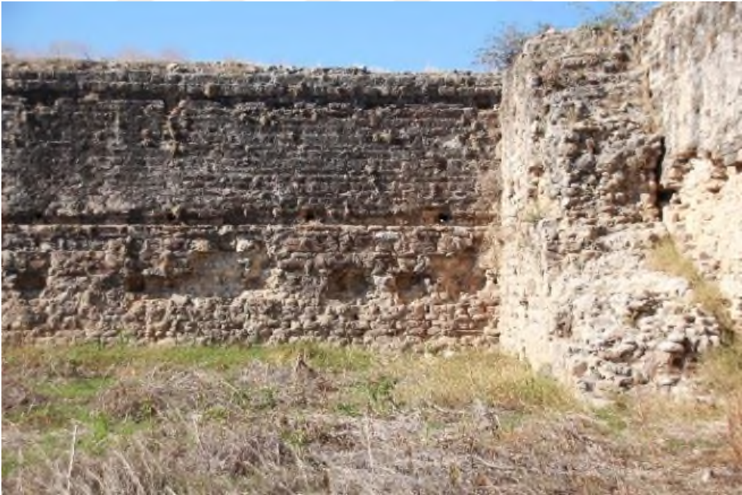
Şekil 48: Çakıt (Bayram Paşa) Hanı, ahşap hatıl izleri ve ikinci kata çıkan taş merdiven kalıntısı
