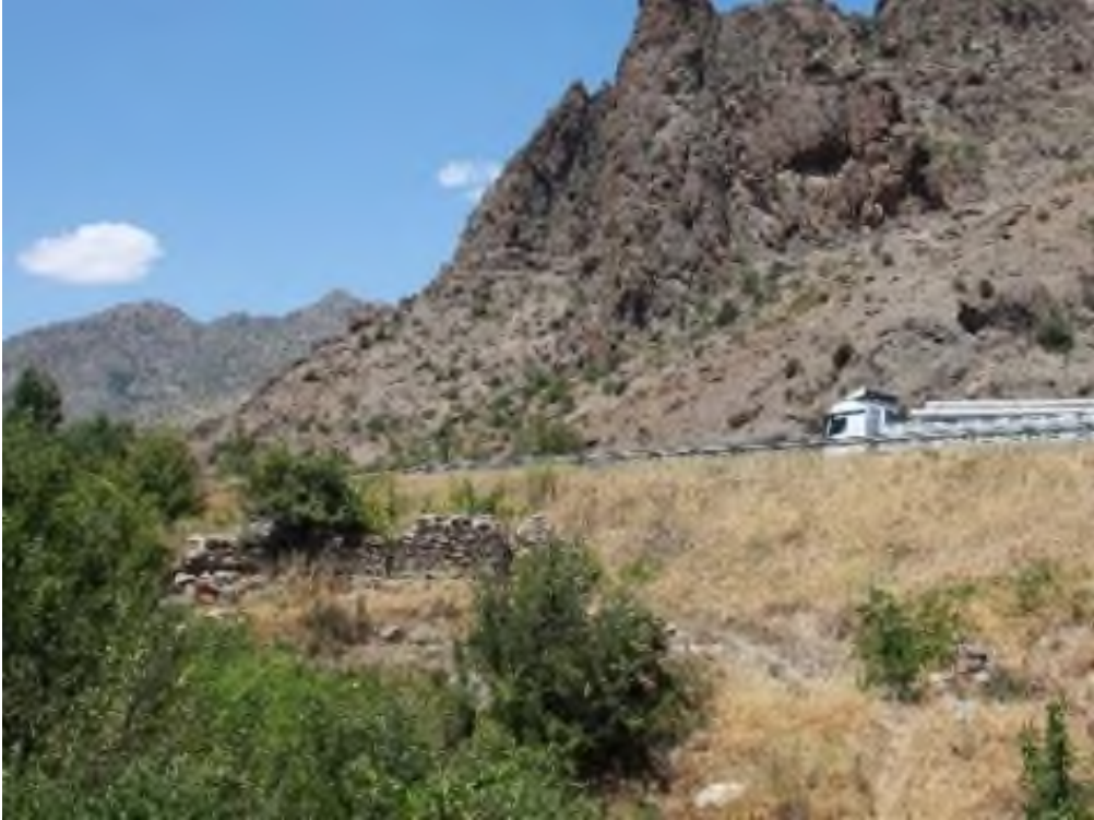
Şekil 36: Çiftehan Kervansarayı, günümüze ulaşan duvarın güneyden görünüşü
