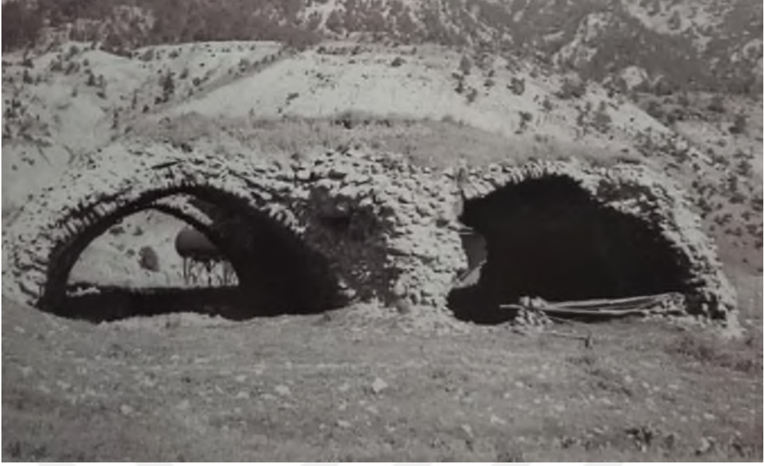
Şekil 39: Tekir (Piri Paşa) Hanı- 1971 (Cantay, “Kervansaraylar”, s. 595)
