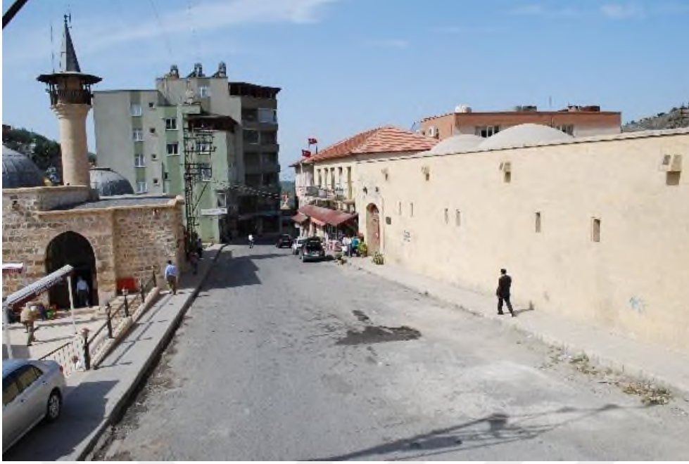
Şekil 61: Belen Kanuni Sultan Süleyman Kervansarayı, güney cephesi (Belen Kaymakamlığı Arşivi)
