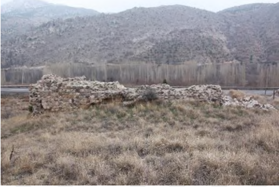
Şekil 31: Maraş Hanı kuzeyden görünüşü
