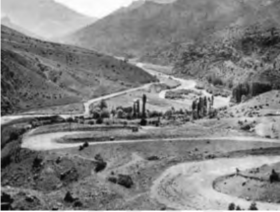
Şekil 33: Çiftehan Kervansarayı, kuzeybatı görünüşü (Şehbal Dergisi, S. 27, s. 52)
