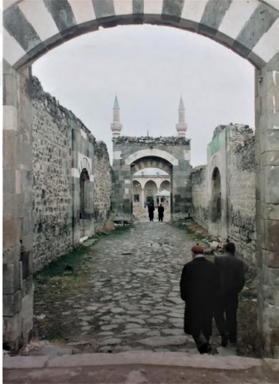
Şekil 20: Karapınar Sultan Selim kervansarayı orta koridoru (Küçükdağ, Karapınar Sultan Selim Külliyesi, Ön Kapak)
