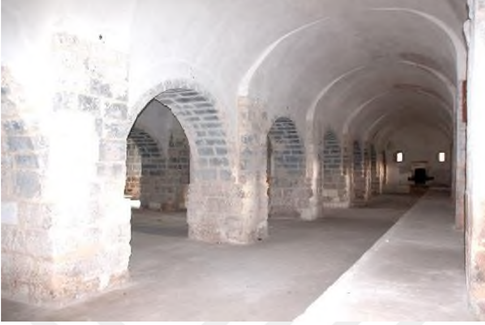
Şekil 57: Kurtkulağı Kervansarayı, iç mekân
