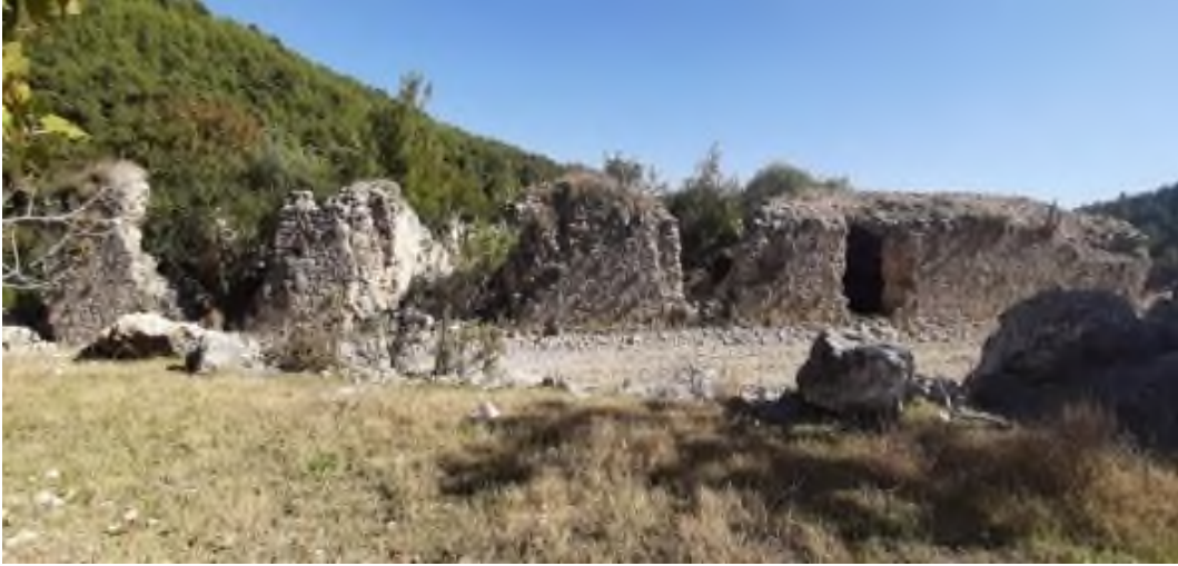
Şekil 44: Kuzoluk Kervansarayı batı cephesi
