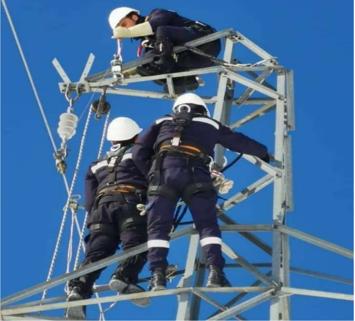
Şekil 45 Direkten yaralı indirme tertibatı2
