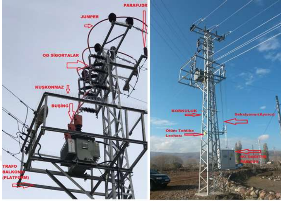
Şekil 59 Direk Tipi Transformatörler
