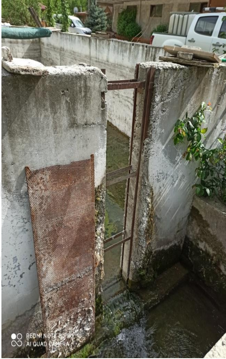
Şekil 5.4. Tesislerden Savak Örneği
