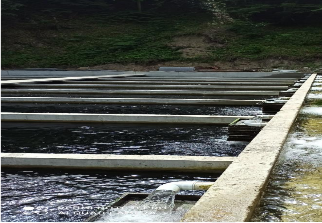
Şekil 5.2. Suyun parçalanarak hava ile temasını arttıran elek sistemleri
