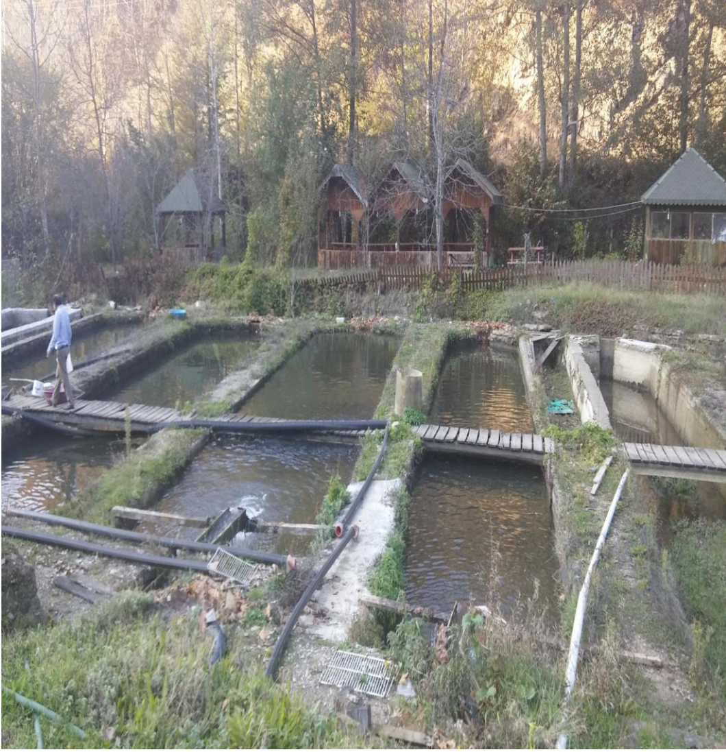
Şekil 5.6. Havuzlar Arasında Yürüme Bandı Bulunan Tesis
