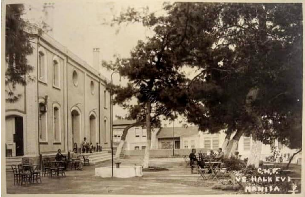
Fotoğraf 142: Manisa eski Halkevi Binası,
