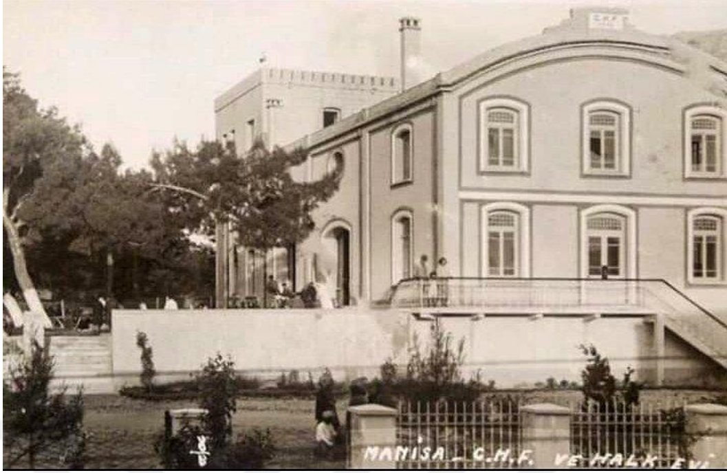
Fotoğraf 141: Manisa eski Halkevi Binası,
