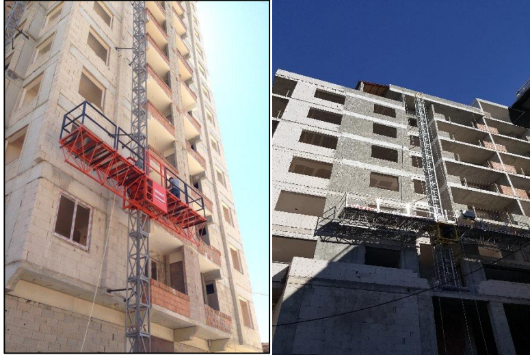
Şekil 3.16. Bir inşaatta kullanılan sütunlu çalışma platformu örneği
