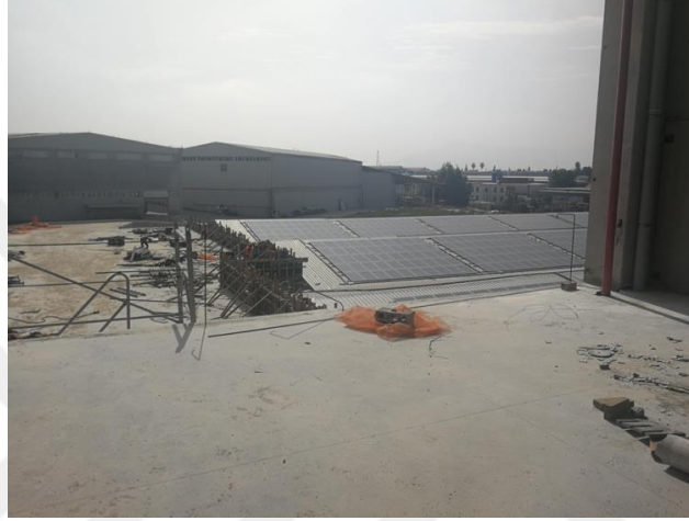
řekil 4.10. B inřaatı iin dřme tehlikesi bulunan kat kenar boşluėu
