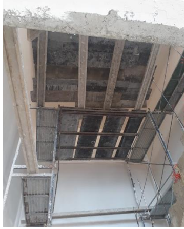
Şekil 4.17. Merdiven kulesi altı alçı sıva çalışması
