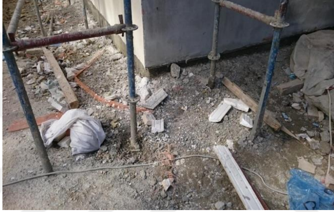
Şekil 4.2. A inşaatında teleskopik direklerde taban plakalarının olmaması
