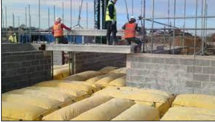
Şekil 3.14. Hava yastığı sisteminin bir inşaatta kullanımı
