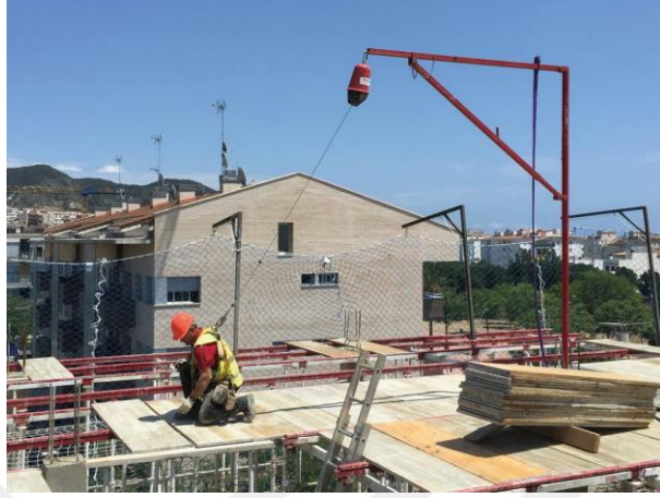
Şekil 4.19. Kalıp üzeri çalışmalar için paraşüt tipi emniyet kemeri kullanım örneği
