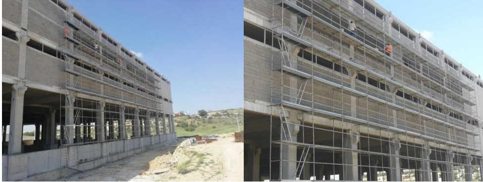
Şekil 4.8. B inşaatı için standartlara uygun cephe iskelesi kurulum örneği
