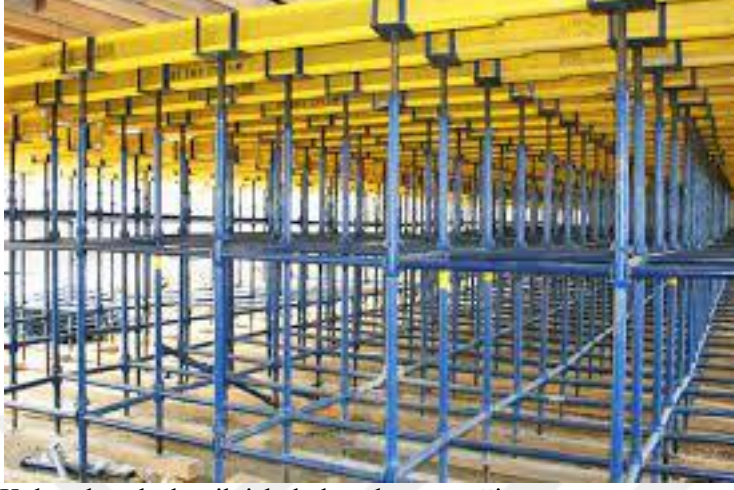
Şekil 4.4. Kalıp altı teleskopik iskele kurulum örneği
