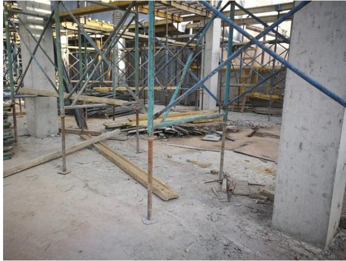
Şekil 4.3. A inşaatı için iskele kalıp örneği
