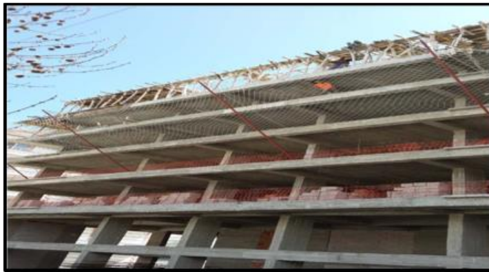
Şekil 3.12. Örnek inşaat, yakalama genişliğine göre güvenlik ağı örneği
