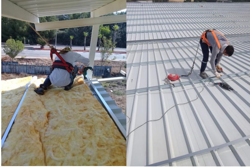
Şekil 4.15. B inşaatı için çatı panel kaplama işinde emniyet kemeri kullanımı
