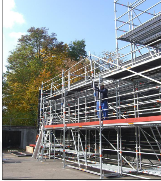
Şekil 3.8. Dış cephe çelik iskele kurulum örneği
