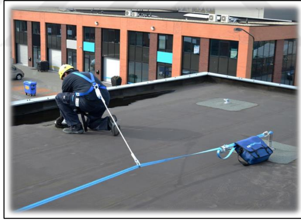
Şekil 3.2. C tipi ankraj noktası (TS EN 795-C) yatay yaşam hattı örnek çalışma
