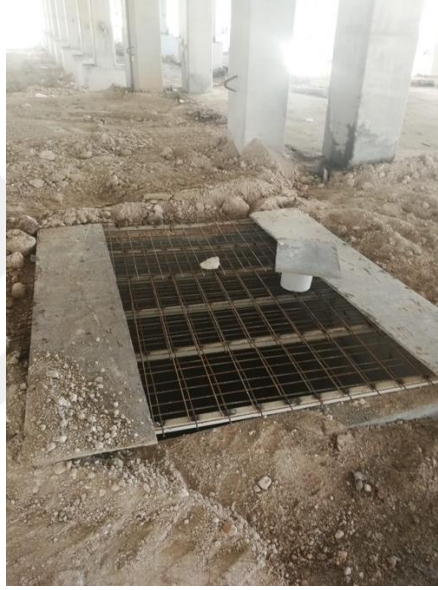
Şekil 4.6. B inşaatında düşme tehlikesi bulunan boşlukların kapatılması
