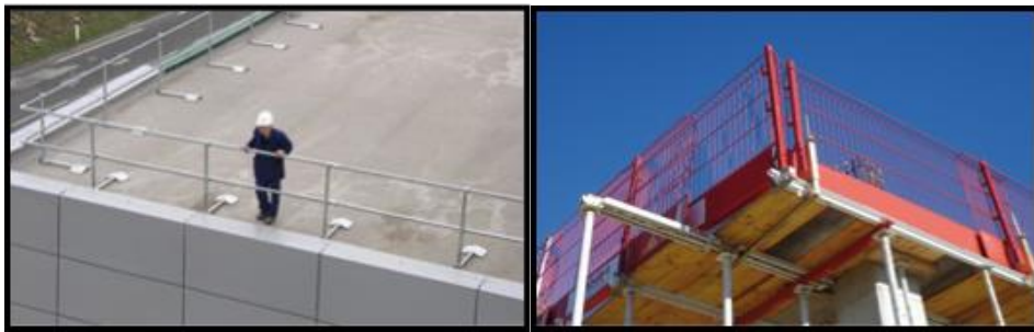
Çatı kenarları ve kalıp çalışmasında kullanılan korkuluklar
