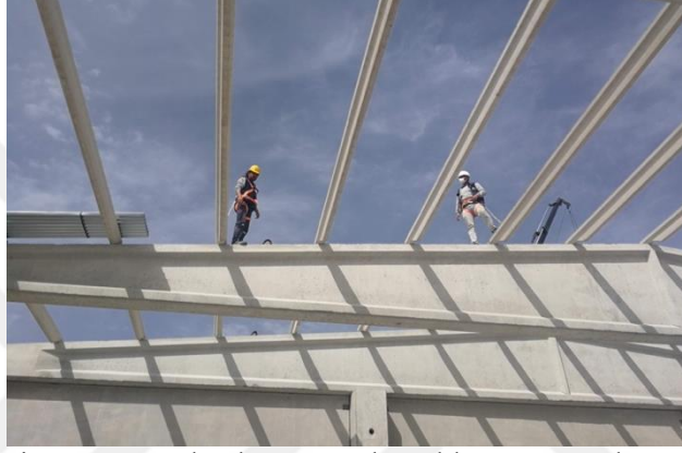
Şekil 4.14. B inşaatı çatı kaplama ön hazırlık aşamasında emniyet kemeri kullanımı
