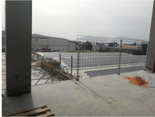
řekil 4.11. B inřaatı iin dřme tehlikesi bulunan kat kenarlarına kenar koruma sistemlerin uygulanması
