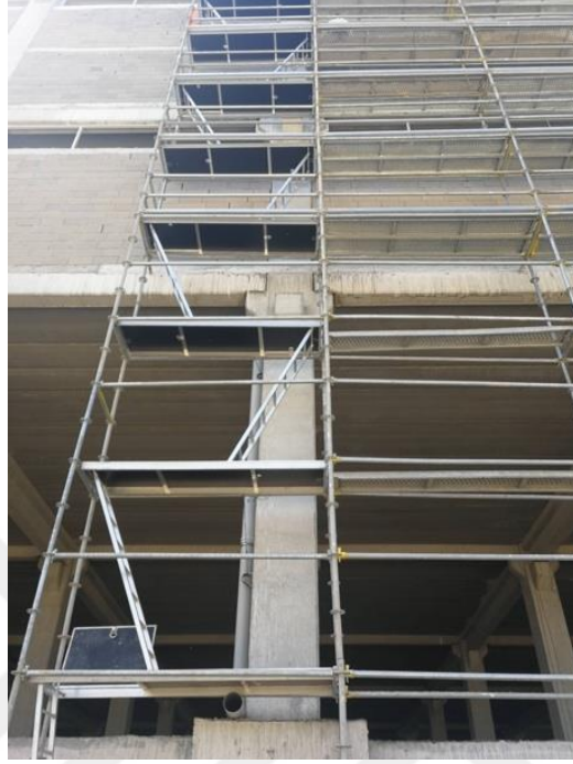
Şekil 4.9. B inşaatı kendinden merdivenli cephe iskele örneği
