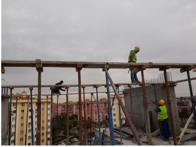
Şekil 4.18. C inşaatı kalıp üzeri yüksekte çalışması
