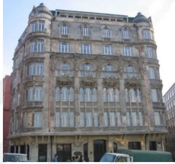
Şekil 2.5. Frej Apartmanı, Şişhane / İstanbul, 1906 (URL-4)
