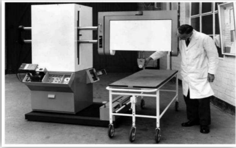
Şekil - 8: 1964 yılında Hillington'da, Kelvin Hughes'de icat edilen ilk Dasonograf'ı görmekteyiz. Cihazın yanında ise proje ekibinden Arthur Johnson yer almaktadır. Fotoğrafçı, Dugald Cameron olarak kayıtlara geçmiştir.
