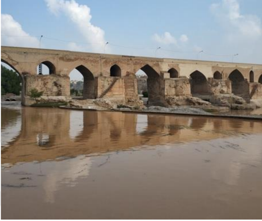
I.Şâpûr (242-272) tarafından inşa ettirilen Dizfûl Köprüsü (İsmet Burak Batır arşivi)
