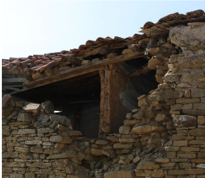
Şekil 5.50 Çatkılı ara duvar (Şekil 5.38), 183 ada 9 parsel (Uçar, 2020).
