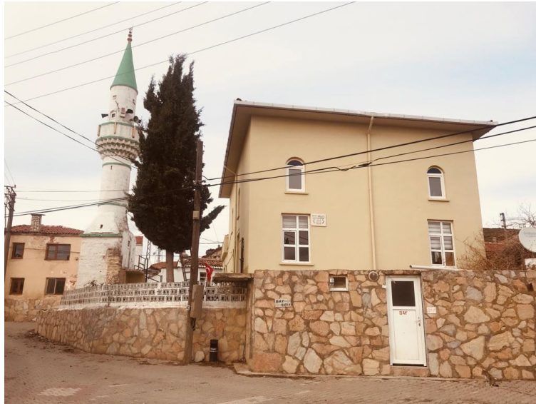
Şekil 3.33 Betonarme olarak yapılmış cami ve kesme taş minare (Uçar, 2020).
