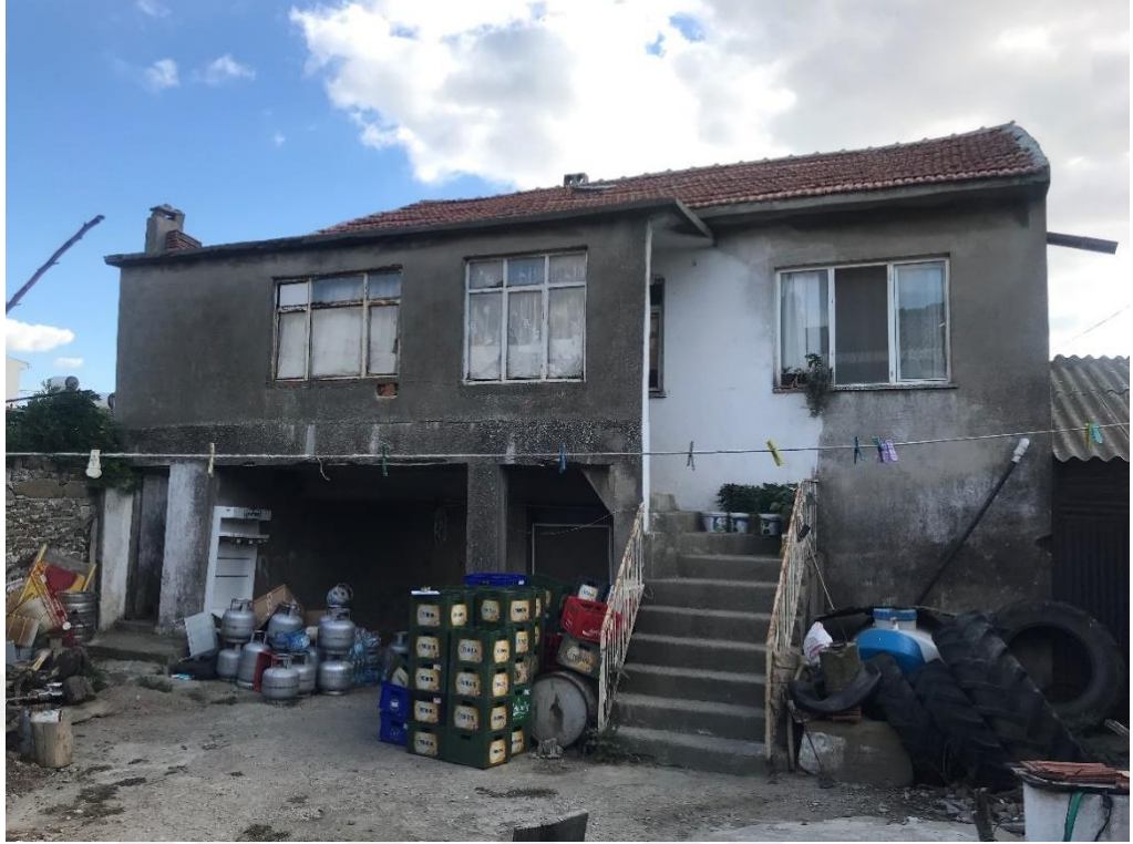
Şekil 4.11 Karma yapı örneği, 178 ada 2 parsel (Uçar, 2021).
