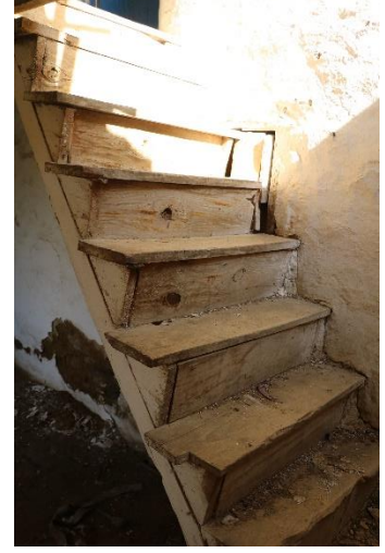
Şekil 5.30 L şeklinde tek kollu merdiven, 183 ada 3 parsel (Uçar, 2020).
