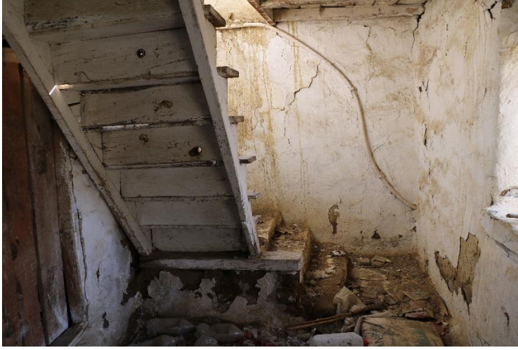
Şekil 5.30 L şeklinde tek kollu merdiven, 183 ada 3 parsel (Uçar, 2020).
