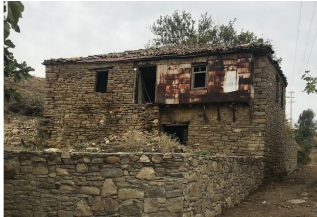
Şekil 5.103 Üst katına dışarıdan merdiven ile ulaşılan yapının dışa bakan çatkılı sofa duvarında görünen çıkma, 170 ada 2 parsel (Uçar, 2020).
