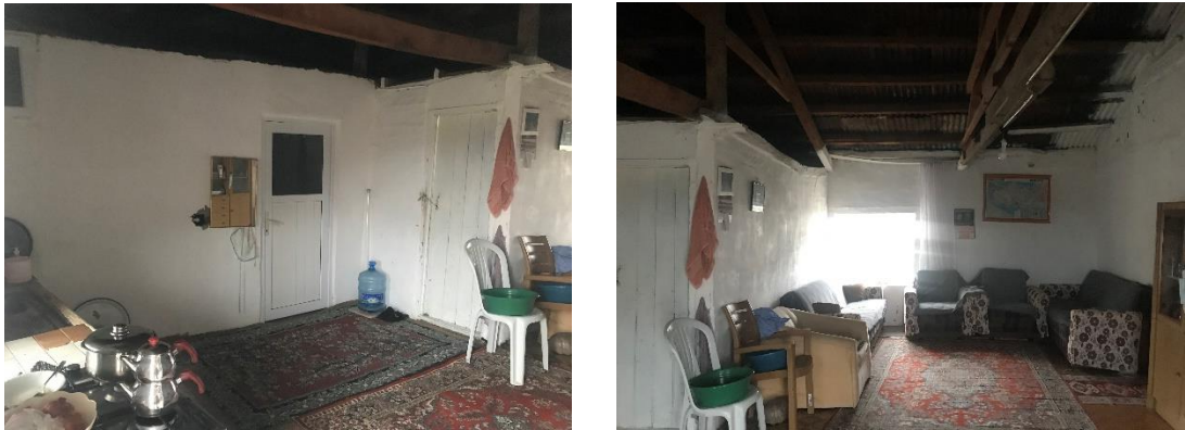
Şekil 5.84 Solda sofaya dahil edilerek değiştirilen oda duvarı, sağda sofa ve üzerinde makash kırma çatı (Uçar, 2020).
