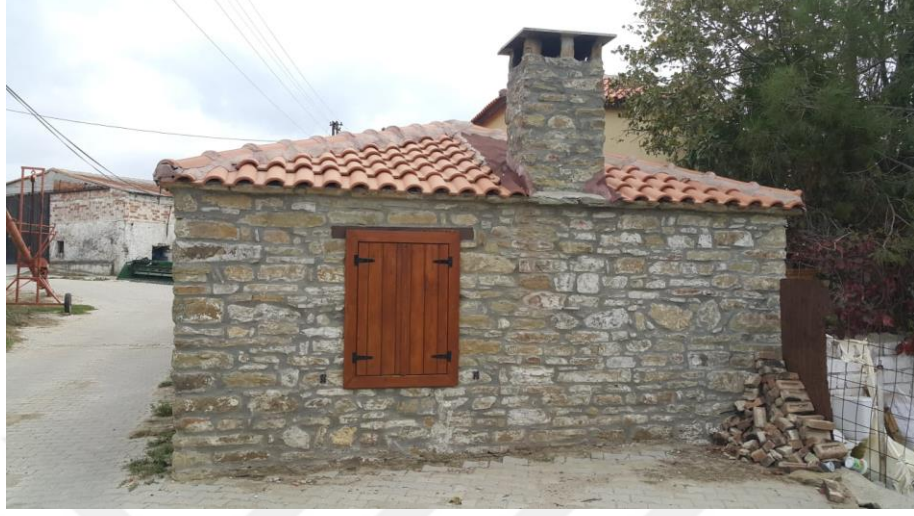
řekil 5.136 Onarımı yapılarak iřlev deęiřiklięi ile konuta dnüştürölen dam yapısı, 185 ada 5 parşel (Uar, 2019).
