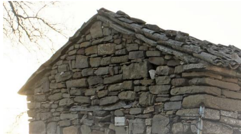
Şekil 5.114 Tek sıralı taş saçak silmesi örneği, 185 ada 6 parsel (Uçar, 2020).
