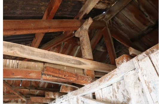
Şekil 5.89 Solda taşlık mekanı, dam ve oda kapısı, sağda yapının makaslı kırma çatısı Uçar, 2020).
