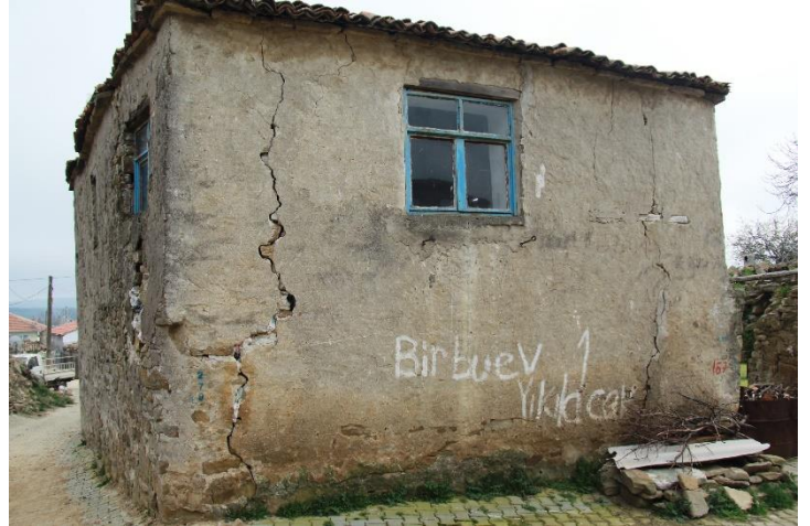
Şekil 5.121 Yapısal hasara uğramış moloz taş duvarda meydana gelen ayrılma, 177 ada 7 parsel (Uçar, 2020).
