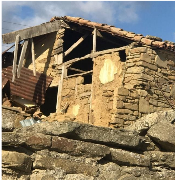
Şekil 5.63 Üst kat çatkılı dış duvarı yıkılmış olan yapı, 177 ada 2 parsel (Uçar, 2020).
