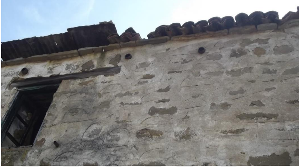
Şekil 5.110 Taş saçak silmesi altına yerleştirilen mermi kovanları, 181 ada 5 parsel (Uçar, 2017).
