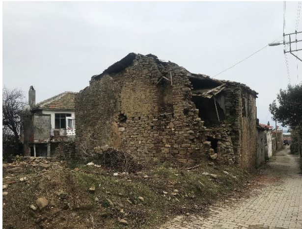
Şekil 5.92 Bitişik nizam kuzeydoğu duvarı, 177 ada 5 parsel (Uçar, 2021).
