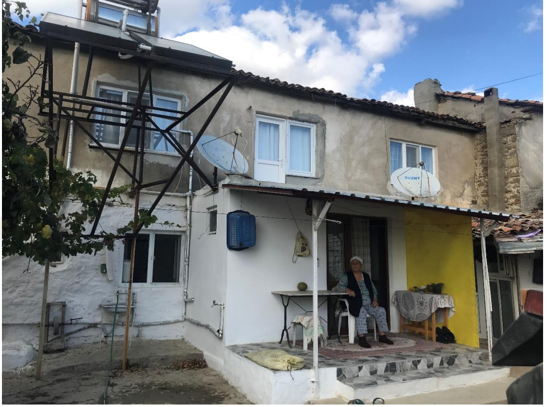
Şekil 5.127 Yapının giriş cephesine yapılan eklenti ve üst kat çatıklı duvarı tuğla ile yenilerek pvc pencere takılan yapı, 178 ada 1 parsel (Uçar, 2021).
