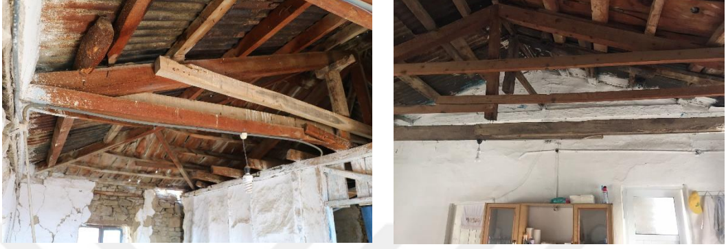
Şekil 5.57 Solda 183 ada 9 parselde bulunan konutun ara duvarına oturan makaslı çatı, sağda 179 ada 8 parselde bulunan konutun makaslı çatısı (Uçar, 2020).
