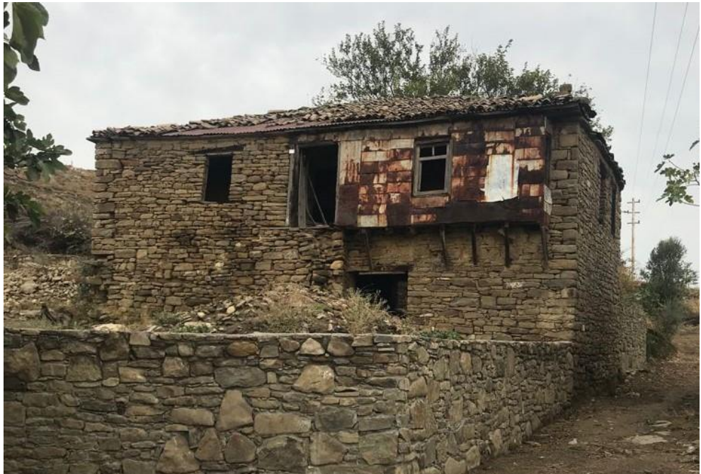
Şekil 5.10 170 ada 2 parselde bulunan konutun giriş cephesi (Uçar, 2021).
