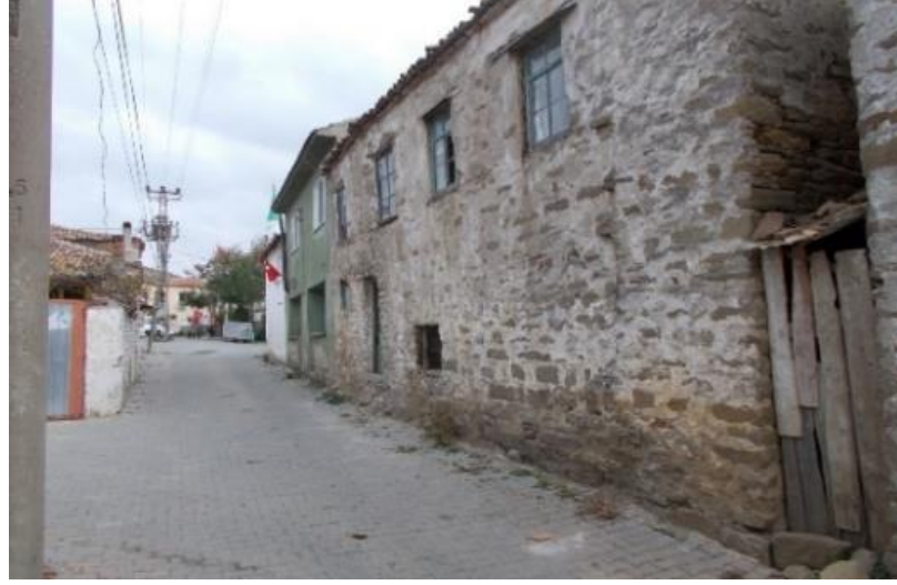
Şekil 4.8 Yığma taş yapı örneği, 181 ada 3 parsel (Uçar, 2020).
