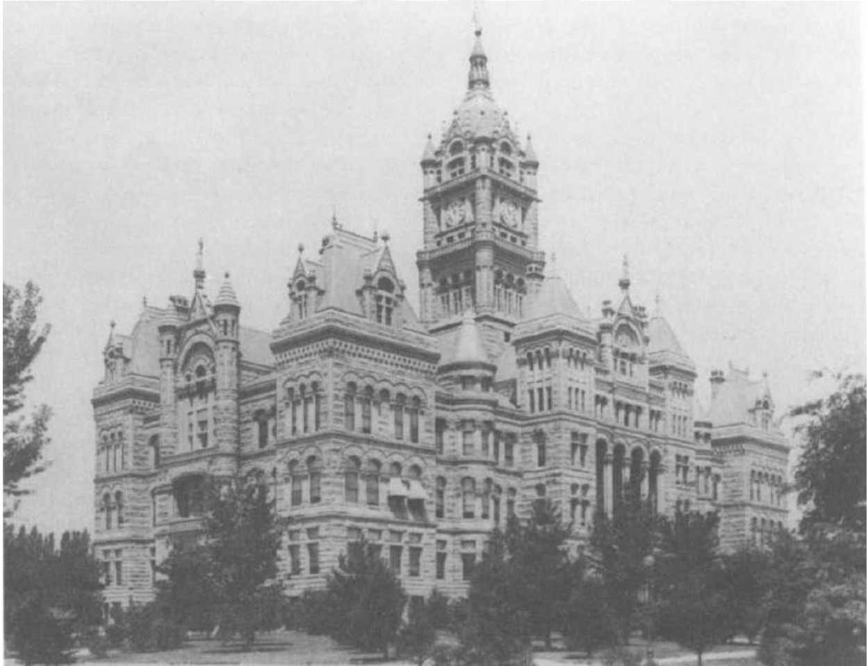
Şekil 6.33. ABD'de bulunan, tarihte ilk defa deprem izolatörleri kullanılarak güçlendirilmiş tarihi yapı olan Salt Lake City and County Building (Allen & Bailey, 1991).
