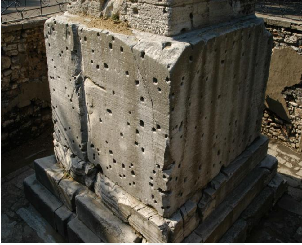
Şekil 6.21. Örne Dikilitaş'ın doğal sismik izolatör işlevi yapan temel kısmı (Bal, 2011).
