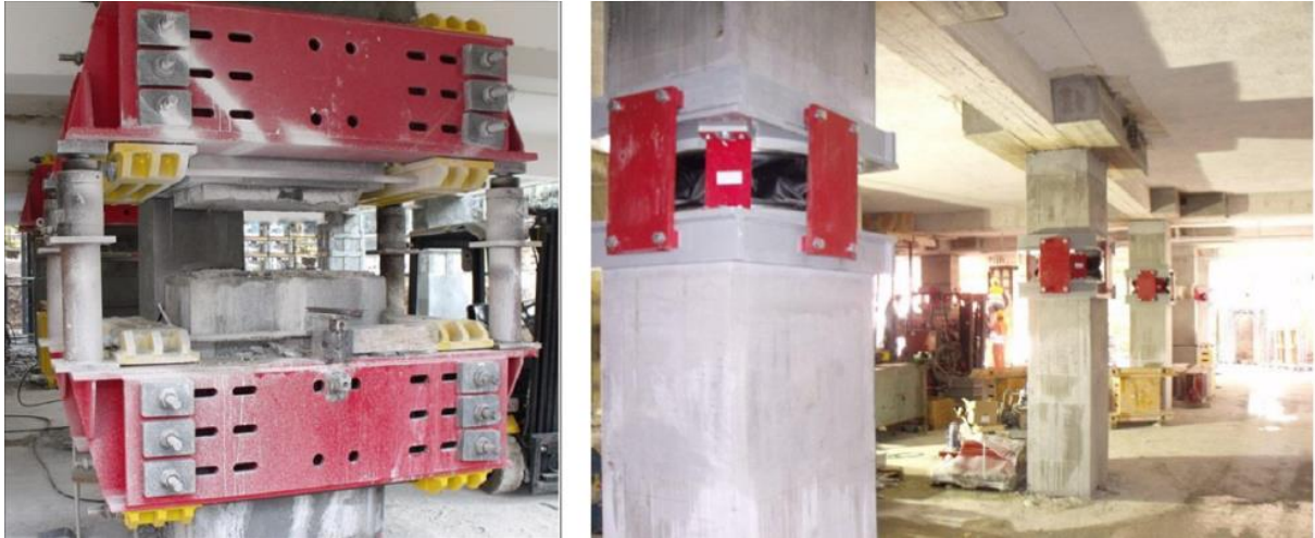
Şekil 6.41. İstanbul Başbüyük Eğitim ve Araştırma Hastanesi kolon izolator montajı (Erdik, Ülker, Şadan, & Tüzün, 2018).
