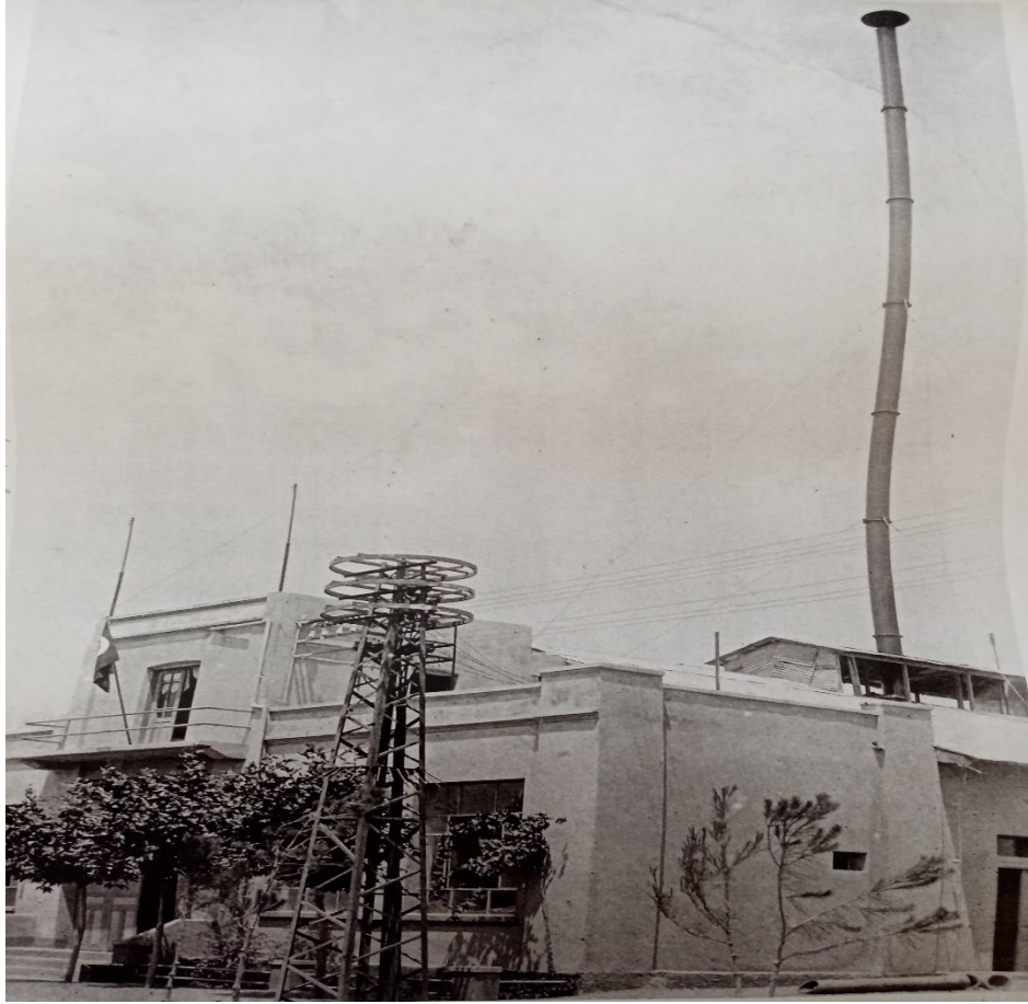
Fotoğraf 8. Elektrik santralinden bir görünüş (1938) Bugün Tütün Otelin yanında yer alan bina TEDAŞ tarafından kullanılmaktadır.
