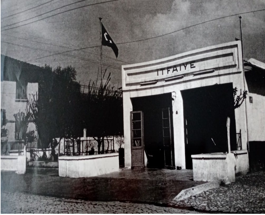
Fotoğraf 18. İtfaiye Garajı
