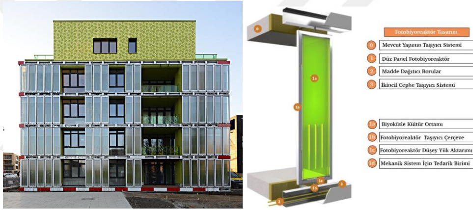
Şekil 3.1 BIQ binası ve destek yapısı-tedarik sistemi de dahil olmak üzere panel prototipinin oluşturulması (Wurm, bt)
