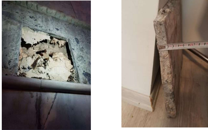
Şekil 3.32 Yerine montajı yapılmadan önce ana mekân kalsit (serpantin) breş kaplama taşı ve kesit görüntüsü (2020)
