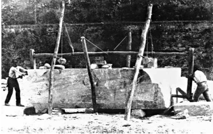
Şekil 3.22 20.yy. başında karşıt ağırlıklı sarkaç testere ile taş kesen işçiler (Kessener, 2010)
