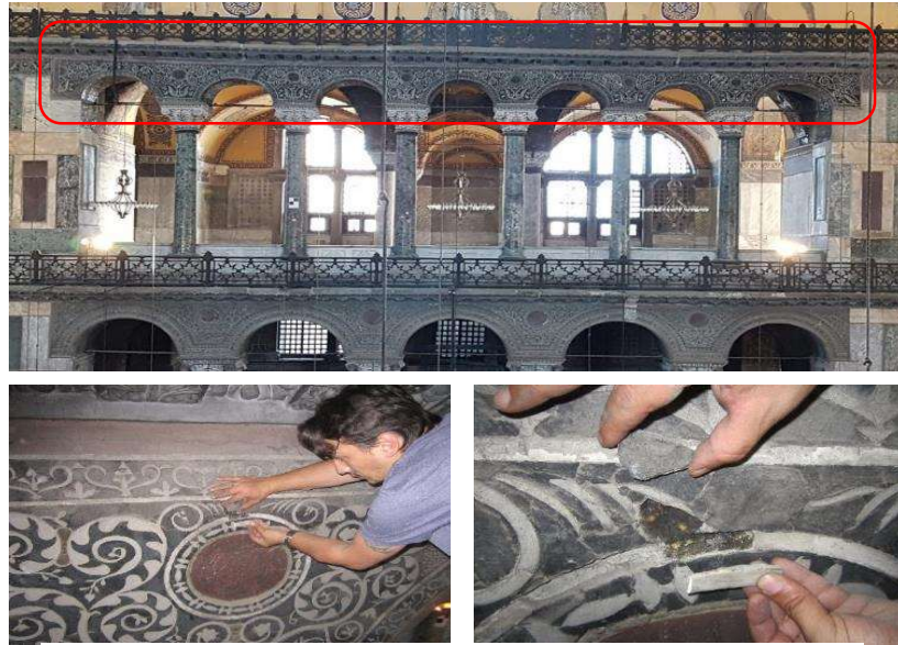
Şekil 3.49 Sıralı kemer alını (2020) taş kakma işçiliği ile yapılan duvar kaplaması (2013)
