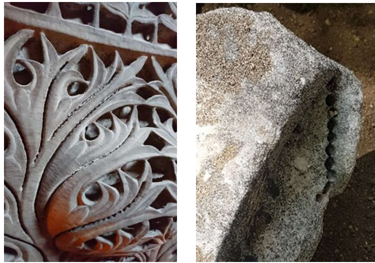
Şekil 3.52 Ayasofya ana mekân sütun başlıklarındaki matkap izleri (solda) Ayasofya bahçesinde bulunan sütun başlığı üzerindeki sıralı matkap izleri (sağda) (2017)
