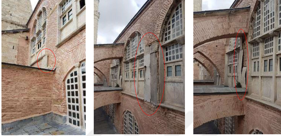
Şekil 3.31 Batı dış cephedeki Marmara mermeri duvar kaplamaları (2019)
