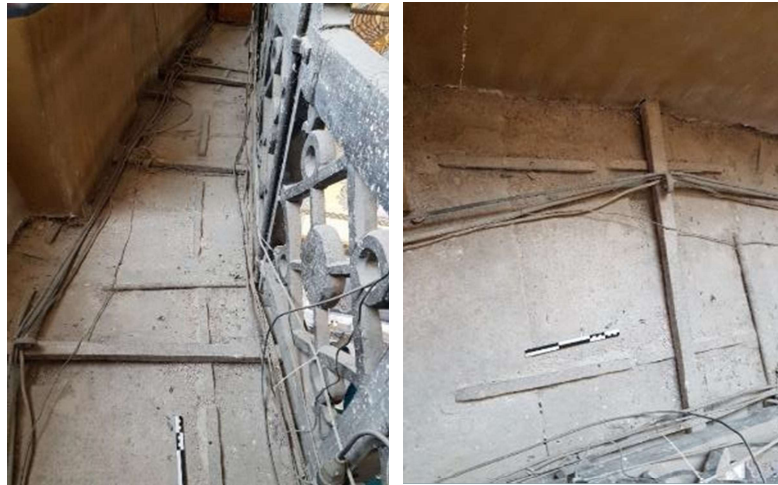
Şekil 3.58 Ana kubbe batı yönü mermer korniş üzeri demir kenetler (2020)
