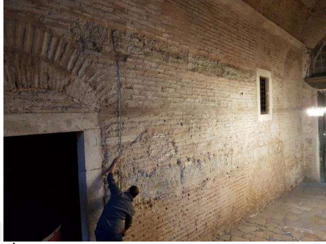
Şekil 3.3 İç narteksten kuzeybatı rampaya çıkış koridorundaki od taşı duvar hatılları (2020)
