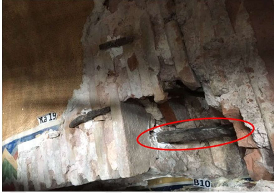
Şekil 2.34 Kuzey tympanom kemeri içinden geçen demir donatı (2015)
