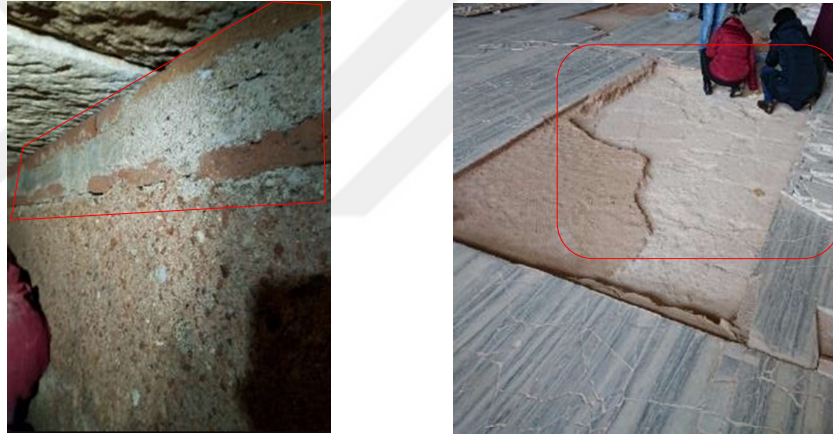
Şekil 3.29 Ana mekânda döşeme altı tuğla sırası (solda) (2020) galeri katı döşeme altı tuğla zemin (sağda) (2018)
