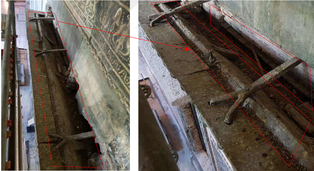
Şekil 3.61 İmparator kapısı lentosunun üstten görünümü sağ üstte sıralı kaplama tahtaları ve tuğla duvar (2020)
