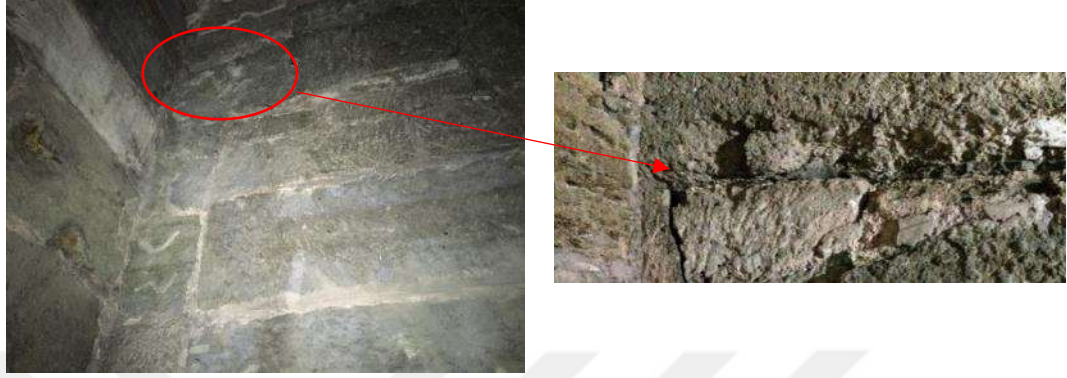
řekil 3.18 Kuzey nef payanda ii odada derz arasındaki kurřun levha (2017)
