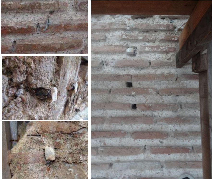
Şekil 3.34 Batı cephe kaplama levhası taş takozları ve farklı tür ve kesitli metal kenetleri (2018)
