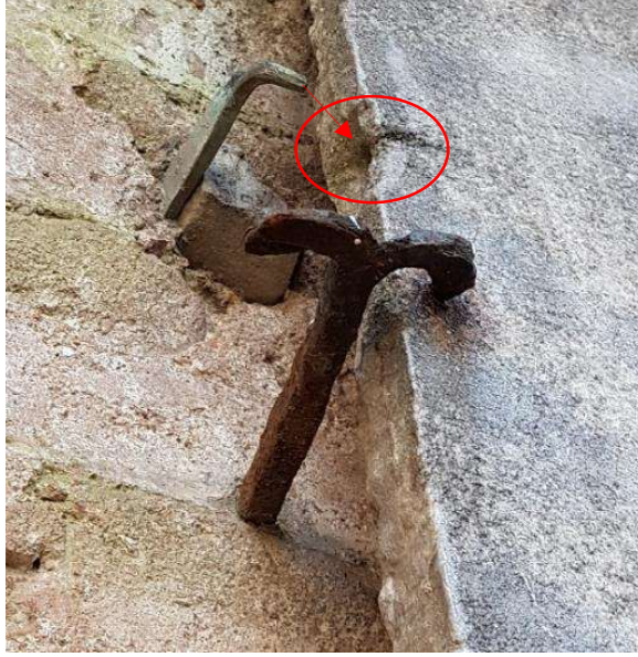
Şekil 3.40 Taş takozlu bronz donatı ve taş kaplamada açılmış yuva yeri (üstte) taş takozsuz çapa biçimli diğer donatı (altta) (2019)
