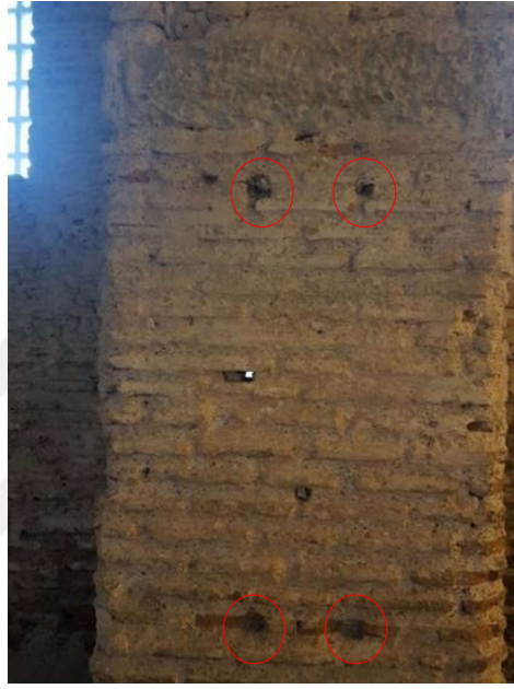
Şekil 3.43 Dış narteks tonozlarını taşıyan tuğla ayaklardaki taş takozlar ve takoz yuvaları (2020)
