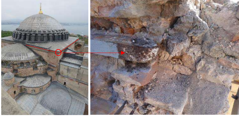
Şekil 2.33 Fossati demir çember seviyesi (2013) ve çemberin mevcut durumu (Gökalp Proje Ltd. Şti., 2013)
