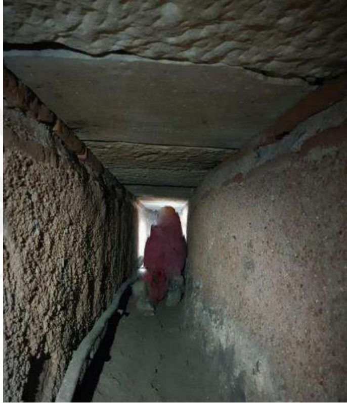
Şekil 3.19 Ana mekân zemin altı kanallardan görünüm. Üstte döşeme taşlarının ince ve kaba biçimde tıraşlanan alt kısımları yan yana görünmektedir (2020)
