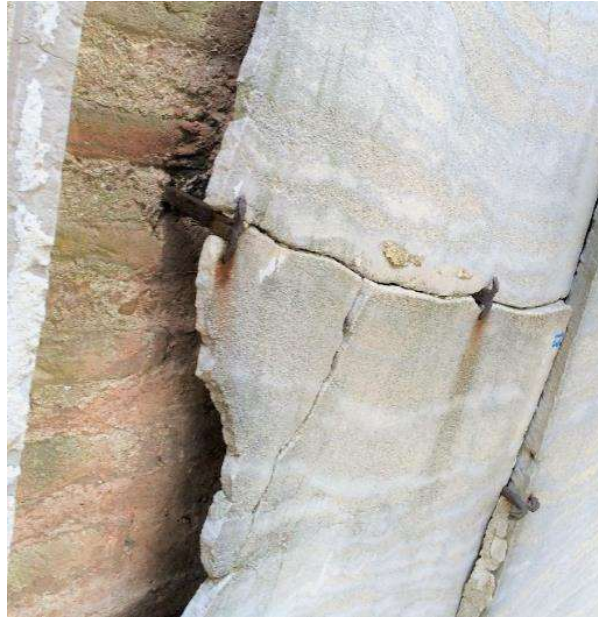
Şekil 3.39 Taşların kırılmış bölgelerinde onarım amacıyla kullanılmış kenetler (2014)
