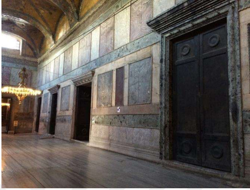
Şekil 3.60 Serpantin breş (önde) ve Marmara mermeri kapı söveleri (2019)
