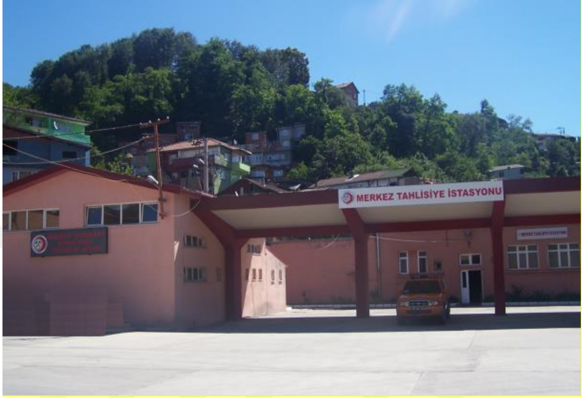
Şekil 2.18. TTK Merkez Tahliye İstasyonu genel görünümü (7)
