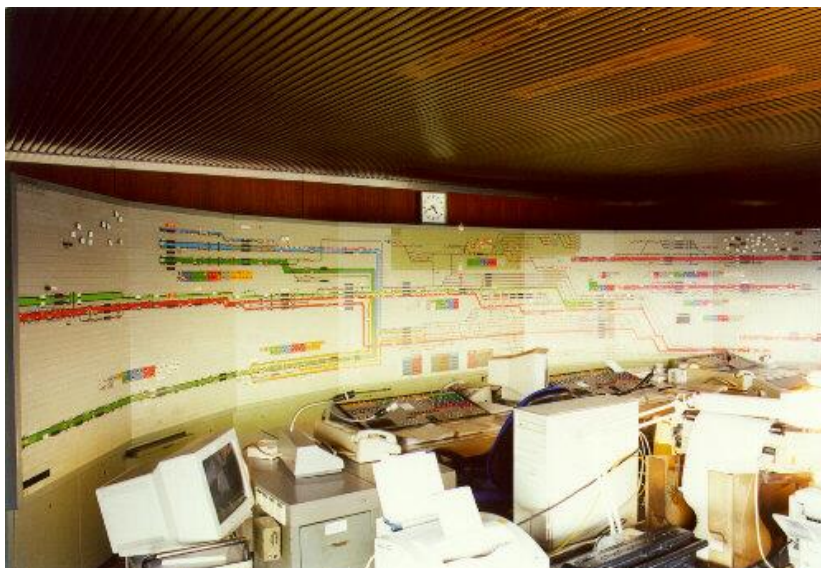
Abbildung 10: Stelltafel des Siemens Sp Dr S60 Stellwerks (Darmstadt Hbf)
