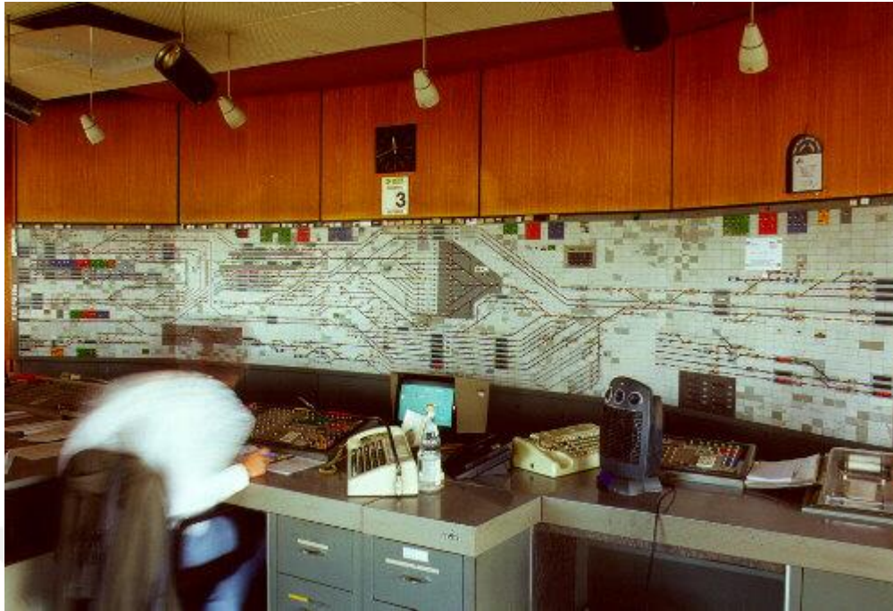
Abbildung 4: Stelltafel eines Siemens Sp Dr S60 Stellwerkes (Ludwigshafen(Rhein) Hbf)
