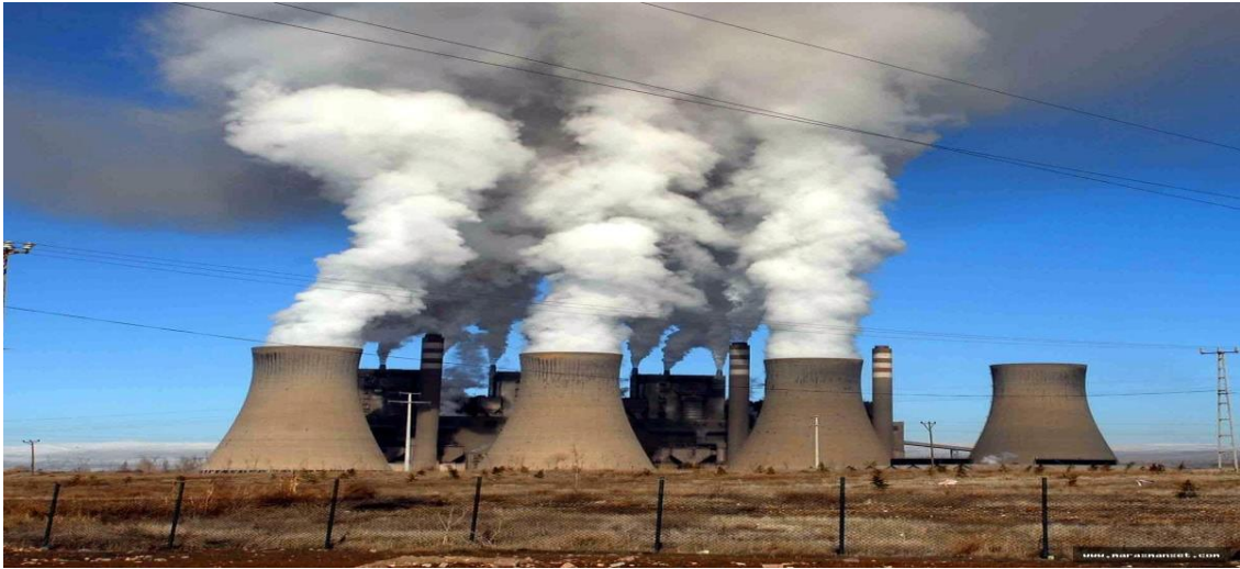
Resim 4. 1. Afşin-Elbistan Termik Santrali (30.01.2020, http://www.marasmanset.com/ ).
