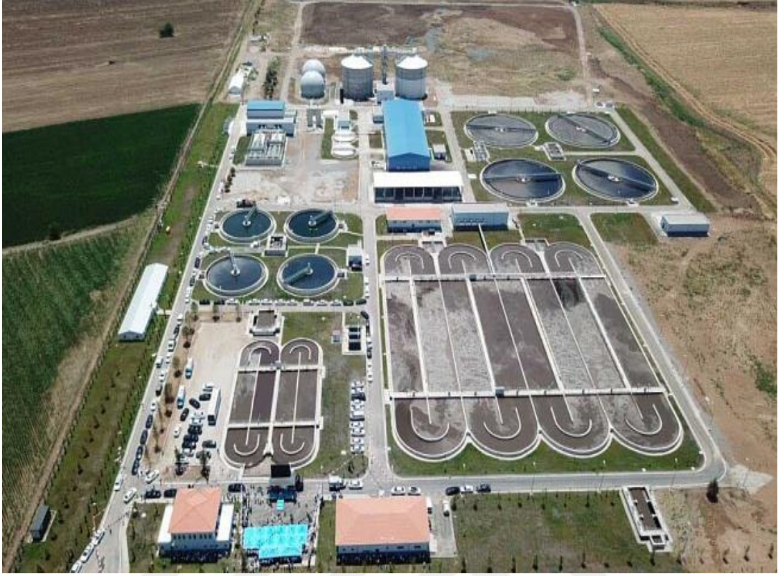
Resim 6.1. Kahramanmaraş Büyükşehir Belediyesi Atık su Arıtma Tesisleri, (20.02.2020, https://www.aksutvhaber.net/ ).
