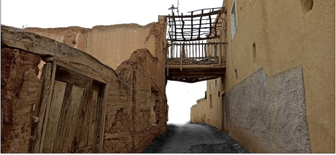
Şekil 4.33 : Geleneksel konutların üst katlarında bağlantıyı sağlayan selamlık örneği (Fotoğraf: Orjinal, 2021).
