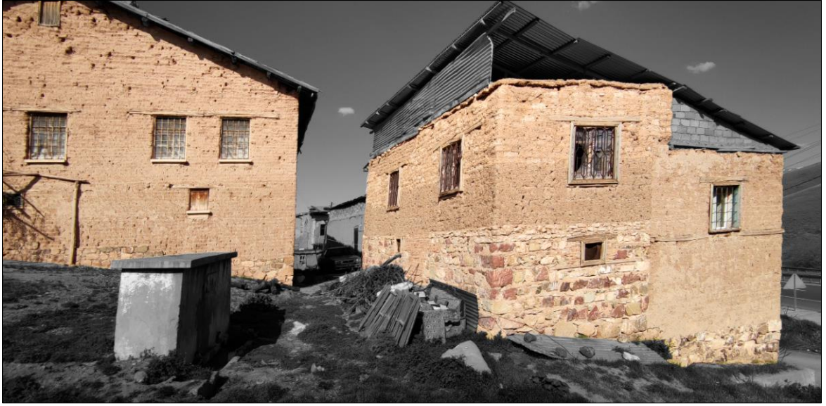
Şekil 4.123 : Depo ve/veya besi hayvanları için oluşturulan mekânlar alt katlarda tasarlanırken bu mekânlardaki ısı kontrolü için tasarlanan pencereler üst kat kotlarına göre daha küçük boyutlardadır (Fotoğraf: Orjinal, 2021).
