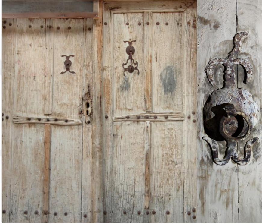
Şekil 4.64 : Yapı giriş ve iç mekân kapılarında yer alan özgün kapı tokmakları (Fotoğraf: Orjinal, 2021).
