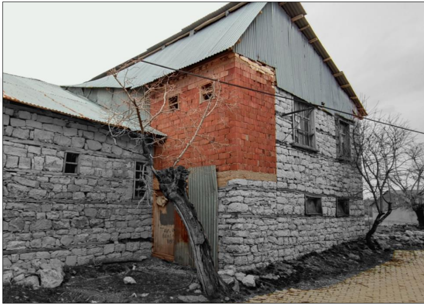
Şekil 4.65 : Yanlış müdahaleler sonucu niteliksiz yapı elemanı eklenmiş Koru geleneksel konutu (Fotoğraf: Orjinal, 2021).
