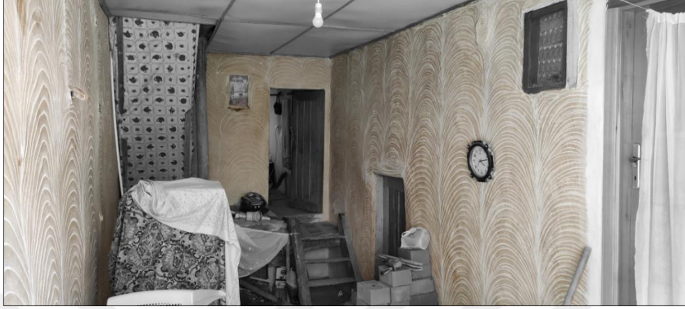
Şekil 4.58 : Kuru geleneksel konutlarında genellikle iç mekânlarda uygulanan çarpma sıvalar (Fotoğraf: Orjinal, 2021).
