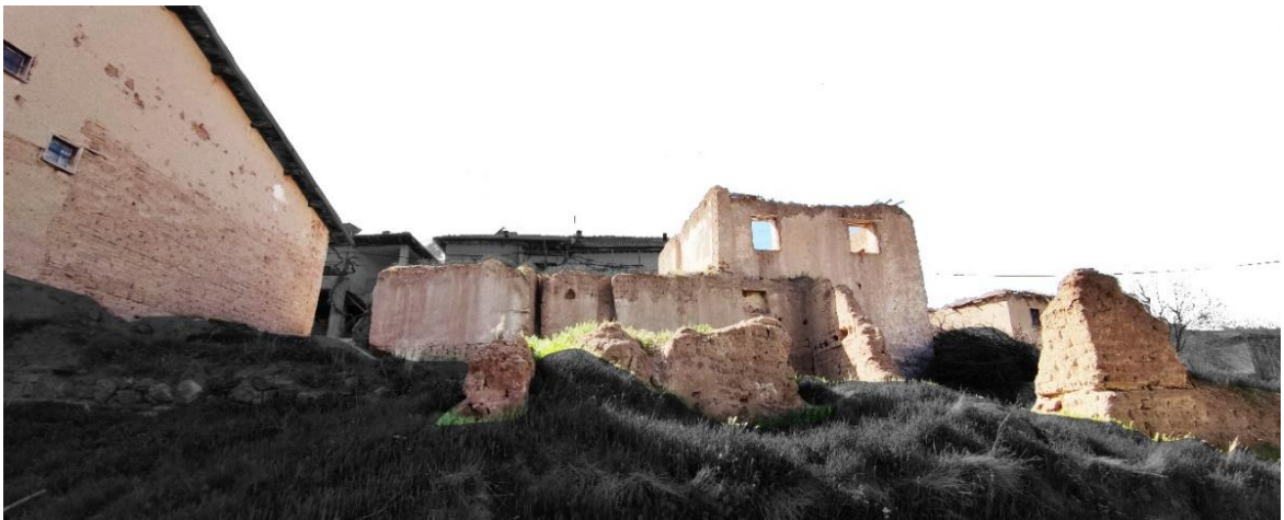
Şekil 4.125 : Ana yapılm malzemesi kerpiç olan geleneksel Kapıkaya konutları (Fotoğraf: Orjinal, 2021).
