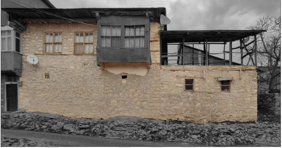
Şekil 4.81 : Ana yapım malzemesi taş olan yapıda mimari ve yapı elemanları imal etmede kaynak olan ahşap malzemeler (Fotoğraf: Orjinal, 2021).
