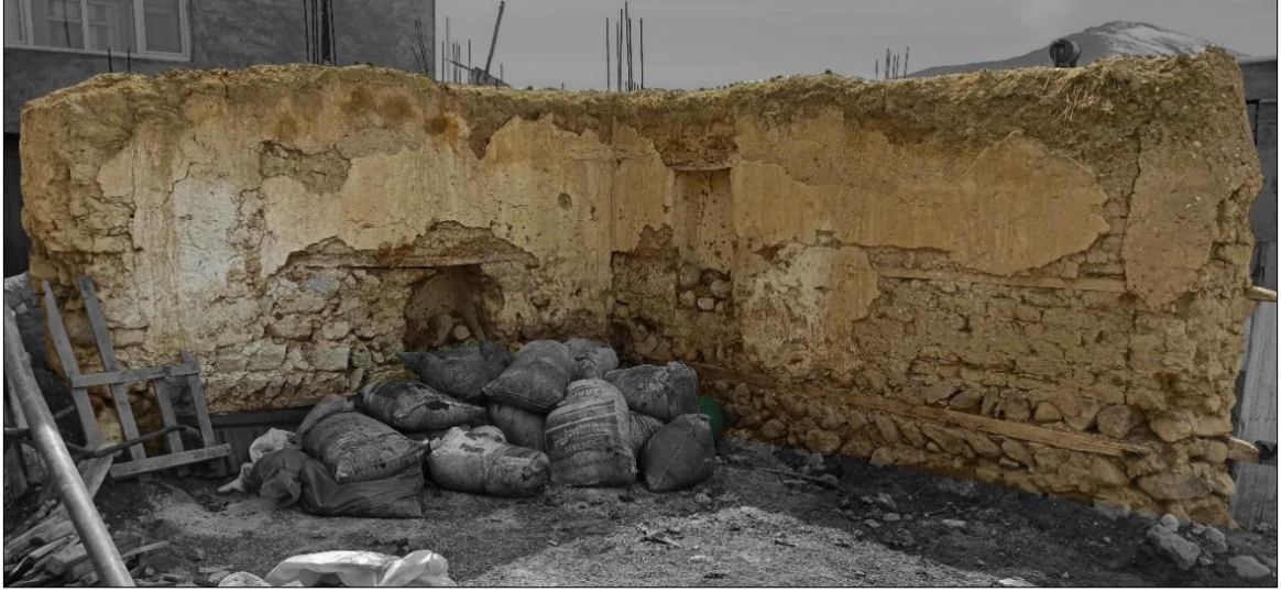
Şekil 4.7 : Cephe duvarlarında kullanılan taş, kerpiç ve ahşap malzemeler (Fotoğraf: Orjinal, 2021).
