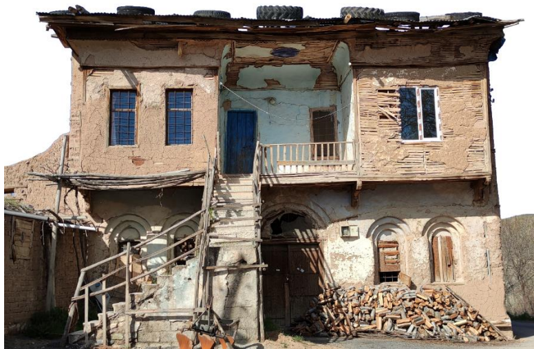
Şekil 4.133 : Yerleşimde yer alan diğer yapılardan farklı olarak üst katta bağdadi duvar bulunmaktadır (Fotoğraf: Orjinal, 2021).
