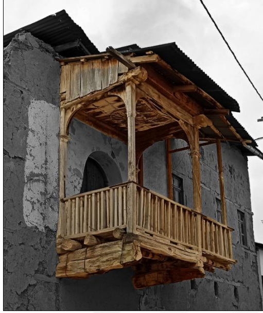
Şekil 4.39 : Ahşap malzemeden imar edilmiş, tavanında motiflere sahip cumba (Fotoğraf: Orjinal, 2021).
