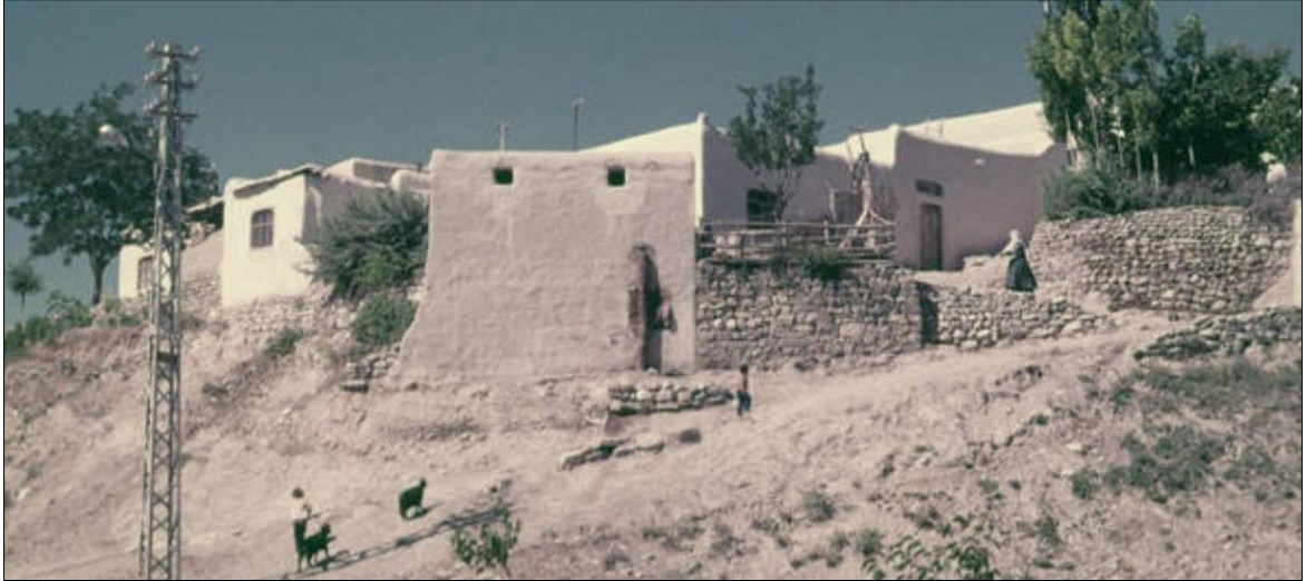
Şekil 4.17 : Dış cephelerine el ile sıva uygulaması yapılan Aşağılupınar geleneksel konutu (Örs Ali GÜMÜŞAY arşivi).
