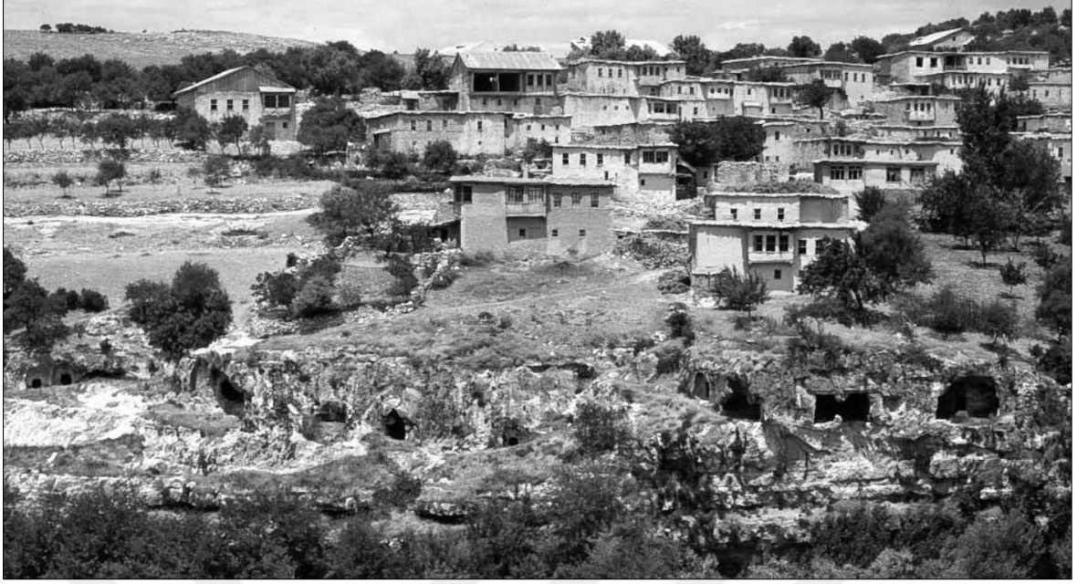
Şekil 4.69 : Güney yöne cephe veren vadi yamacı üzerindeki geleneksel yapılar ve kaya mezarları (Başgelen, 1983).
