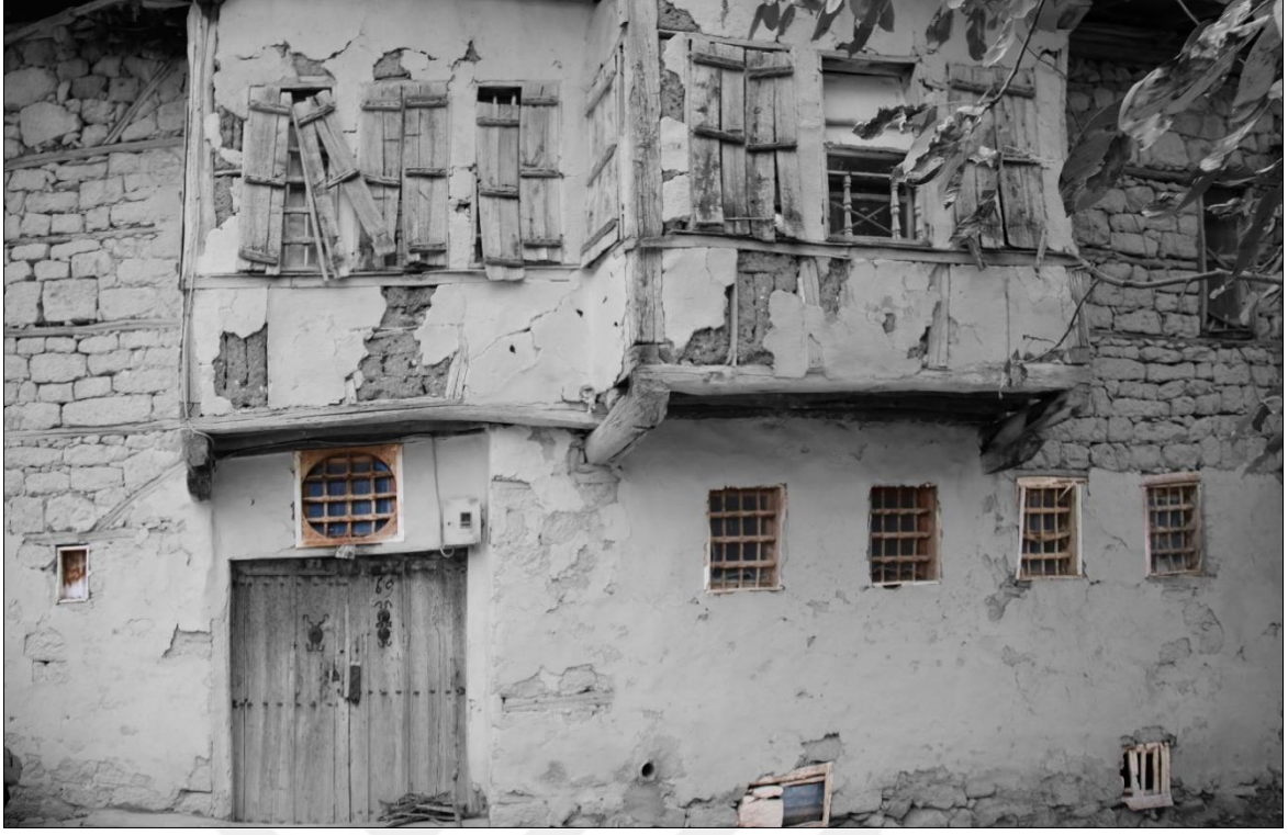
Şekil 4.89 : Zemin kat kotlarında yer alan, üst kattaki pencerelere göre daha küçük boyutlardaki pencereler (Fotoğraf: Orjinal, 2021).
