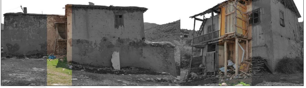
Şekil 4.114 : Yapıların  st kat kotlarında fonksiyona dahil edilen WC mahalleri (Fotoğraf: Orjinal, 2021).
