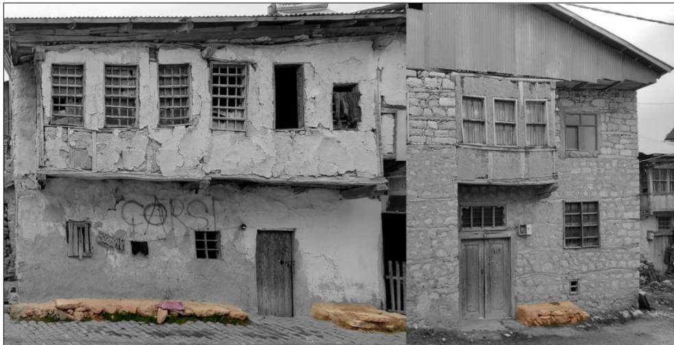
Şekil 4.59 : Kuru geleneksel konutları giriş cephelerinde bulunan sekiler (Fotoğraf: Orjinal, 2021).
