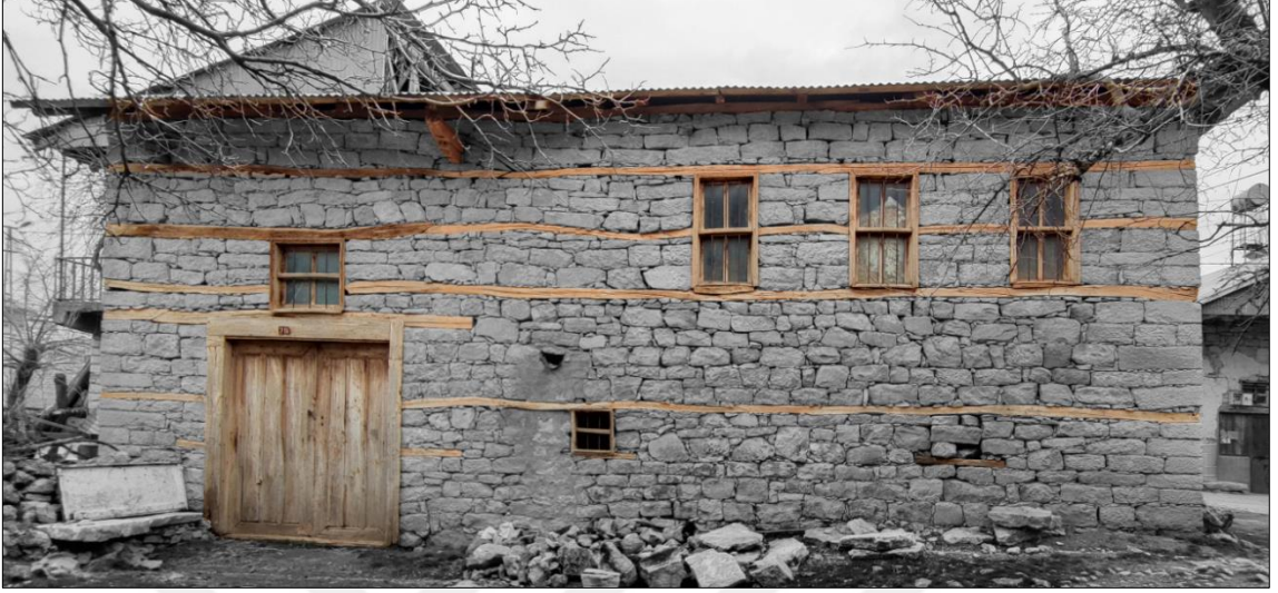
Şekil 4.51 : Yakın çevredeki bitki örtüsünden elde edilen ahşap malzeme ile imal edilmiş kapı, pencere ve arakalar (Fotoğraf: Orjinal, 2021).
