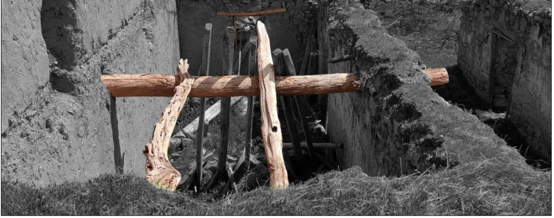
Şekil 4.106 : Taşıyıcı sistemin ahşap bileşenlerinden biri olan kirişler (Fotoğraf: Orjinal, 2021).
