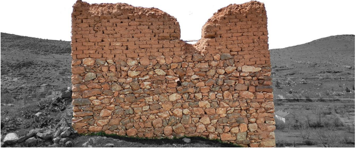
Şekil 4.101 : Bir arada kullanılan taş ve kerpiç malzeme (Fotoğraf: Orjinal, 2021).
