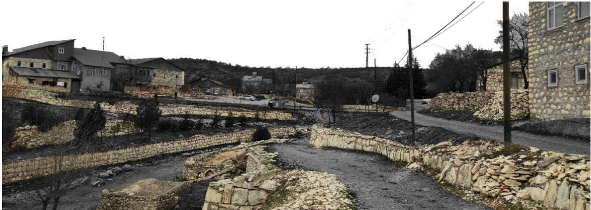
Şekil 4.70 : Onar kırsal yerleşiminde ihata ve istinat duvarları ile yapılarda kullanılan taş malzemeler (Fotoğraf: Orjinal, 2021).
