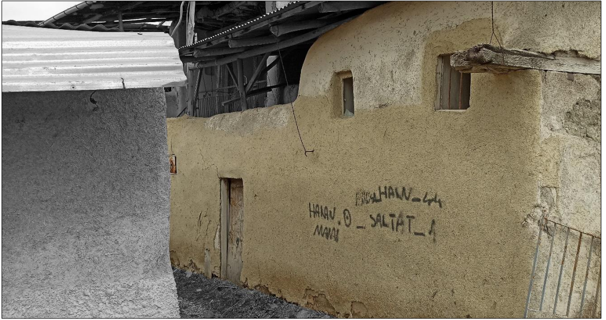
Şekil 4.13 : Zemin kat kotlarında yer alan pencereler (Fotoğraf: Orjinal, 2021).
