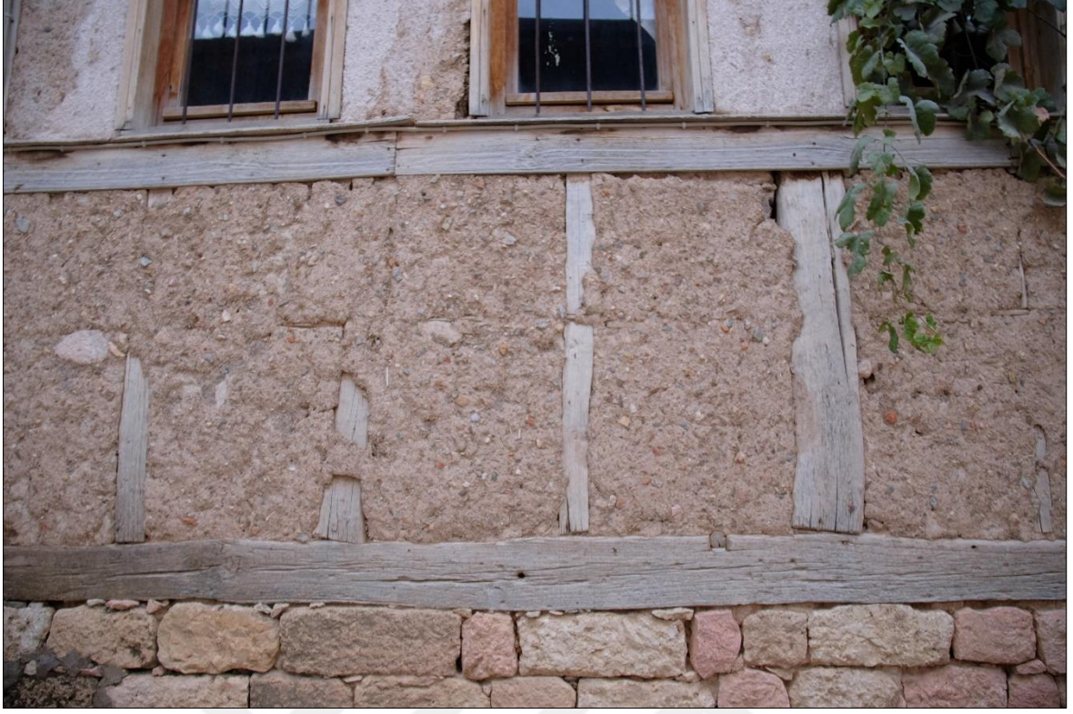
Şekil 4.95 : Ormansırtı geleneksel konutunda taş, ahşap ve toprak malzeme (Fotoğraf: Orjinal, 2021).
