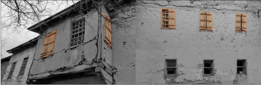
Şekil 4.54 : Üst kat kotlarındaki cumba ve cephe duvarlarındaki özgün ahşap kapaklar (Fotoğraf: Orjinal, 2021).
