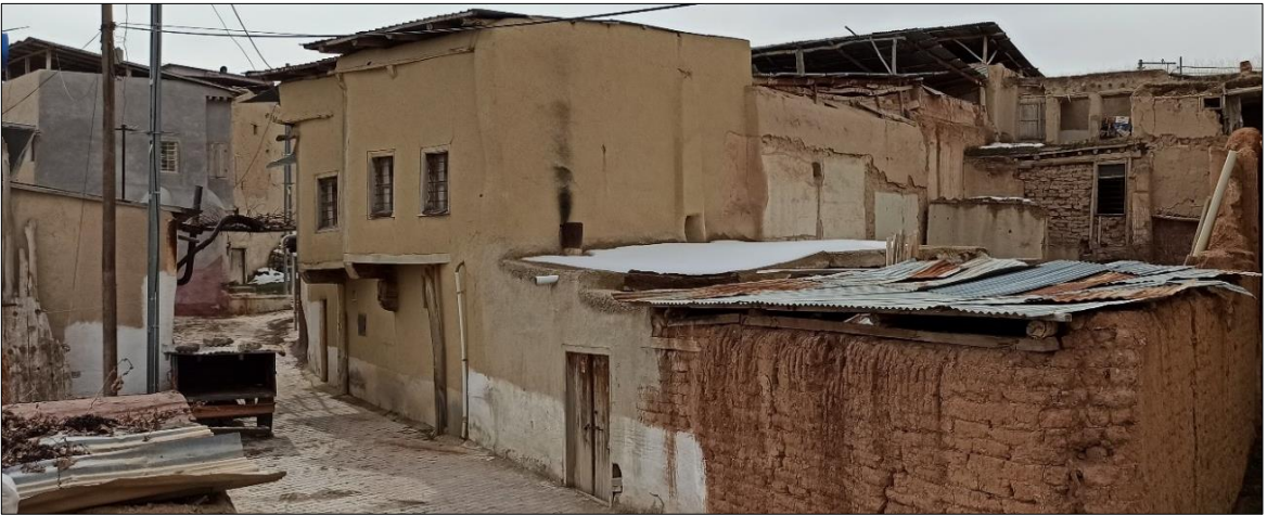
Şekil 4.30 : Zemin kat cephe duvarlarında bulunan az sayıdaki mimari elemanlar (Fotoğraf: Orjinal, 2021).
