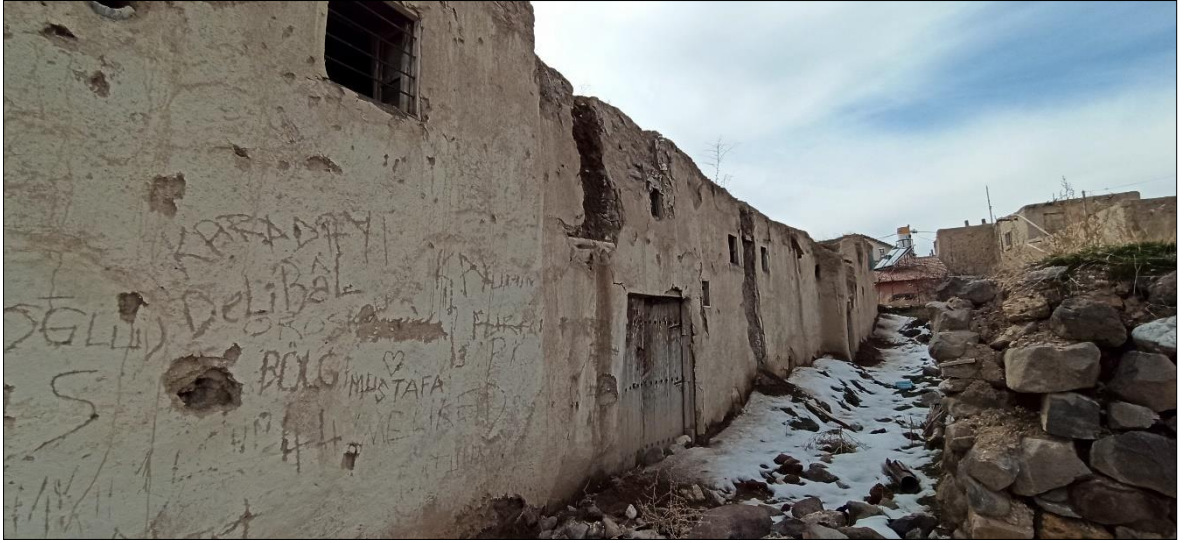
Şekil 4.35 : Zemin kat üst kotlarında yer alan küçük boyutlu pencereler (Fotoğraf: Orjinal, 2021).
