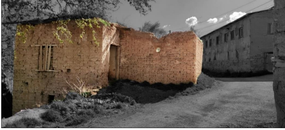
Şekil 4.132: Taşıyıcı cephe duvarlarında hatıl kullanılmayan geleneksel Kapıkaya konutu (Fotoğraf: Orjinal, 2021).
