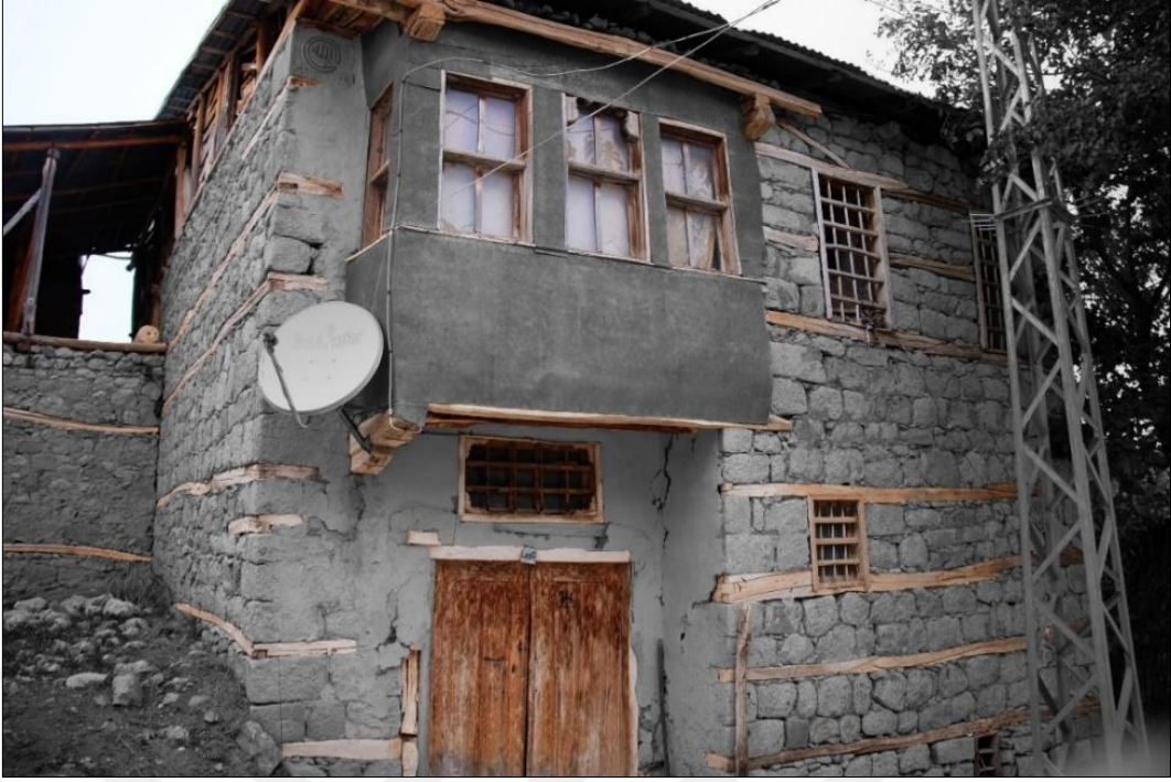
Şekil 4.87 : Taşıyıcı sistemin ahşap bileşenlerini oluşturan çıkmalar, hatıllar, kirişler (Fotoğraf: Orjinal, 2021).
