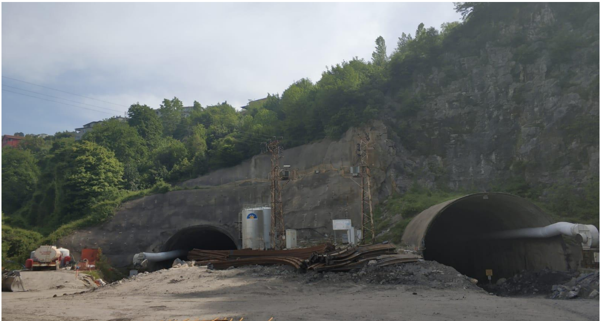
Şekil 3.3 Mithatpaşa-II Tüneli Bağlık Mevkii Girişi.
