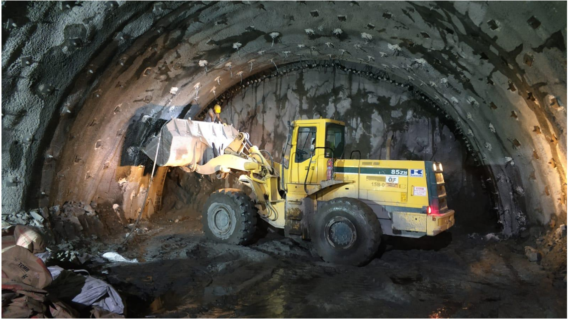
Şekil 2.11 NATM Yöntemi ile Açılan Mithatpaşa-II Tüneli Giriş Sol Tüp İbo Bulon Enjeksiyonu Çalışmasından Örnek.
