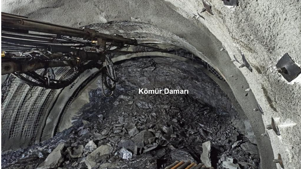
Şekil 5.13 Mithatpaşa-II Tünelinde Km: 35+067,45'de Gaz Ölçümünün Yapıldığı Kömürlü Ayna.
