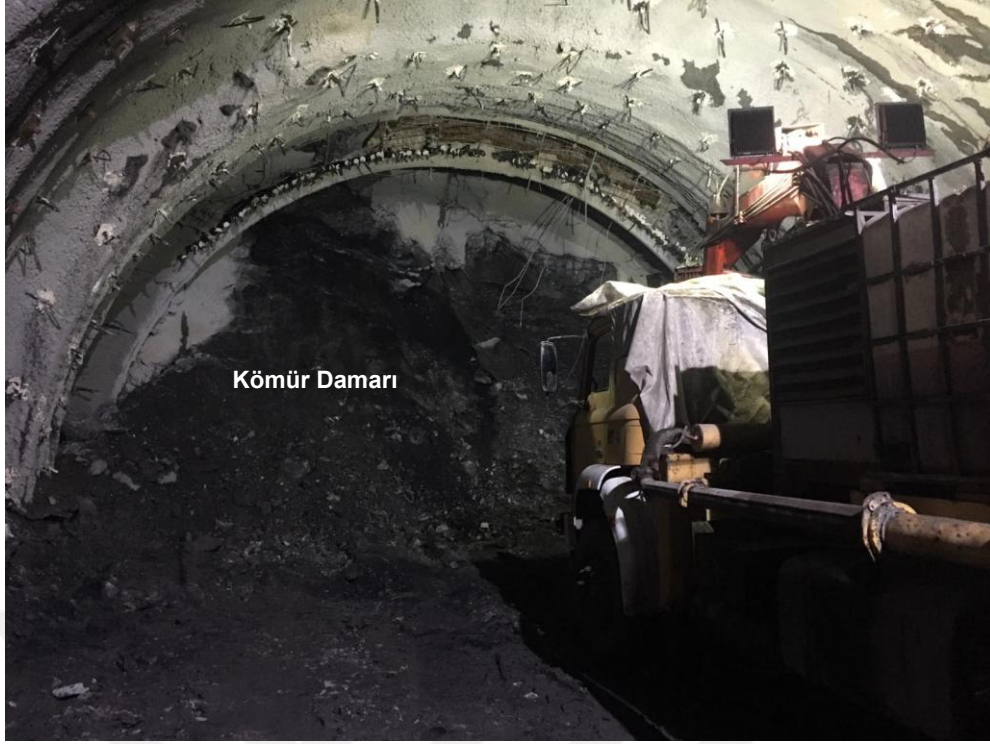
Şekil 5.12 Mithatpaşa-II Tünelinde Km: 35+066,70'de Gaz Ölçümünün Yapıldığı Kömürlü Ayna.
