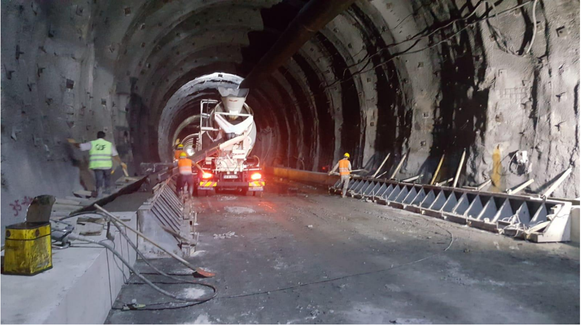
Şekil 2.13 NATM Yöntemi ile Açılan Mithatpaşa-II Tüneli Giriş Sol Tüp Sağ-Sol Taraf Kiriş Betonu ( C 30/37) Çalışmasından Örnek.
