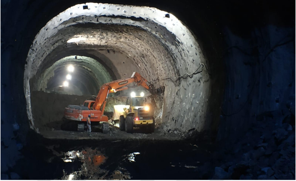
Şekil 2.10 NATM Yöntemi ile Açılan Mithatpaşa-II Tüneli Giriş Sağ Tüp Sağ taraf Alt Yarı Kazı Destekleme Çalışmasından Örnek.
