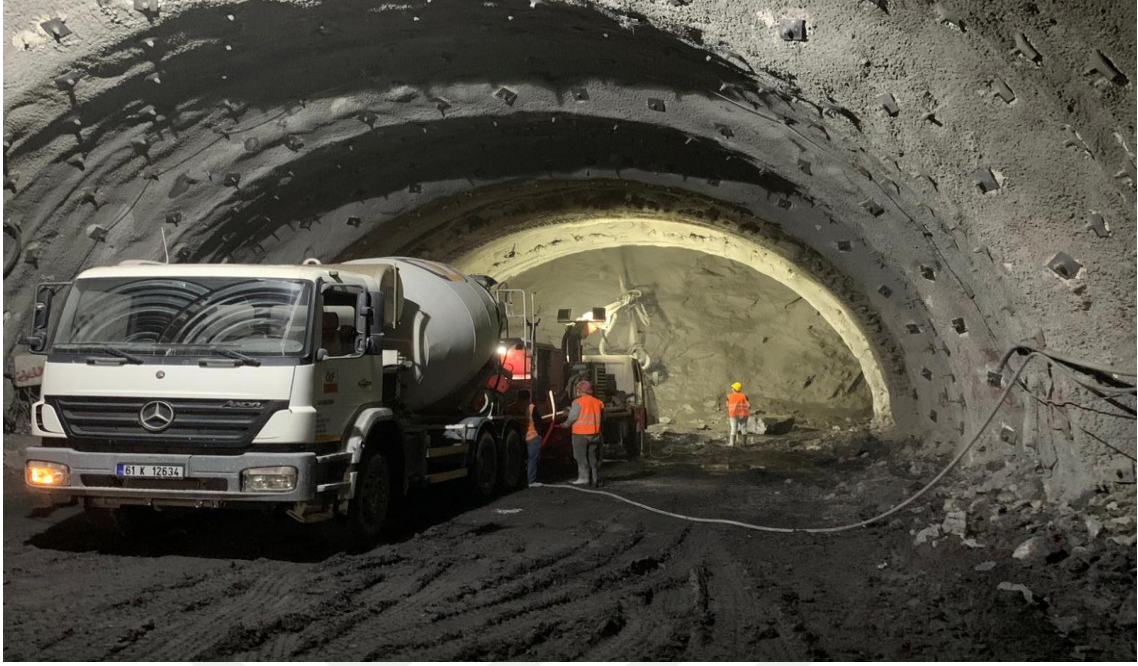
Şekil 2.14 NATM Yöntemi ile Açılan Mithatpaşa-II Tüneli Giriş Sağ Tüp Üst Yarı Püskürtme Betonu (C 25/30 Sınıfı) Çalışmasından Örnek.
