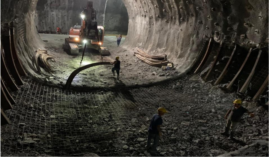
Şekil 2.9 NATM Yöntemi ile Açılan Mithatpaşa-II Tüneli Giriş Sol Tüp 2.Araç Geçiş İvert İksaKurulumu Çalışmasından Örnek.
