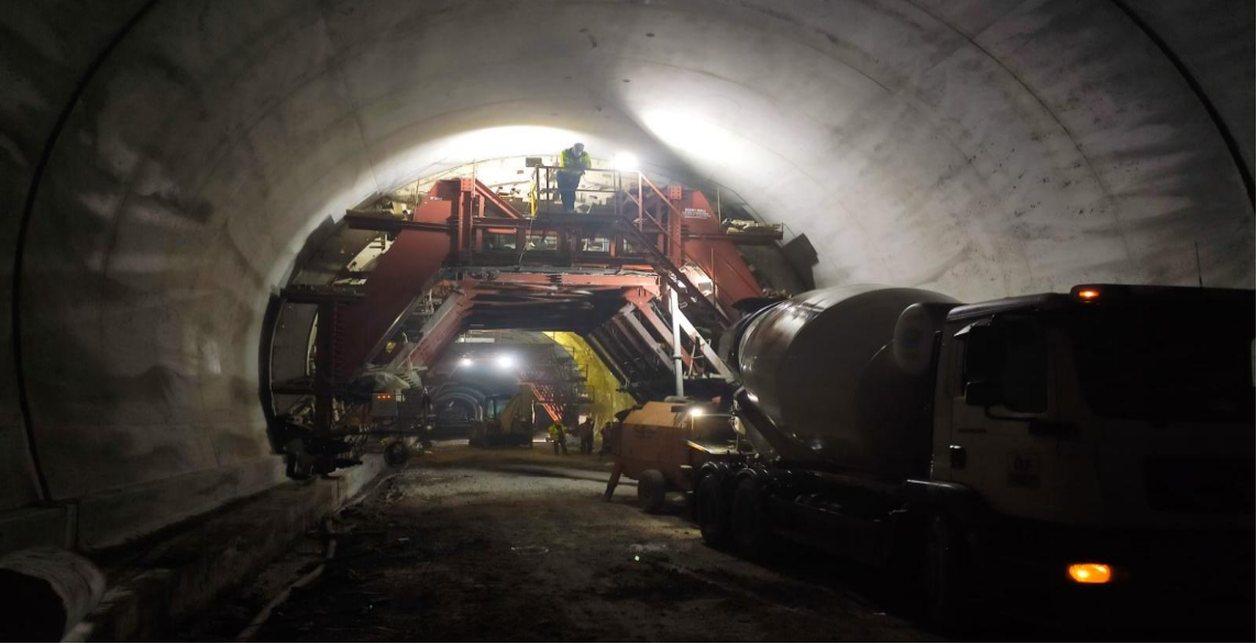
Şekil 2.15 NATM Yöntemi ile Açılan Mithatpaşa-II Tüneli Giriş Sol Tüp 12.Ano Nihai Kaplama Betonu (C 30/37 Sınıfı) Çalışmasından Örnek.
