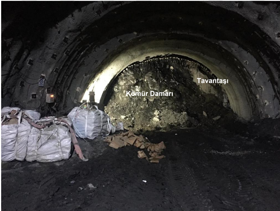
Şekil 5.11 Mithatpaşa-II Tünelinde Km: 35+064,45’de Gaz Ölçümünün Yapıldığı Kömürlü Ayna.
