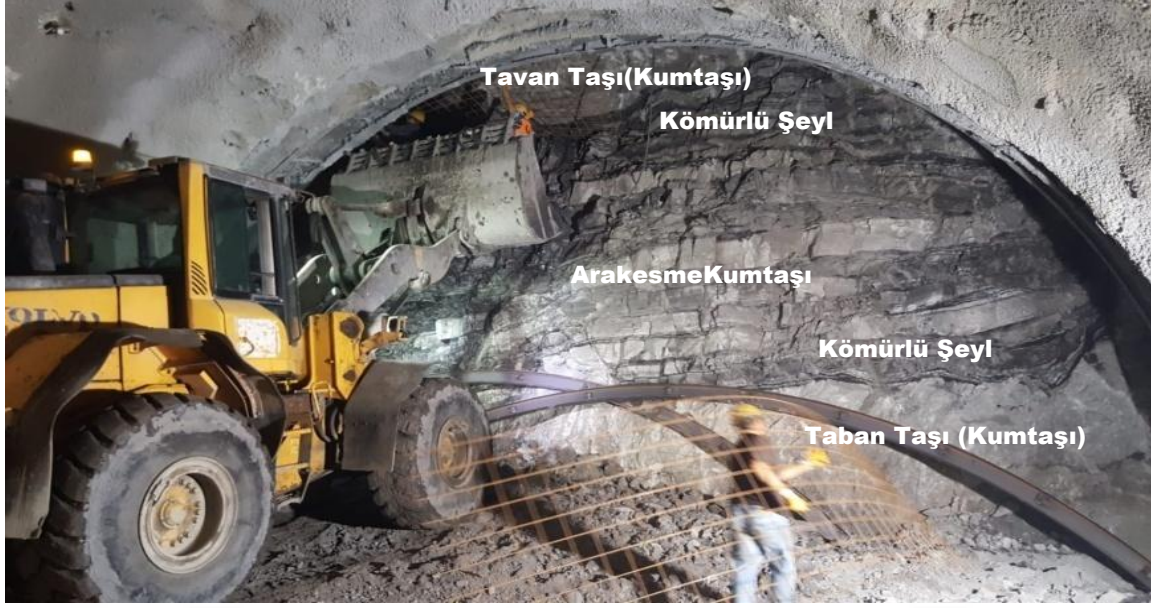
Şekil 2.6 NATM Yöntemi ile Açılan Mithatpaşa-II Tüneli Kömürlü Aynada İksa Destekleme Çalışmasından Örnek.
