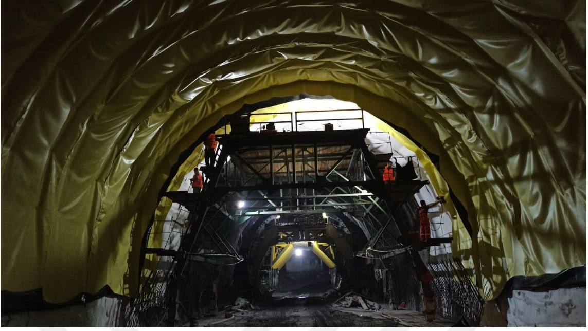
Şekil 2.12 NATM Yöntemi ile Açılan Mithatpaşa-II Tüneli Giriş Sağ Tüp Keçe-Membran İmalatı Çalışmasından Örnek.
