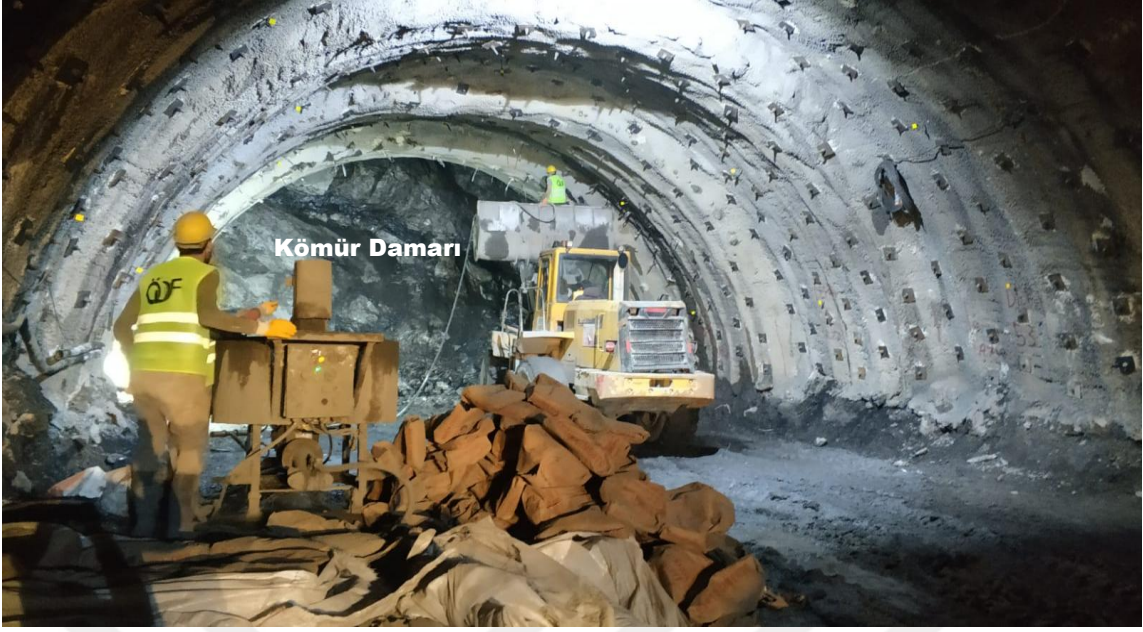
Şekil 2.8 NATM Yöntemi ile Açılan Mithatpaşa-II Tüneli Kömürlü Aynada İbo Bulon Enjeksiyonu İksa Çalışmasından Örnek
