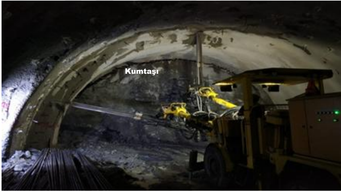
Şekil 2.5 NATM Yöntemi ile Açılan Mithatpaşa-II Tünel Açıklığının İbo Bulon Destekleme İksa Çalışmasından Kumtaşında Örnek.
