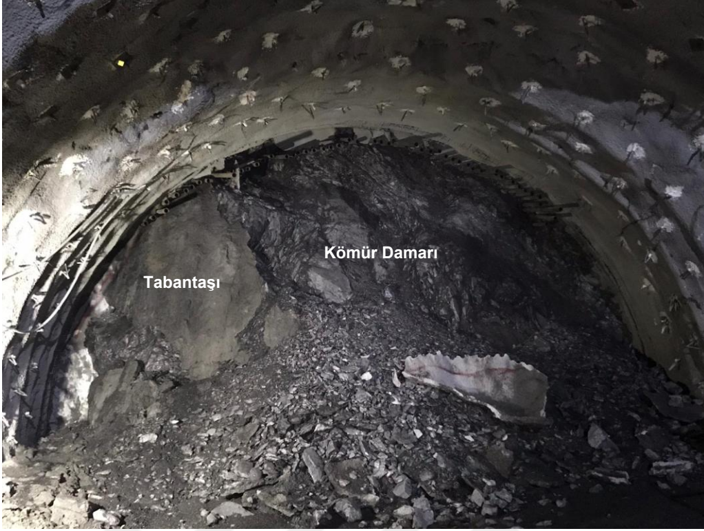
Şekil 5.10 Mithatpaşa-II Tünelinde Km: 35+014,95’de Gaz Ölçümünün Yapıldığı Kömürlü Ayna.
