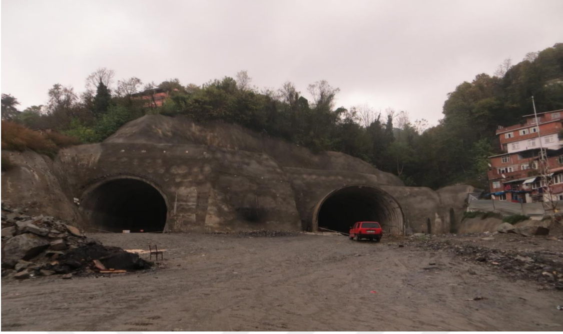
Şekil 3.4 Mithatpaşa-II Tüneli Zonguldak İkinci Makas Çıkışı.
