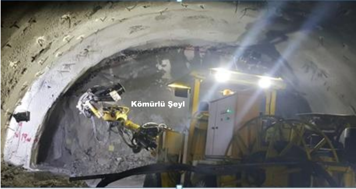
Şekil 2.7 NATM Yöntemi ile Açılan Mithatpaşa-II Tüneli Kömürlü Aynada Umbrella Destekleme Çalışmasından Örnek.
