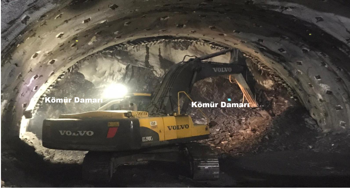
Şekil 2.4 NATM Yöntemi ile Açılan Mithatpaşa-II Tüneli Üst Yarı Kömürlü Ayna Kazısı Çalışmasından Örnek.
