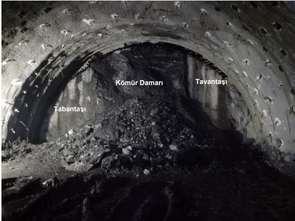
Şekil 5.9 Mithatpaşa-II Tünelinde Km: 34+988,70'de Gaz Ölçümünün Yapıldığı Kömürlü Ayna.
