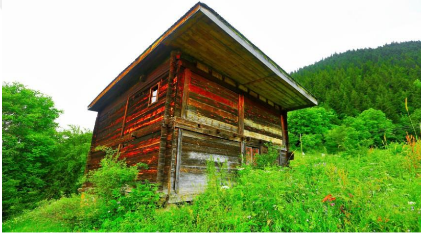
Resim 13: Veliköy Eski Ahşap Cami
