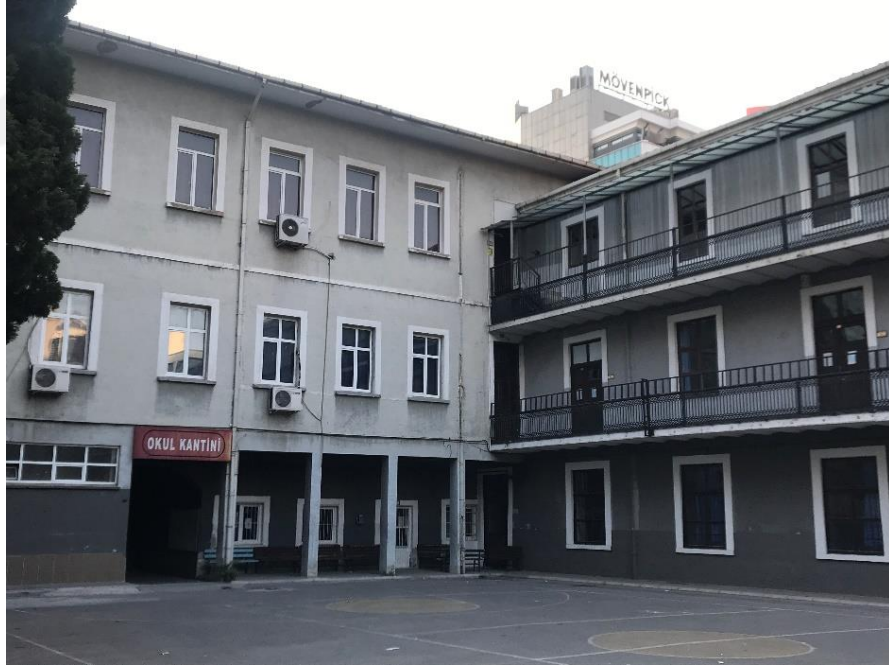
Şekil 5.33: Okulun sonradan betonarme olarak inşa edilen ve günümüzde zemin katı kantin olarak kullanılan ek binası (Ş.Güneş, 2021).
