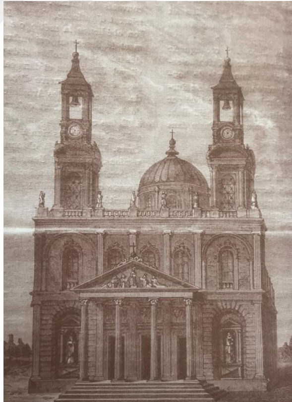
Şekil 5.20: St. Jean Katedrali kuzey cephesi (Marmara (2016, s.246) kitabında görsele dair kaynak belirtmemiştir).
