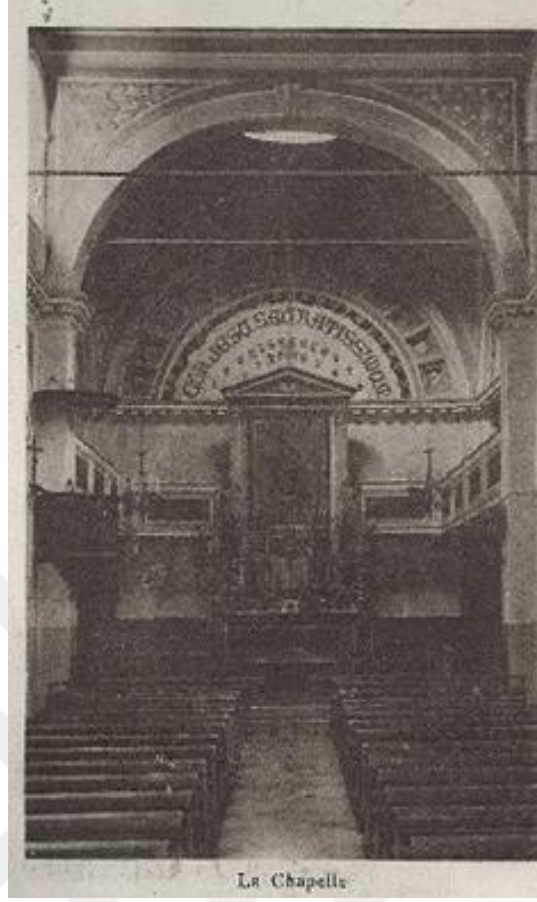
Şekil 5.16: Yangın öncesi Lazarist Kilisesi içine dair görsel (URL – 5).
