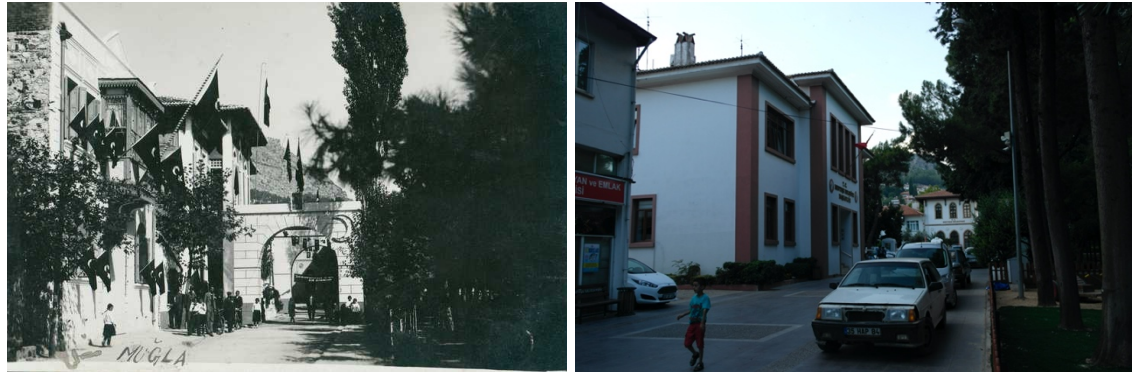
Görsel 3.26. (sol) Solda Belediye Binası ve sağda Belediye Parkı, ilerde sonda Hususi Muhasebe Binası: Resmi tören (İBB Atatürk Kitaplığı Dijital Arşivi); (sağ) Solda Belediye Binası sağda Belediye Parkı (Güven Ulusoy, 2019)
