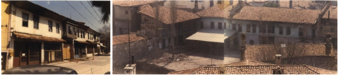
Görsel 3.19. Konakaltı Hanı'nın restorasyon öncesi sokak cephesinden (sol) ve avlusundan (sağ) görünümü (Muğla Kültür Varlıklarını Koruma Bölge Müdürlüğü Arşivi)
