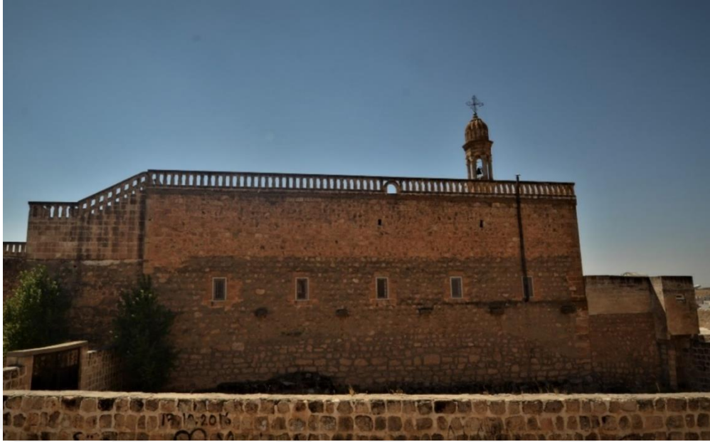
Resim 60. Kilisenin kuzey cephesi, kuzeyden görünüm (Alp, 2019).
