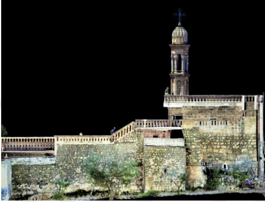
Resim 61. Yapı topluluğunun doğu cephesi, doğudan görünüm (Ortografik Görüntü - 2021).
