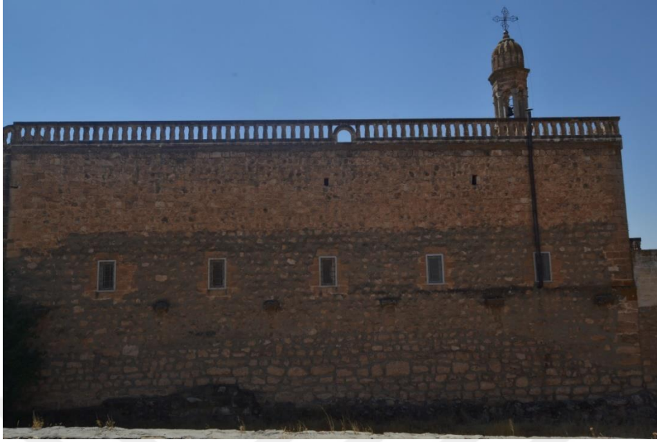
Resim 92. Kuzey cephedeki horosan harcı ve çimento örneği (Alp, 2021).
