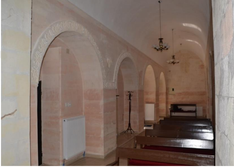
Resim 21. Narteksin güney duvarı, kuzeydoğudan bakış (Alp, 2021).
