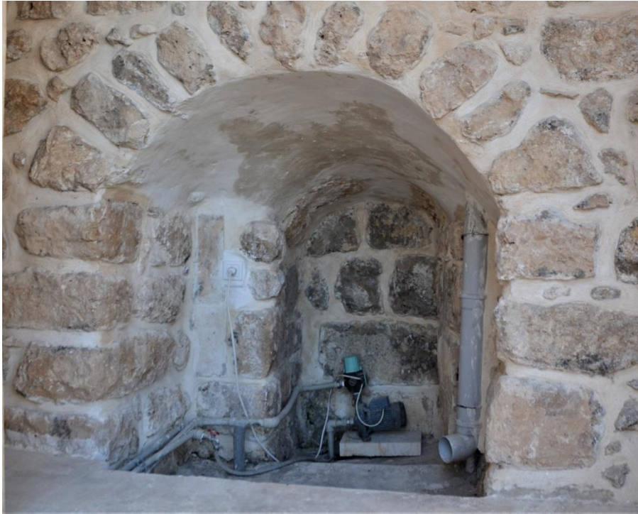
Resim 94. Güney cephede yer alan kuyu, kuzeyden görünüm (Alp, 2021)
