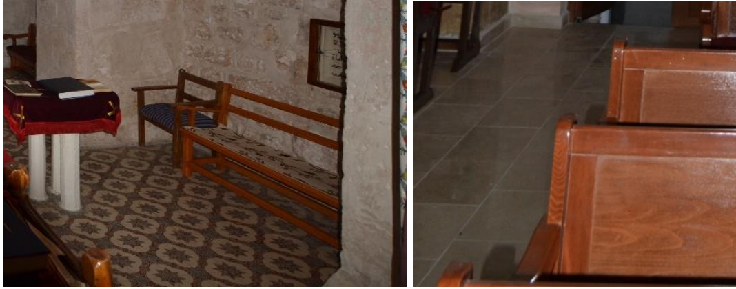
Resim 129.Naosun onarım öncesi zemini (Alp, 2019), onarım sonrası zemin (Alp, 2021).
