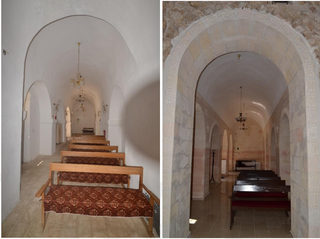
Resim 130. Narteks (onarım öncesi (Alp,2019), onarım sonrası (Alp, 2021)) doğudan görünüm.
