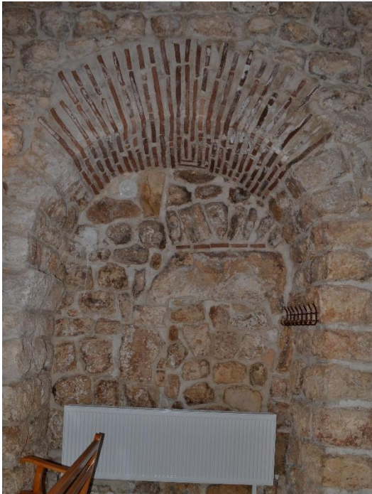
Resim 118. A Şapeli, güney duvarında yer alan kapı kalıntısı (Alp, 2021).
