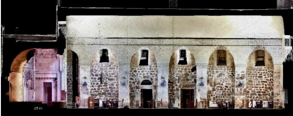
Resim 108. Kilise naosunun güney duvarında yer alan arkadlı niş düzenlemesi, kuzeyden görünüm (Ortografik Görüntü, 2021).
