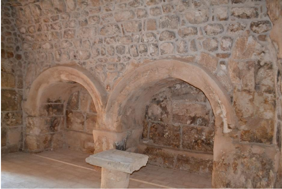
Resim 35. B Şapeli kuzey duvarı, apsisin güneydoğusundan görünüm (Alp, 2021).
