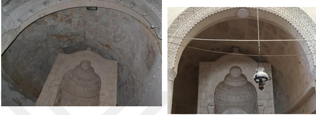
Resim 126. Kilisenin apsisi (onarım öncesi 2018 – onarım sonrası 2021).
