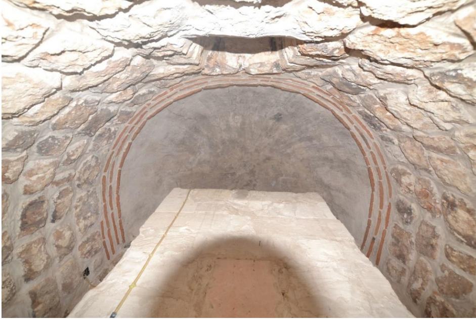
Resim 88. A Şapelinin apsisi, beden duvarları kaba yonu taş, yarım kubbeye geçişte tuğla, yarım kubbe sıva ile kaplanmıştır (Alp, 2021).
