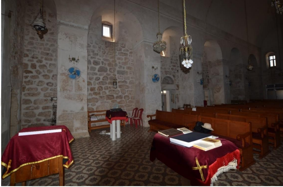
Resim 13. Naosun güney duvarı, apsisin kuzeydoğusundan görünüm (Alp,2019).
