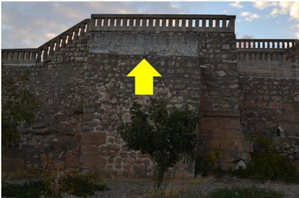
Resim 93. Briket teras 9'ün çevresinde kullanılarak parapet görevi görmüştür.
