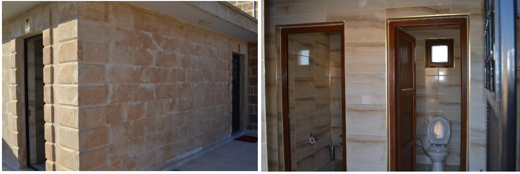
Resim 55. E1 Mekanı'nın güneyinde yer alan tuvalet ve lavabolar (Alp, 2021).
