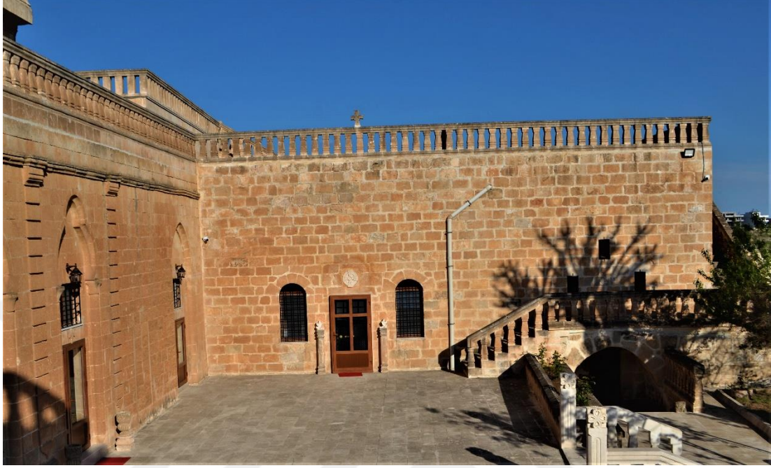
Resim 69. Avlunun doğu cephesi, batıdan görünüm (Alp, 2019).
