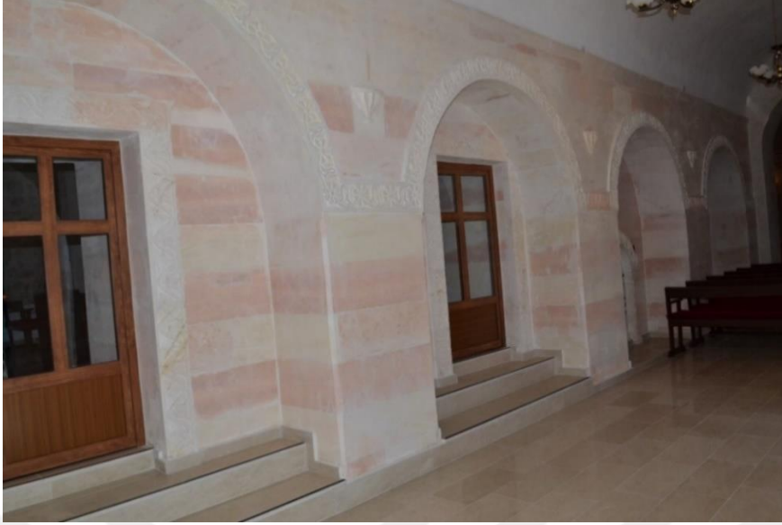
Resim 19. Narteksin kuzey duvarı, güneybatıdan görünüm (Alp, 2021).
