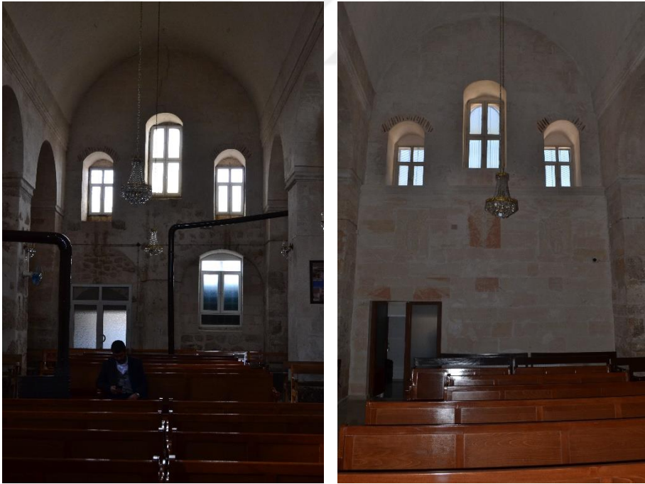
Resim 125. Kilisenin batı duvarı, (2018 onarım öncesi, 2021 onarım sonrası).
