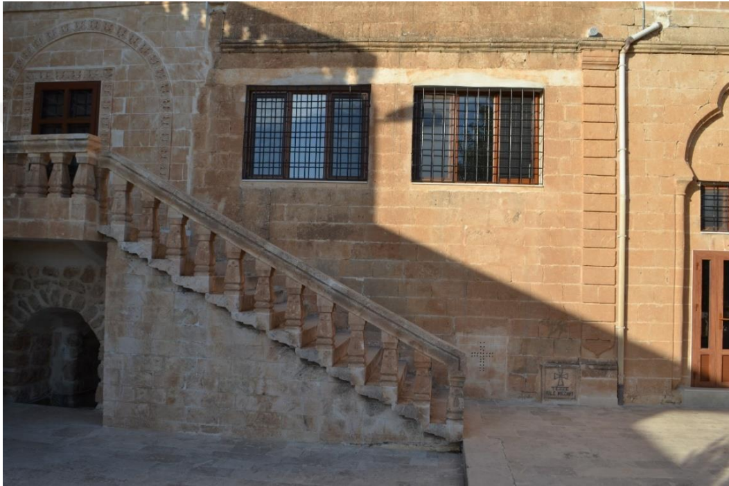
Resim 68. Giriş kapılarının batısı, üst kata çıkılan merdivenlerin ayrıntılı görünümü, avlunun güneyinden görünüm (Alp, 2021).
