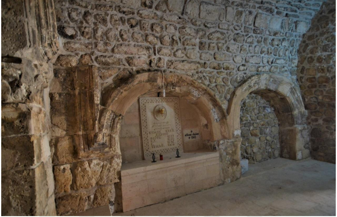
Resim 37. B Şapeli, güney duvarı, apsisin kuzeydoğusundan görünüm (Alp, 2021).
