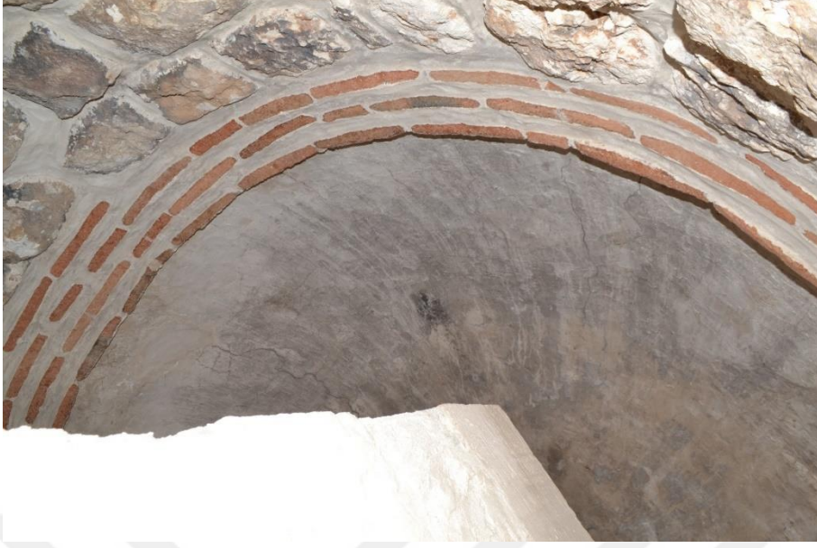
Resim 87. Kilise, apsis yarım kubbesine geçişte kullanılan tuğla malzeme (Alp, 2019).
