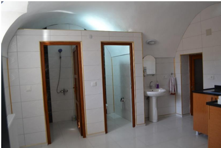
Resim 47. Mutfakın kuzeyinde yer alan tuvaletler, güneybatıdan görünüm (Alp, 2021).
