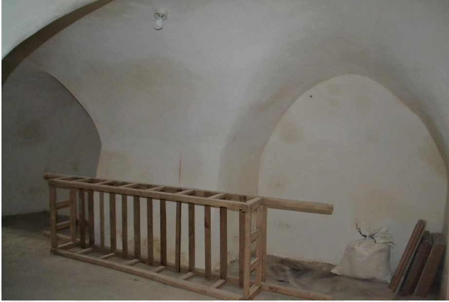
Resim 40. Kuzey duvarı, güneydoğudan görünüm (Alp, 2021).
