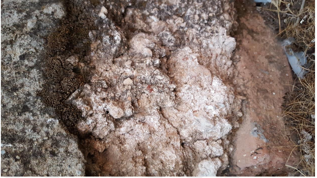
Resim 90. A3 Mekanı kalıntısı, güney duvarında yer alan harç örneği (Alp, 2021).
