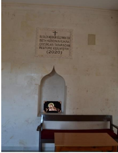
Resim 52. E mekânının kuzey duvarında yer alan niş ve üstündeki onarım bilgisi (Alp, 2021).
