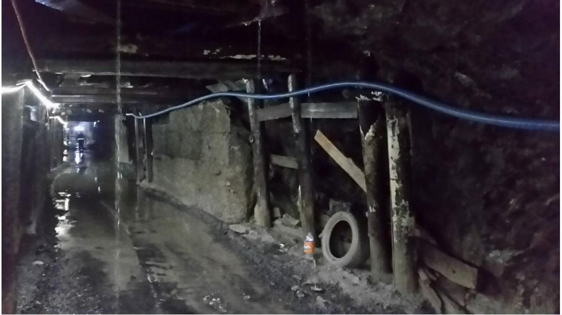
Şekil 5.2. KEF 1082 Galerisi içerisindeki yoğun su çıkışı olan alanlar
