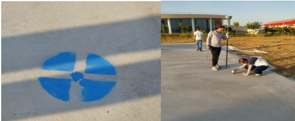
Şekil 3.10. Ayak noktalarının beton zeminde yerlerinin belirlenmesi
