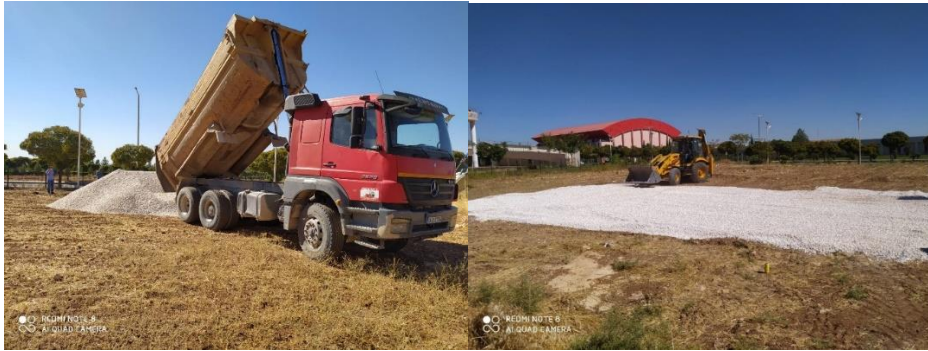
Şekil 3.5. Toprak zemine çakıl kumun serilmesi
