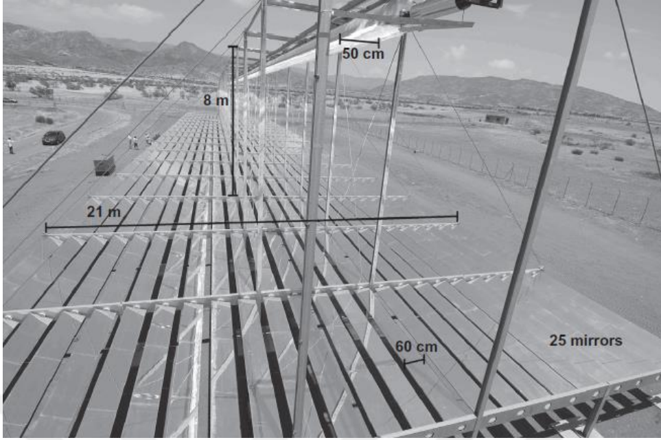
Şekil 2.14. Ana geometrik özelliklere sahip bir fresnel kollektör (Abbas, 2015)
