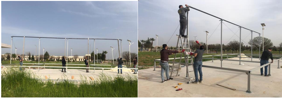
Şekil 3.28. Seçici soğurucu kaplı bakır boruların güneş kolektörüne montajı
