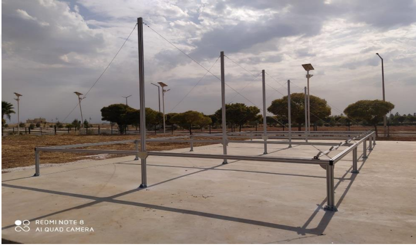
Şekil 3.13. Fresnel kolektörün alt konstrüksiyon kurulumu
