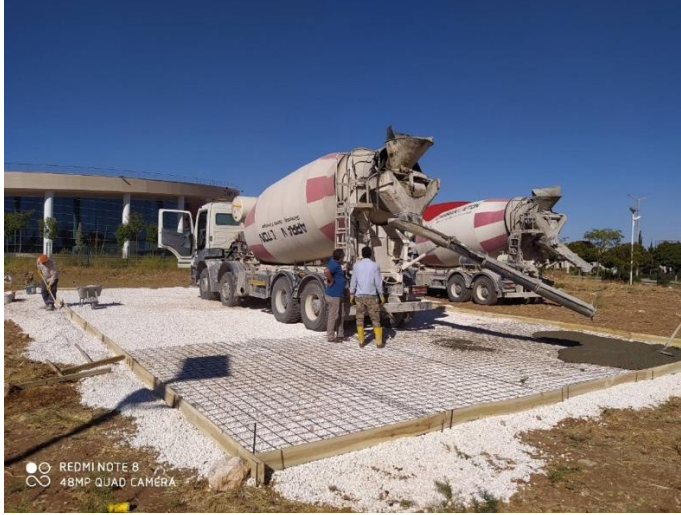
Şekil 3.6. Kalıp içine hasır demirin bağlanması
