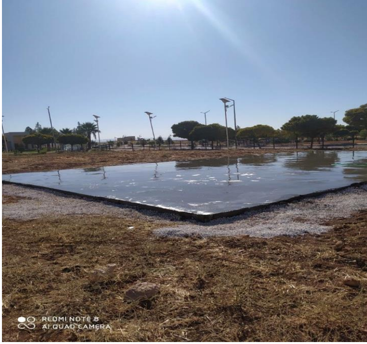
Şekil 3.8. Beton zeminin son hali
