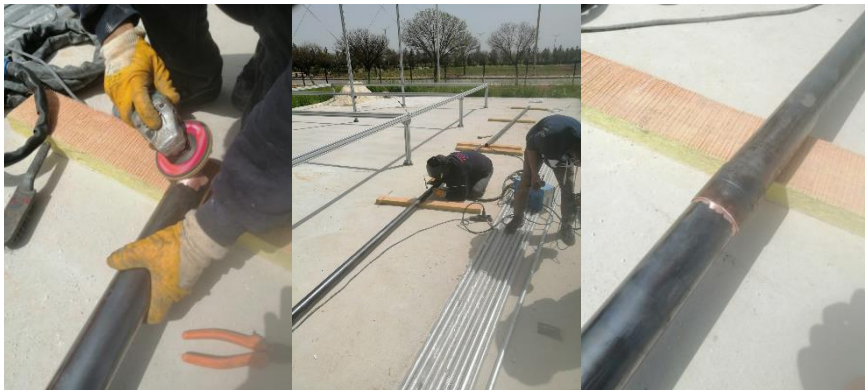
Şekil 3.26. Absorber boru imalatı çalışmalarını gösteren resimler
