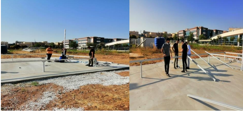
Şekil 3.12. Lineer Fresnel Kolektör Konstrüksiyon kurulumu
