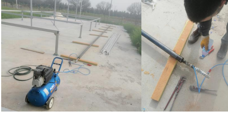
Şekil 3.27. Absorber boruya sızdırmazlık testi yapılması
