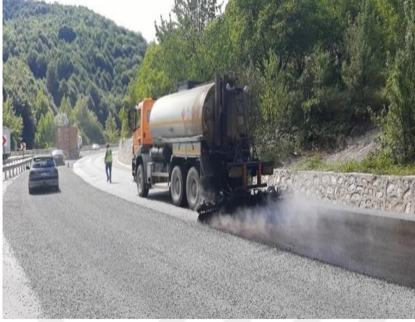
Şekil 2.3. Asfalt Distribütörü
