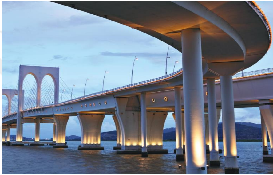
Şekil 1.3. CTP profillerle üretilmiş hafif yapı [8].
