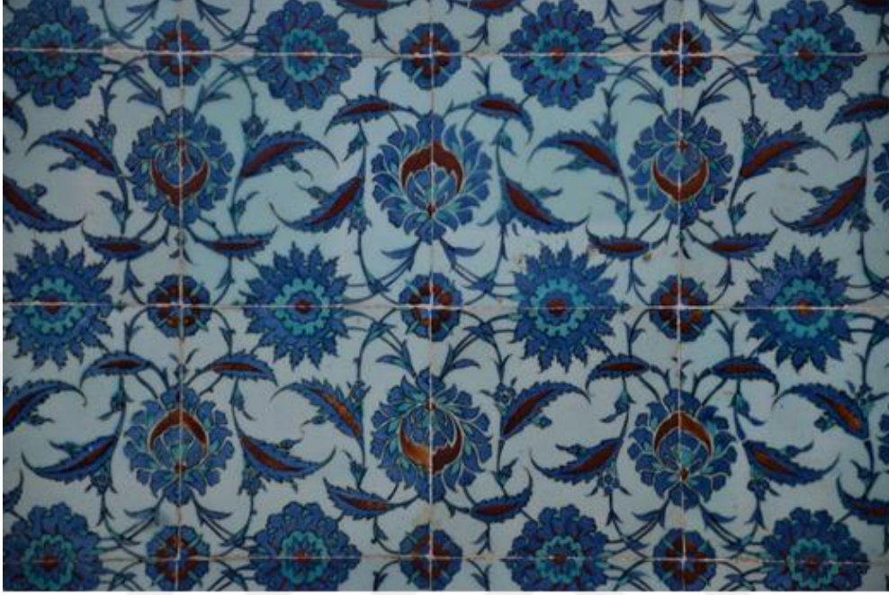
Fotoğraf No 47. Harimin Doğu ve Batı Cephe Duvar Yüzeyi Çini Karo Detayı (B. Alat, 2020)
