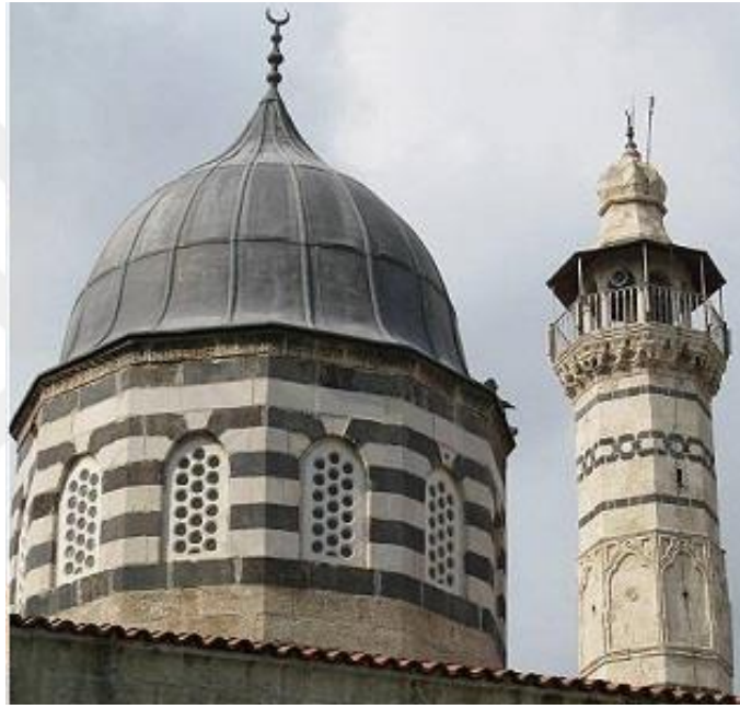
Fotoğraf No 24. Camii Minaresi ve Mihrap Önü Kubbe Kasağı (Okuryazarım, 2016)
