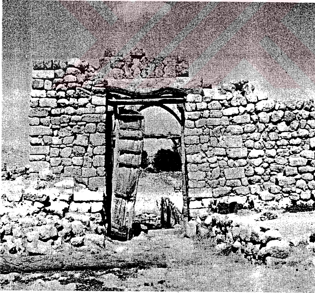
Şekil 2.19 Mardin Taceddin Mesud Med., 1211 Geçmeli düzatkinın arkadan görünüşü (Kuran 1969)
