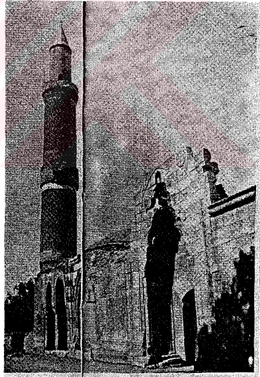
Şekil 2.48 Akşehir Taş Medrese, 1250 20. yy başındaki durumu (Altun 1988)
