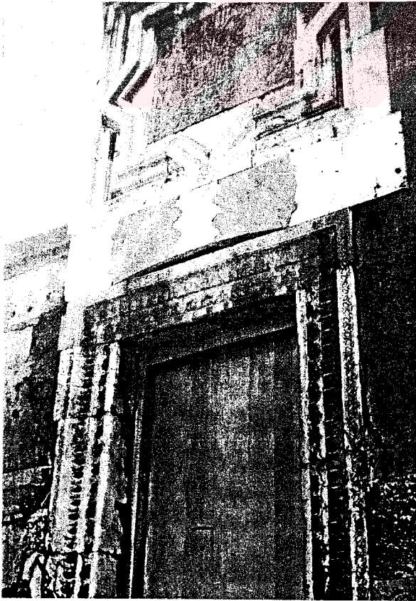
Şekil 2.13 Konya Alaeddin Camisi, 1155-1220 Avlu doğu-kapısı geçmeli düzatki
