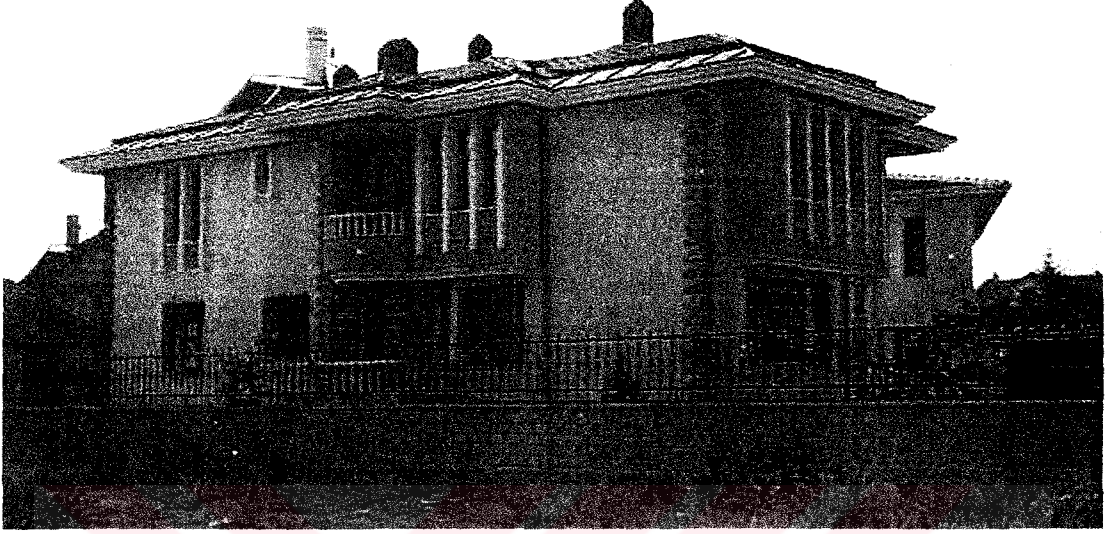
Resim 5.5 Beş nolu örnek ev
