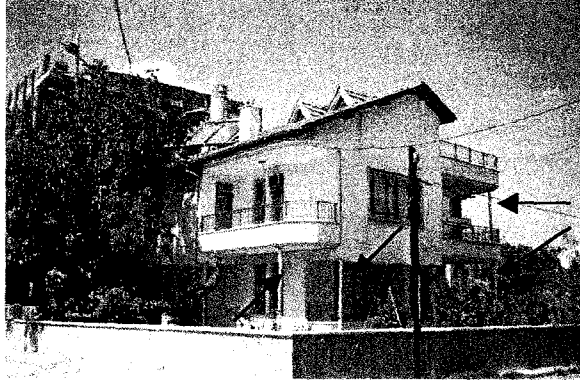
Resim 5.1 Kullanıcının konutunun depreme dayanıksız olduğunu düşünen tüm konsolların altına boru dikmeler koyarak yaptığı değişiklik (1 nolu örnek ev)
