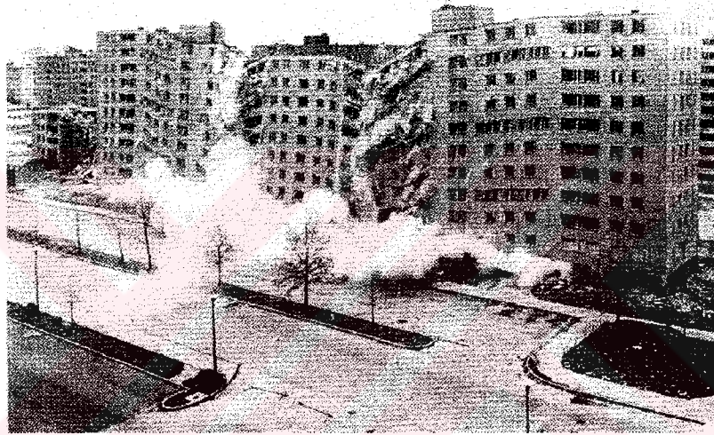
Resim 2.1 İlk sahiplerince terk edilmiş Pruitt Igoe toplu konutları (Karaman 1991)
