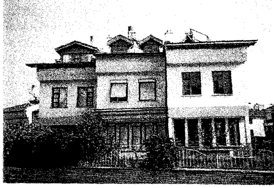
Resim 5.12 Kullanıcılar çatıda düzenlenen odayı büyütmek amacıyla çatıda değişik uygulamalarda bulunmuşlardır (9. örnek)
