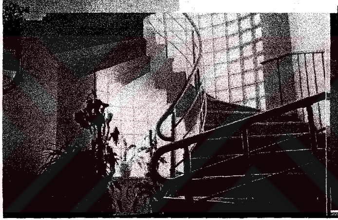
Resim 5.10 Kullanıcı merdiven kovanındaki cam tuğlalardan kullanıcı şikayetçidir (8. örnek)
