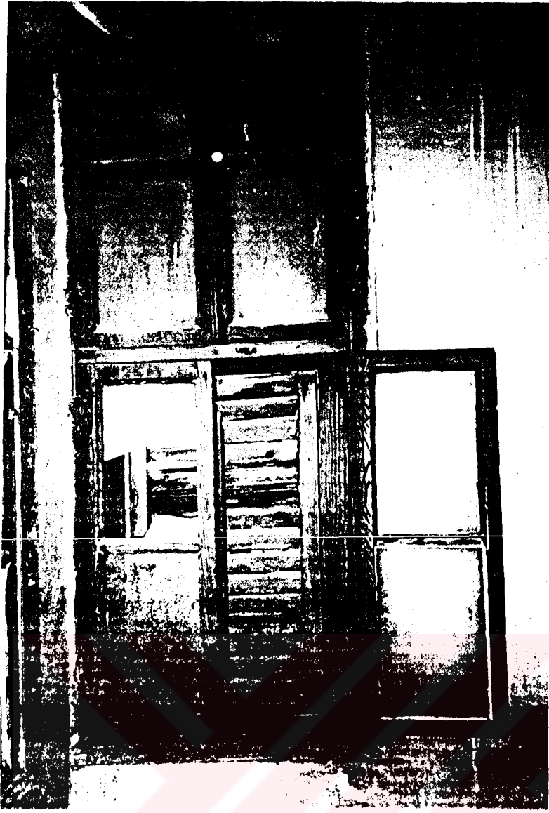
Şekil A. 2. 131. Üst kat Ü15(Oda) doğu duvarındaki pencere
