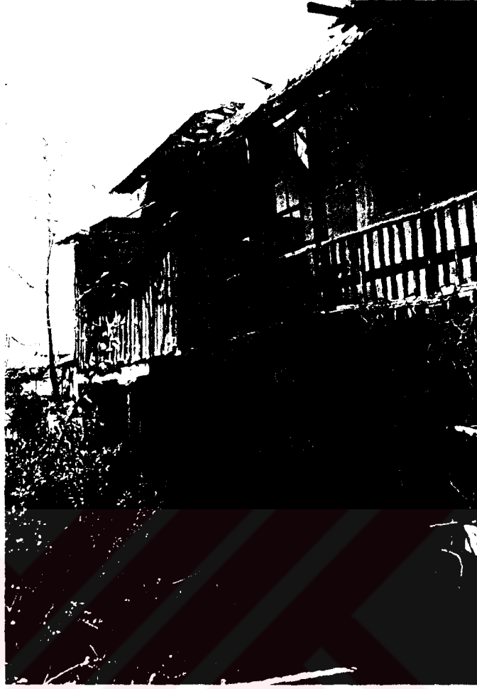
Şekil A. 2. 163. Gezintiyi taşıyan ahşap dikme
