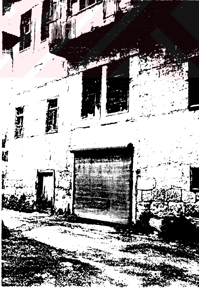
Şekil A. 2. 31. Doğu cephesi, zemin kat Z6(depo) girişi
