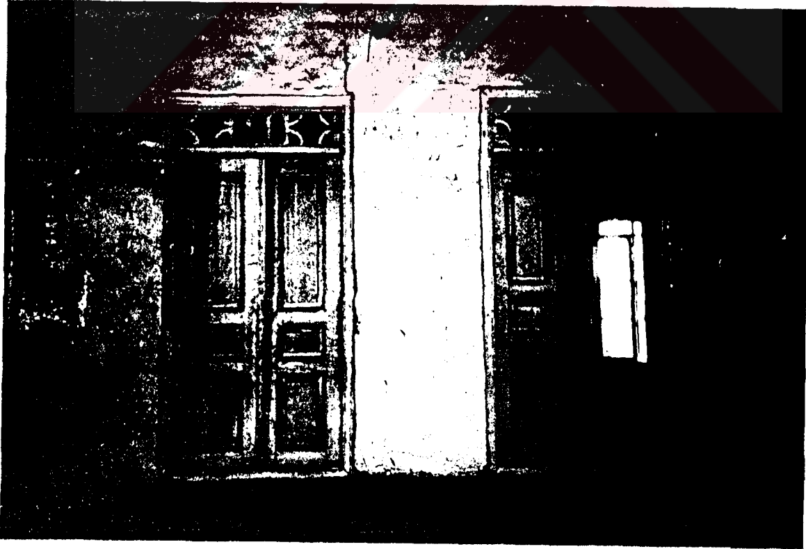
Şekil A. 2. 88. Üst kat Ü3(Oda) ve Ü4(Oda)'ün giriş kapıları
