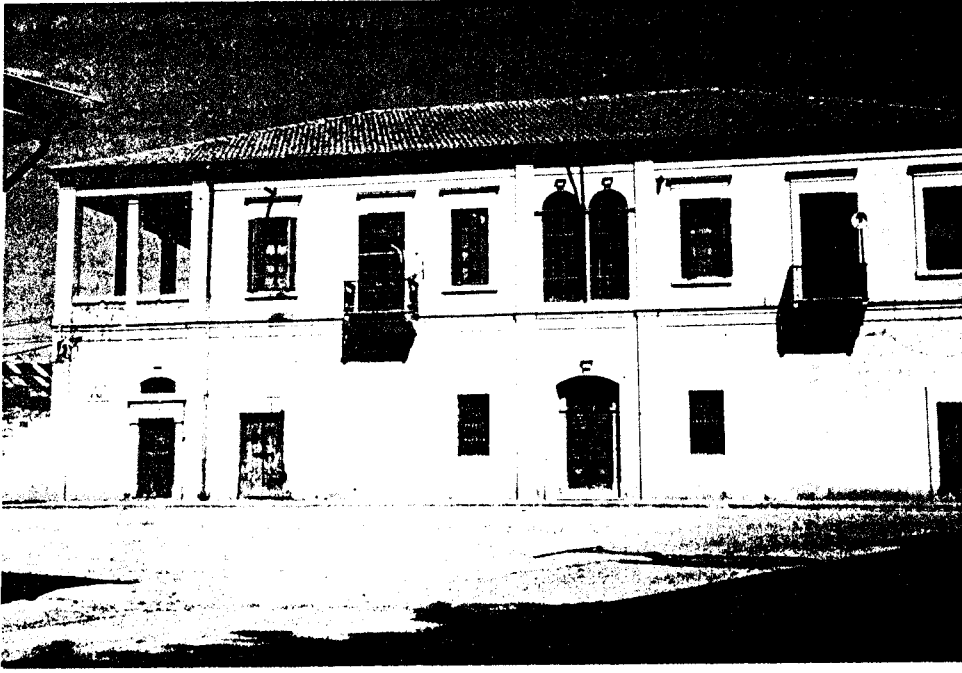
Şekil A.1.5 Sadık Paşa Konağı
