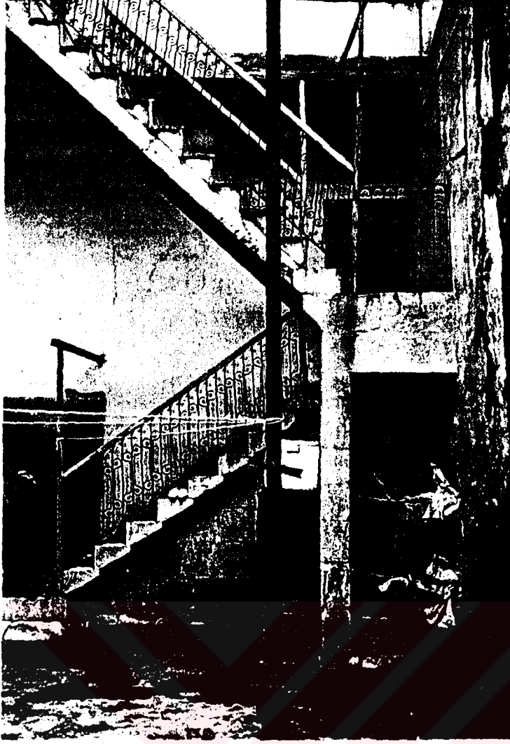
Şekil A. 2. 179. 42. Sokak No: 121 hayata ulaşan merdiven
