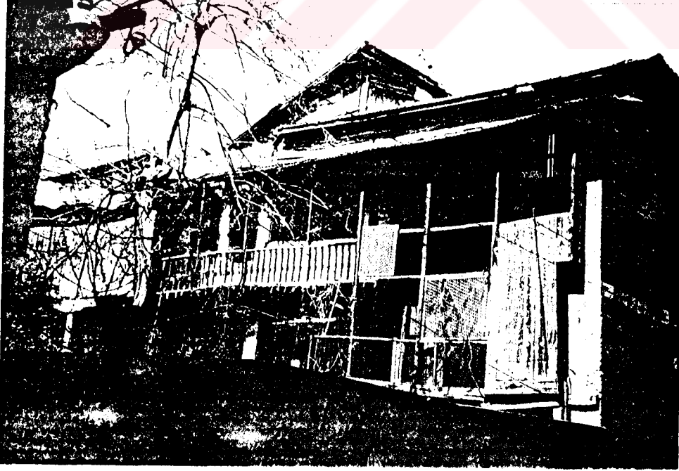
Şekil A. 2. 6. Güney cephesi, üst kat gezinti
