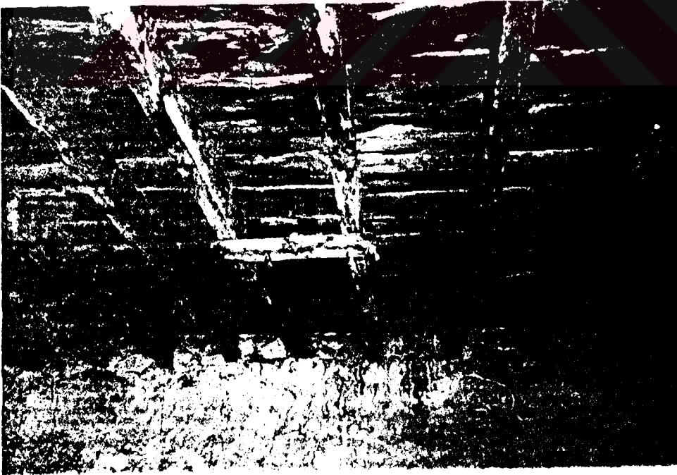
Şekil A. 2. 19. Zemin kat Z2(Depo) ahşap kirişli tavan döşemesi
