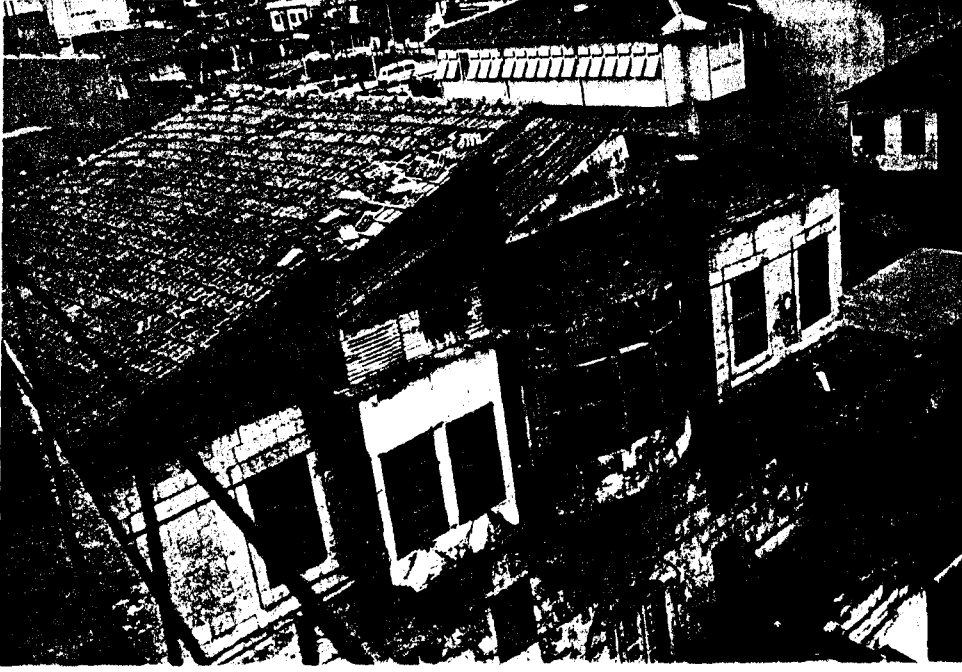
Şekil A. 2.165. Kuzey cephesi
