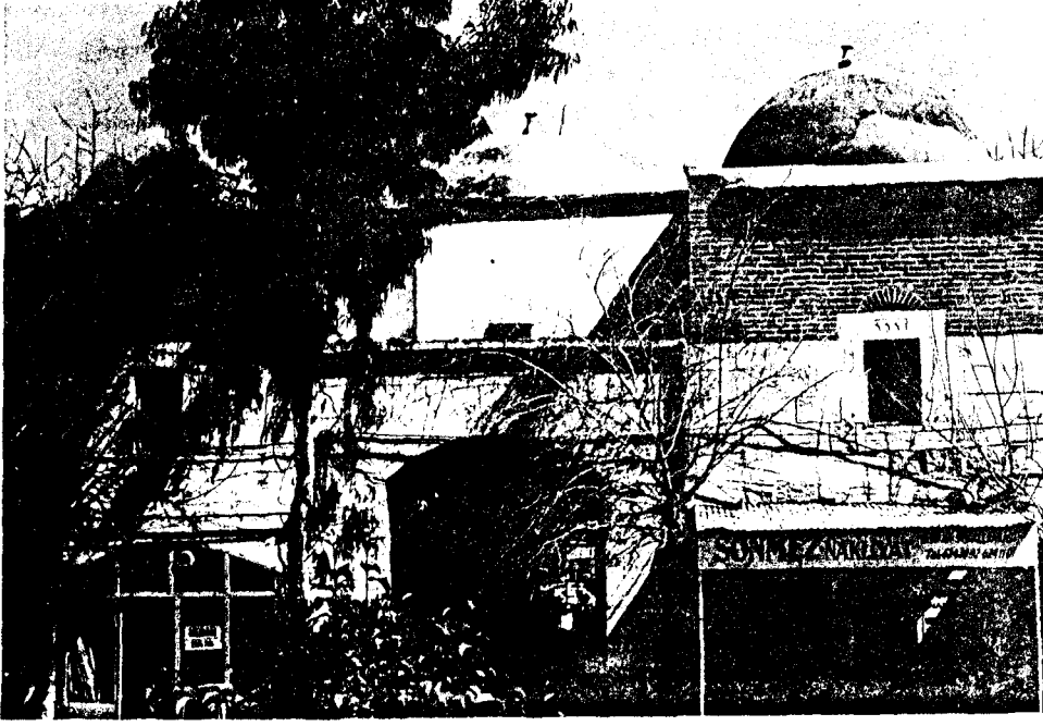
Şekil A.1.19 Kırkkaşık Bedesteni ve doğu cephesi
