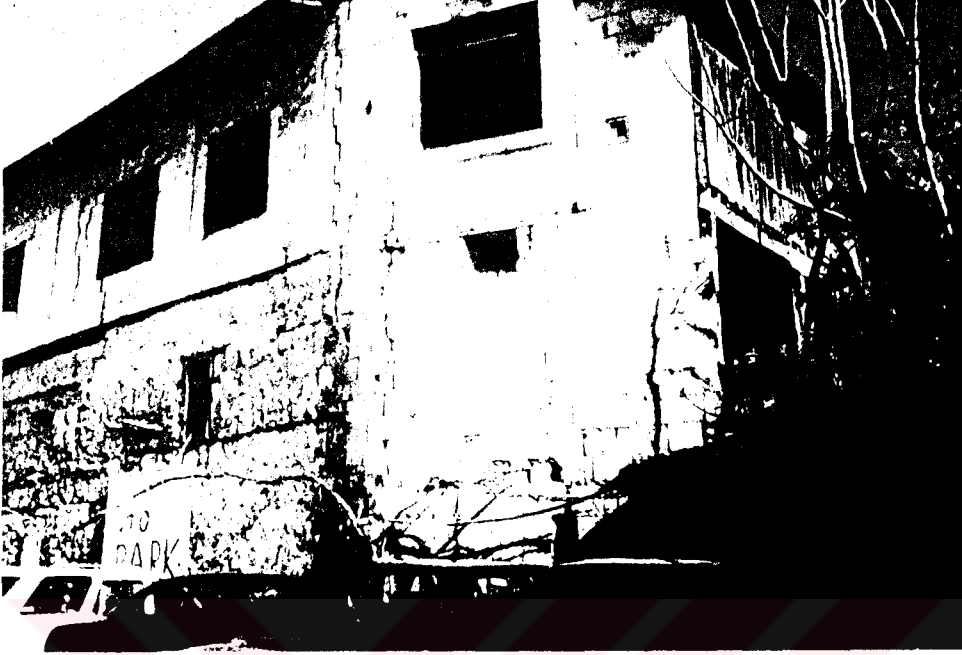
Şekil A. 2. 149. Batı cephesi
