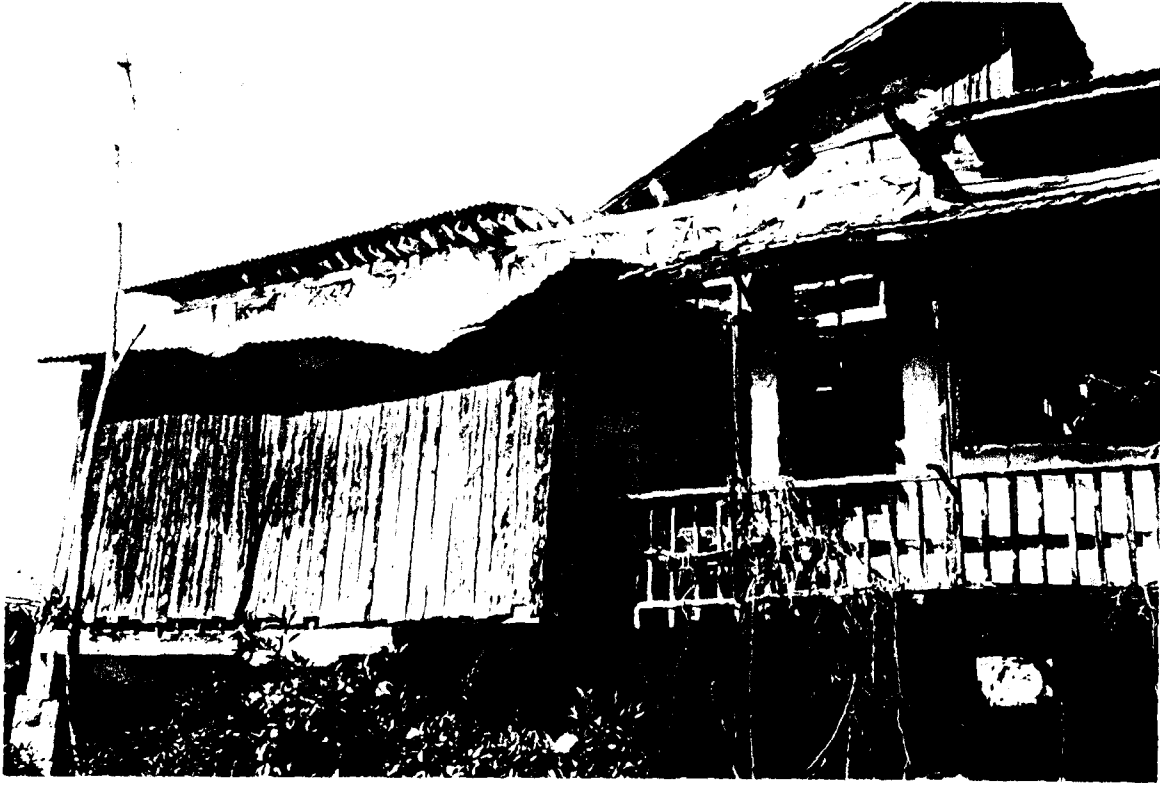
Şekil A. 2. 135. Üst kat Ü16(Gezinti)'nin batı kolunun avludan görünüşü
