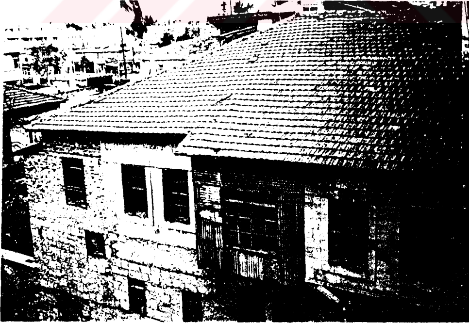
Şekil A. 2. 156. Doğu cephesi
