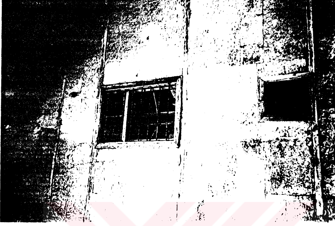
Şekil A. 2. 37. Kuzey cephesi, zemin kat Z8(Helâ) penceresi ve kapatılmış pencere boşluğu
