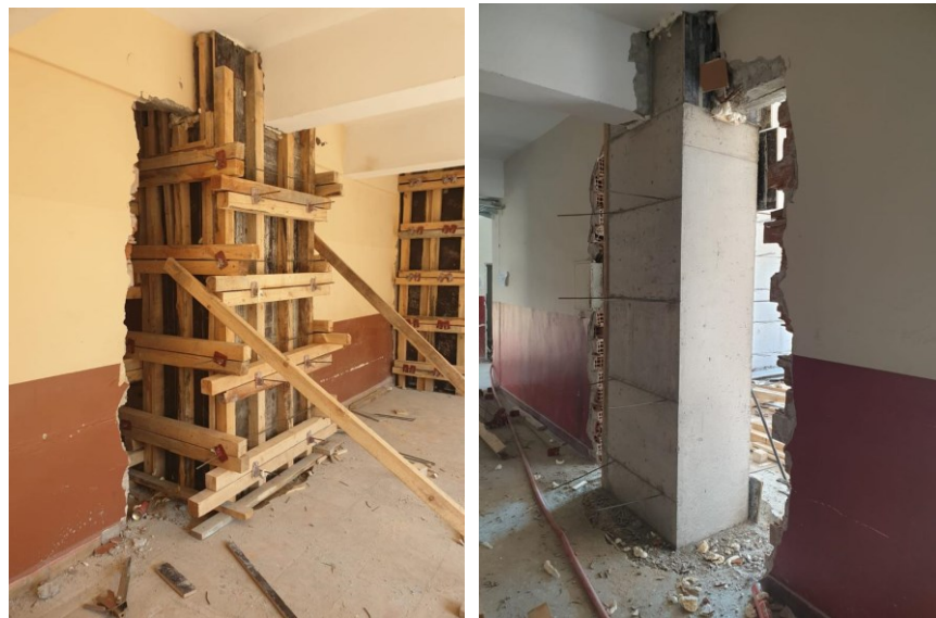
Şekil 6.9. Kolon manto imalatı
