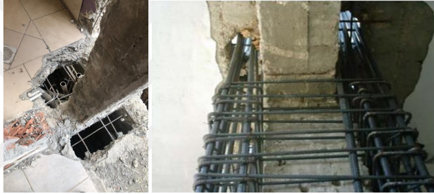
Şekil 6.8. Kolon manto imalatı (2. Resim (Öncü, 2011))
