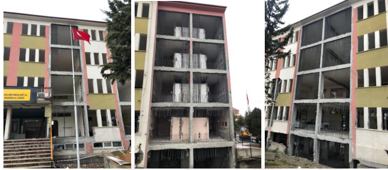
Şekil 6.1. Çerçeve düzlemine betonarme perde eklenmesi donatı imalatı (uzak görünüm)
