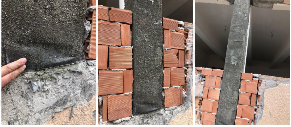
Şekil 6.11. Kolona FRP sarılması imalatı
