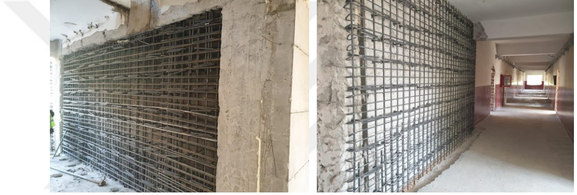
Şekil 6.5. Çerçeve düzlemine betonarme perde mantosu eklenmesi imalatı
