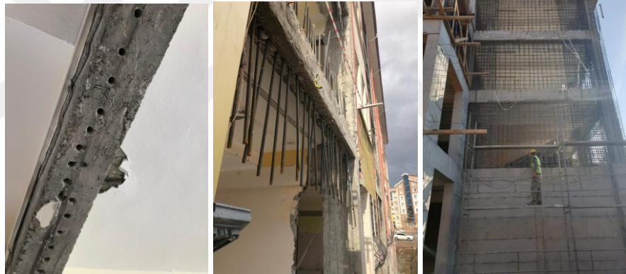
Şekil 6.2. Çerçeve düzlemine betonarme perde eklenmesinde donatı imalatı (yakın görünüm)
