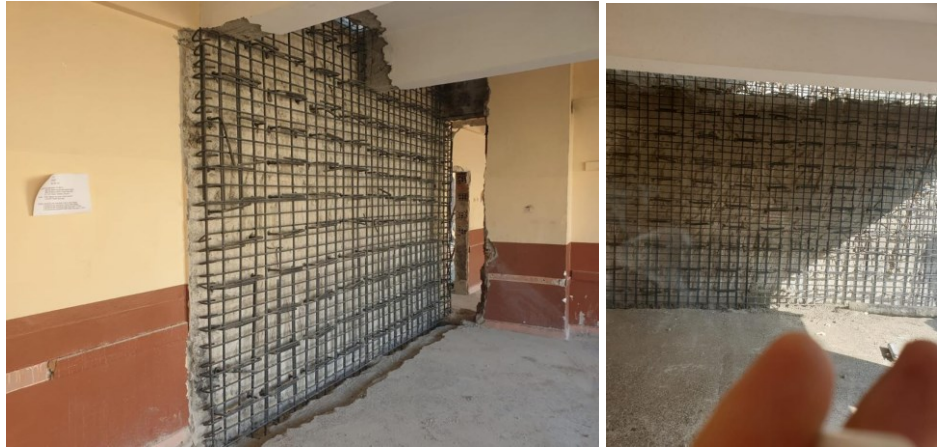
Şekil 6.6. Çerçeve düzlemine betonarme perde mantosu eklenmesi imalatı
