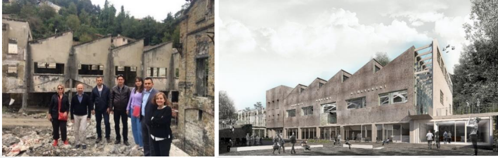
Şekil 5.36 Atölye binası röleve ve restorasyon sonrası durumu (Müdahale Kararları ve Restorasyon Raporu).
