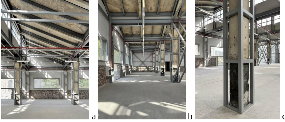
Şekil 5.40 Atölye binası çağdaş ek çelik taşıyıcı sistem (a), kiriş (b), kolon (c) desteklemeleri ve çapraz elemanlar (Cansız A.U, 2025).
