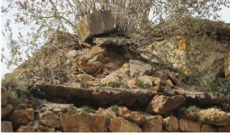
Ek-22. Yozgat Başçavuş Hamamı Kadınlar Bölümü Üst Örtü-Duvar
