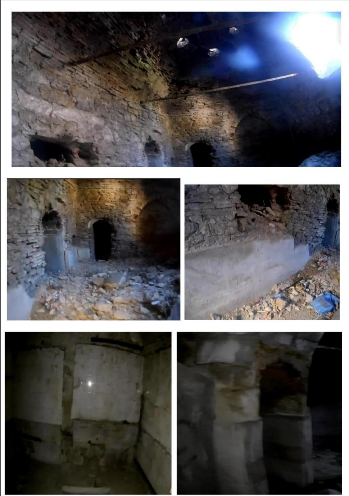
Ek-28. Yozgat Başçavuş Hamamı İç Mekanlardan-Kadınlar Bölümü
