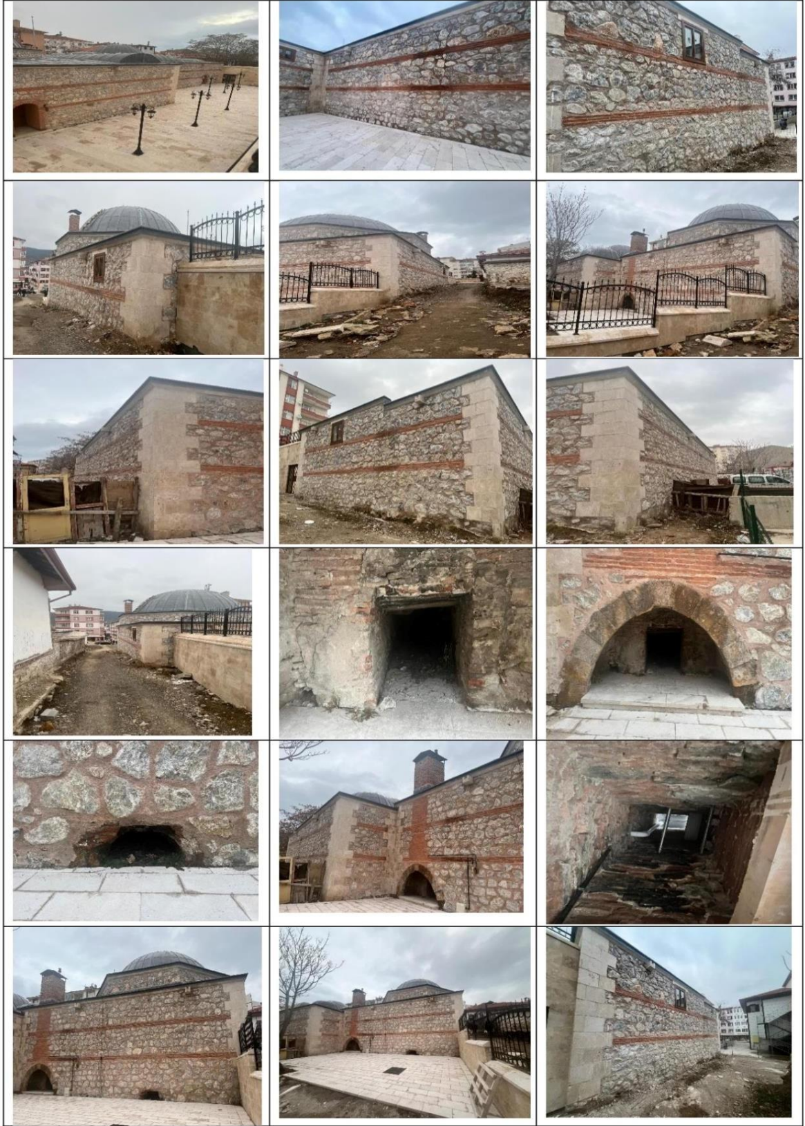
Ek-31. Yozgat Başçavuş Hamamı Restorasyon Sonrası Görselleri (Dış Görünüş),
