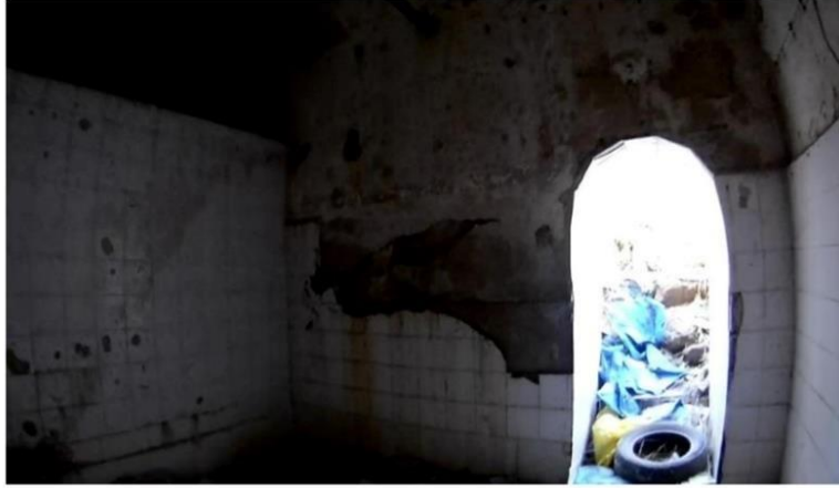
Ek-29. Yozgat Başçavuş Hamamı İç Mekanlardan-Kadınlar Bölümü
