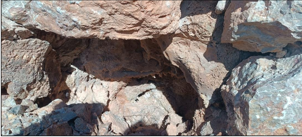
Şekil 4. 21. İnceleme alanında gözlenen karstik boşluklardan bir görünüm
