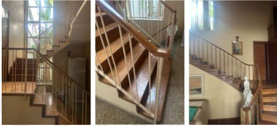
Şekil 47. Sadıkoğlu Yalı Köşkü Ana Merdiven ve Hizmet Holü Merdivenleri (Yazar, 2023)
