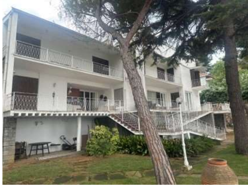
Şekil 50. Sadıkoğlu Yalı Köşkü Denize bakan cepheden bir görünüş (Yazar, 2023)
