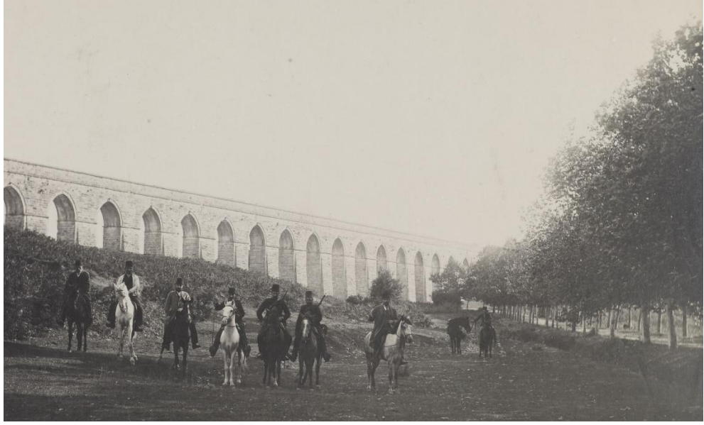
Şekil 3.37 : Bendlere giden çınarlı yol
