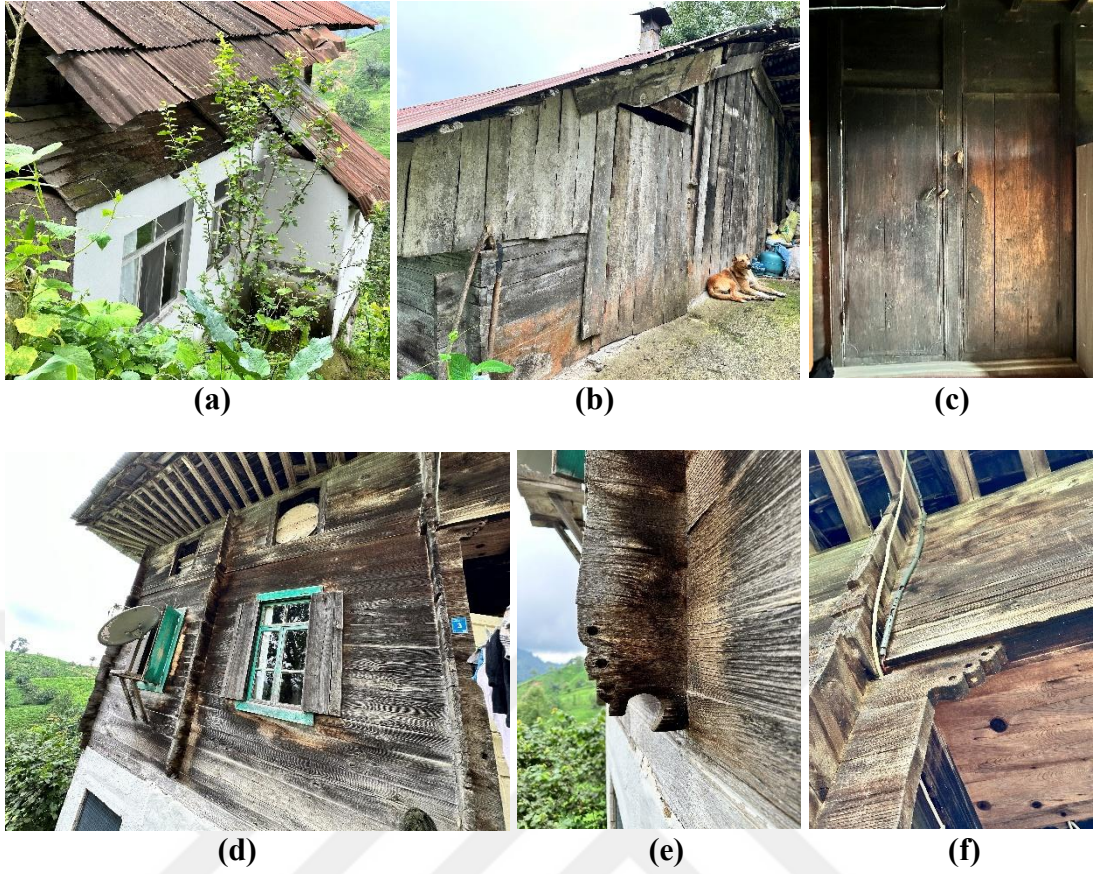
Şekil 4.35: (a)Genişletilmiş yan odaların dışarıdan görünümü, (b)çatı katı girişi, (c)iç kapılar, (d) pervazlı pencereler ve metrezli çatı katı, (e)(f) dış cephe süslemeleri [Beyza Yangın arşivi, 2024].
