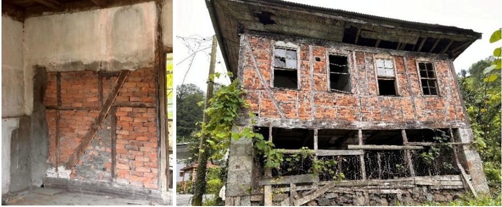
Şekil 3.50: Tuğla dolgulu hımiş sistem kullanılan bir ev (Seslikaya Köyü) [Beyza Yangın arşivi, 2024].
