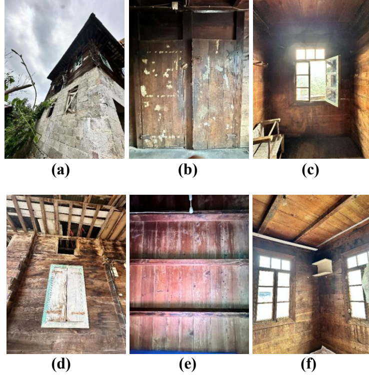
Şekil 4.9: (a) Yenilenen bodrum kat duvarı, (b) iç kapılar, (c) koridordan dışarıya bakan pencere, (d) panjur kullanımı ve meterez, (e) tavan kaplaması, (f) ahşap duvar ve tavan uygulaması [Beyza Yangın arşivi, 2024].
