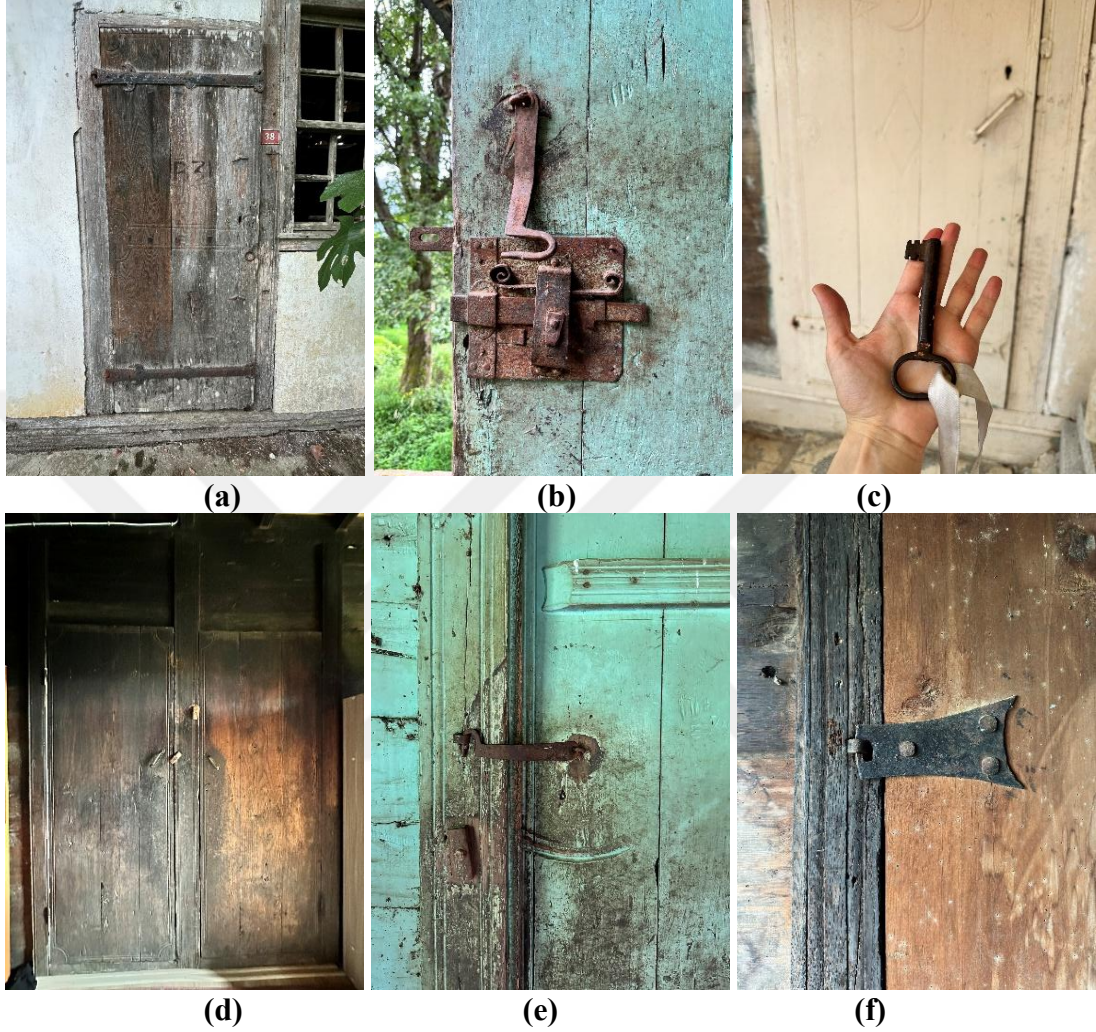
Şekil 3.37: (a) Dış kapı, (b) dış kapı kilidi, (c) dış kapı anahtarı, (d) iç kapı, (e) iç kapı kilidi, (f) iç kapı menteşesi [Beyza Yangın arşivi, 2024].
