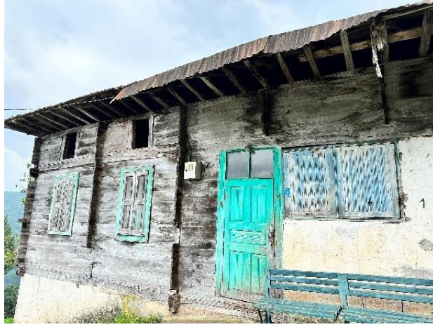
Şekil 3.44: Ahşap yığma yerel konut (Yeniköy Köyü) [Beyza Yangın arşivi, 2024].
