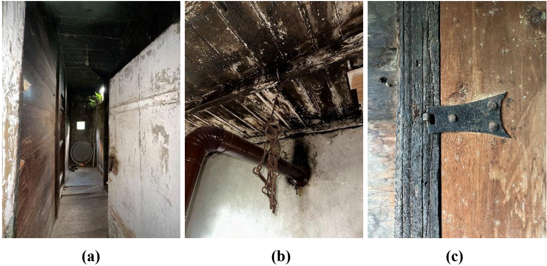
Şekil 4.15: a)Banyo holü, (b) soba borusu ve klemuri, (c) demir kapı menteşesi, (d) soba bacasının dışarıdan görünümü ve çatı arası girişi, (e) iç kapı kilidi, (f) panjurlu pencere [Beyza Yangın arşivi, 2024].
