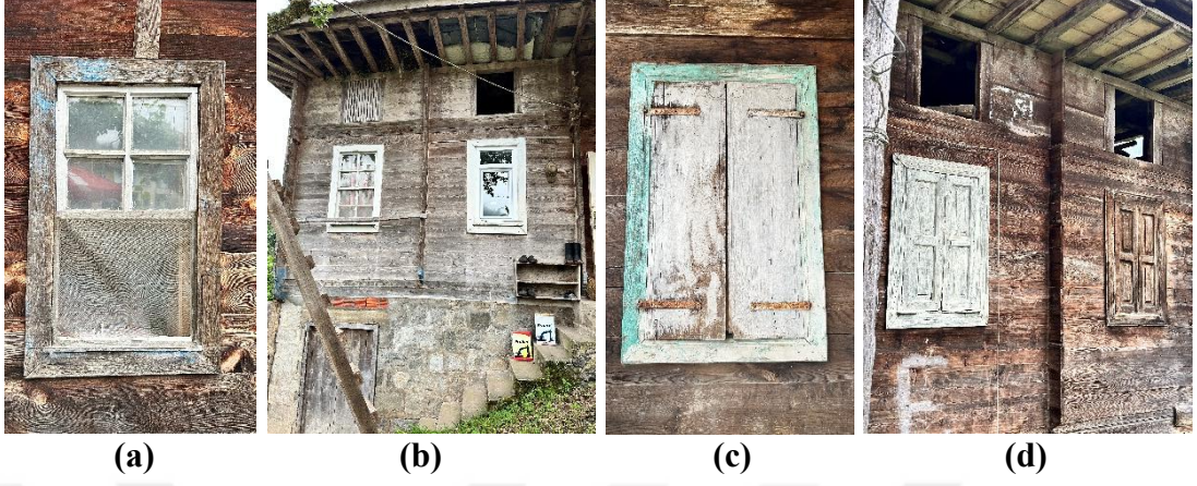
Şekil 3.38: (a) Giyotin pencere, (b) özgün giyotin pencere ve muhdes modern kanatlı pencere, (c)(d) panjurlu pencereler [Beyza Yangın arşivi, 2024].
