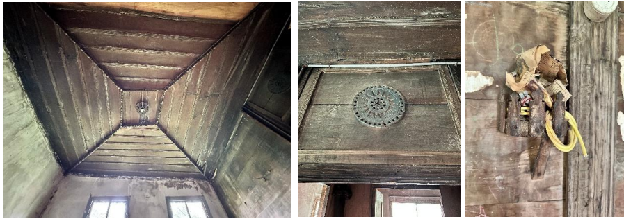
Şekil 4.27: Hakkı Ocağı Evi ahşap işçilikleri [Beyza Yangın arşivi, 2024].
