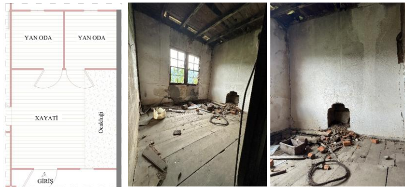
Şekil 3.21: Planda yan oda ve şömineli bir yan oda (Pirinçlik Köyü) [Beyza Yangın arşivi, 2024].
