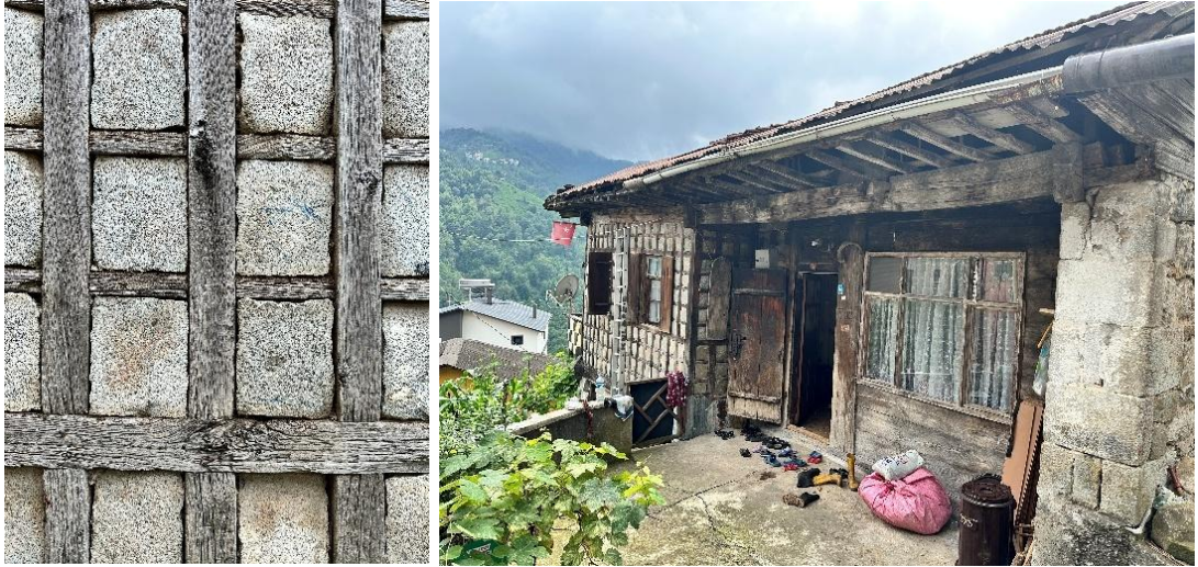
Şekil 3.48: Göz dolma tekniği kullanılmış bir ev (Aşağıdurak Köyü) [Beyza Yangın arşivi, 2024].
