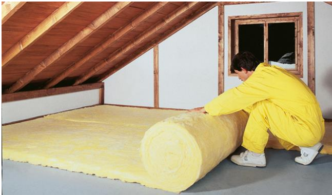
Şekil 2.5 Çatılarda ısı yalıtım uygulaması (URL- 5, 2025)
