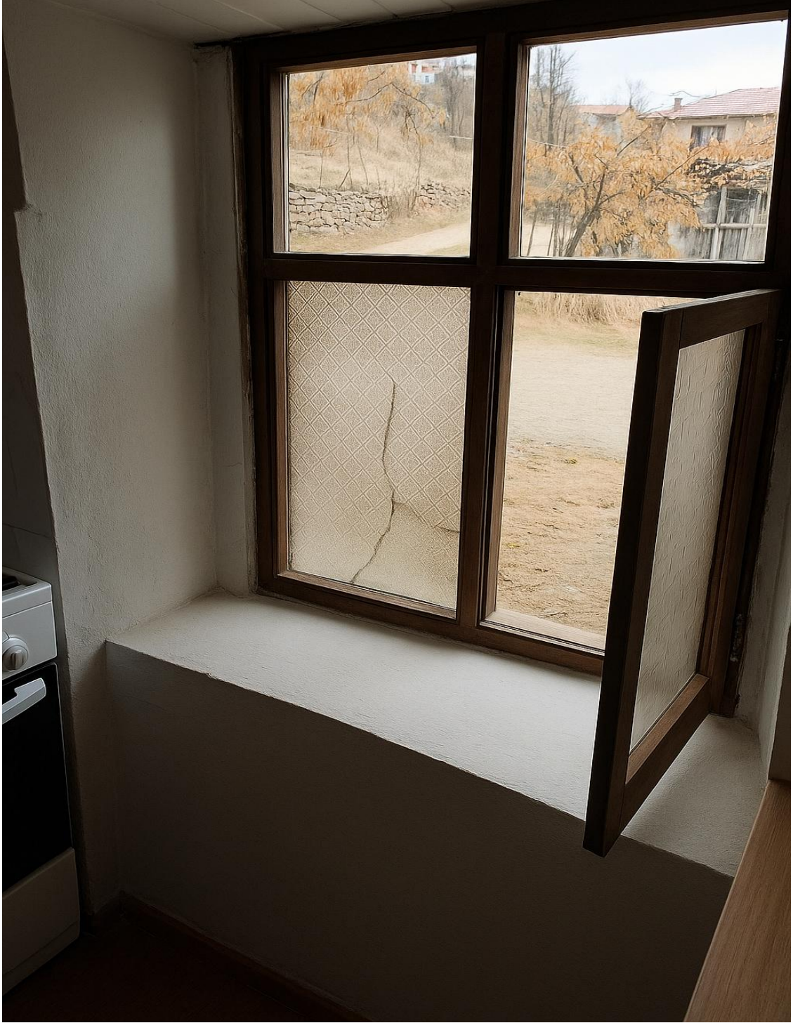
Fotoğraf 6.8. Çeralan Mahallesiinde Soğuşun Etkisinden Korunmak İçin Yapılmış Kalın Duvarlara Örnek Bir Mesken
