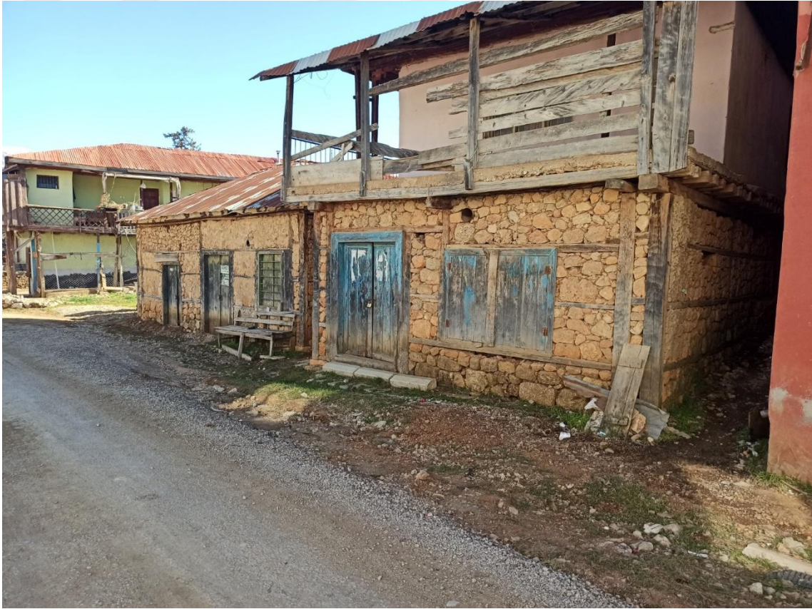
Fotoğraf 6.7. Ayvacık Mahallesiinde Isı Yalıtımı Sağlamak Amacıyla Yapılmış Bir Mesken. Ayrıca Yoğun Kar Birikimini Önlemek İçin Yapılmış Eğimli Bi Çatı Örneği De Görülmektedir.
