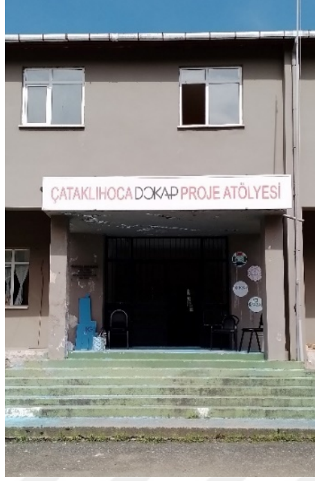
Şekil 2.23. Çataklihoca DOKAP Proje Atölyesi, Rize -Çayeli
